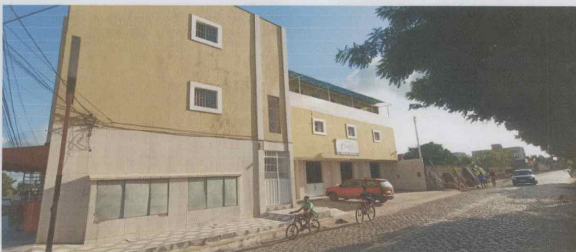
Foto da frente do prédio.
