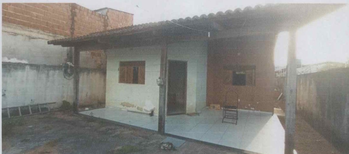
Vista da garagem do imóvel
