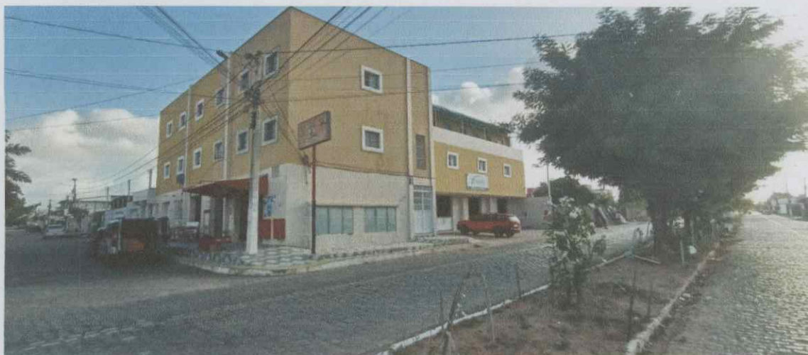
Foto da frente do prédio.
