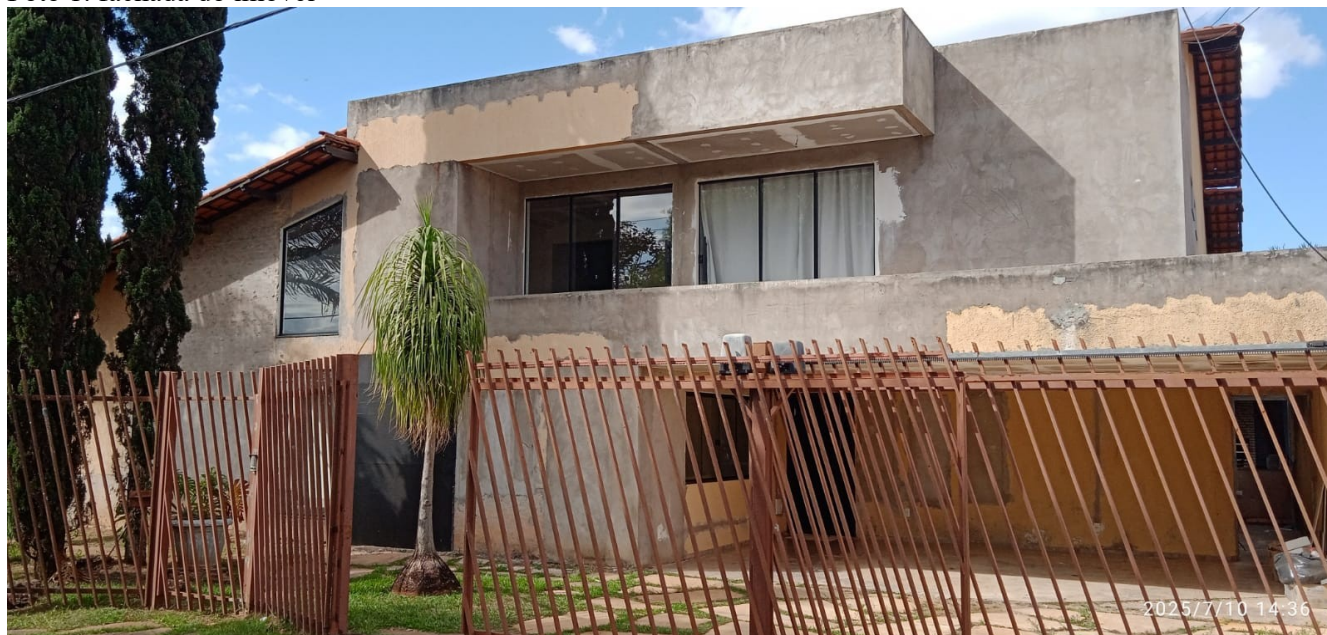
Foto 1: fachada do imóvel
