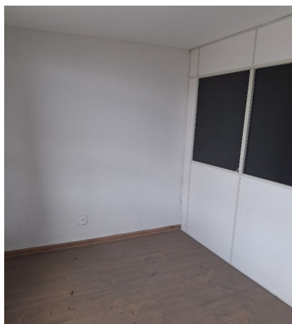
(figura 19 – segunda parte da sala 2001 com divisória)
