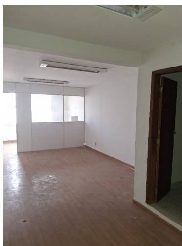
(figura 1 – entrada da sala 2004)
