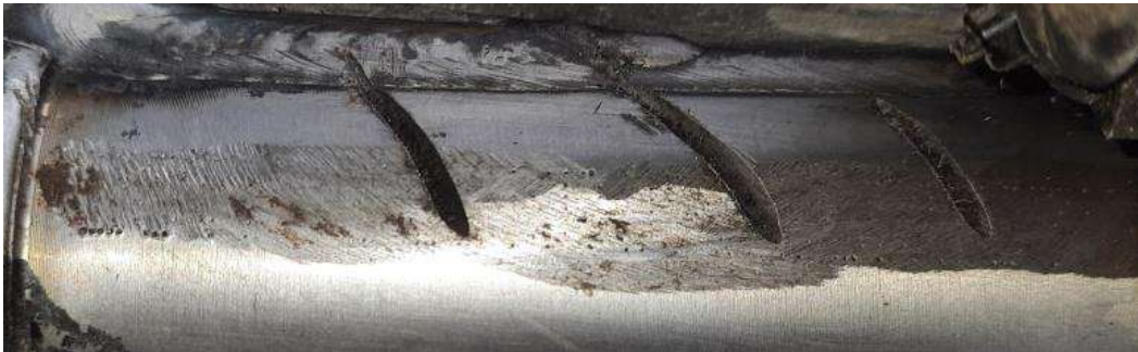
Fotografia ilustrativa 02 – Mostra detalhes do local da gravação do NIV totalmente danificado.
