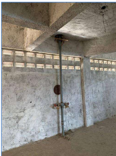
Figura 11 – Instalação de tubulação (Combate a incêndio)
