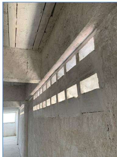
Figura 12 – Cobogó de ventilação
