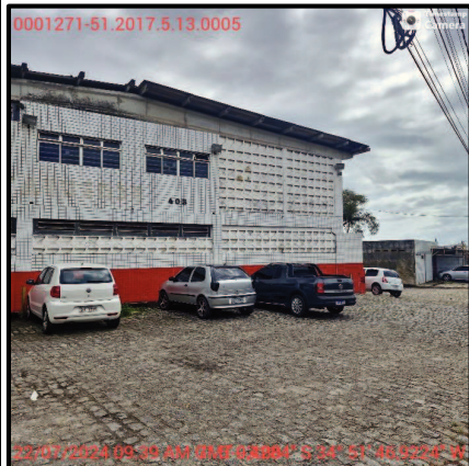
Foto 1 – Vista da fachada frontal e fachada lateral.
