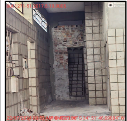
Foto 20 – Vista da área das escadas do imóvel 1.
