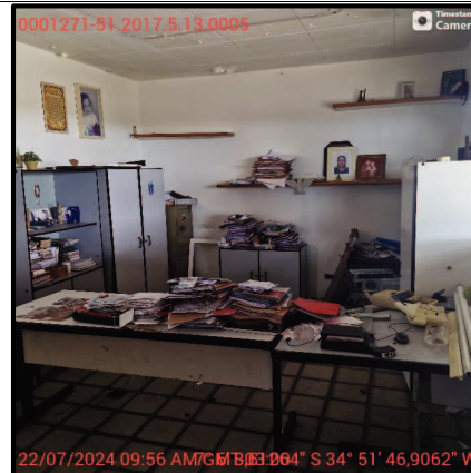
Foto 11 – Vista de outra sala do 1º pavimento do imóvel 1.
