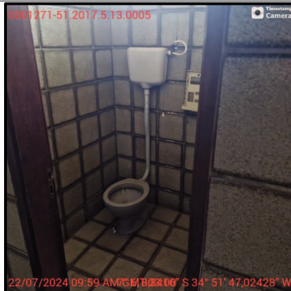
Foto 9 – Vista do banheiro do imóvel 1
