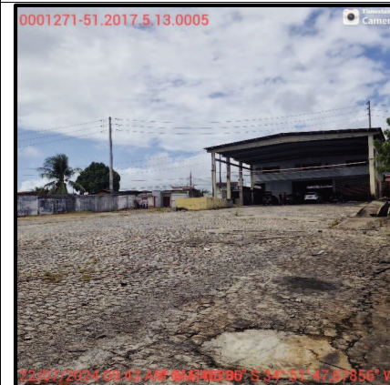
Foto 5 – Vista da fachada do imóvel 1 de dentro do terreno.
