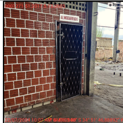
Foto 19 – Vista da entrada de sala do pavimento térreo do imóvel 1.
