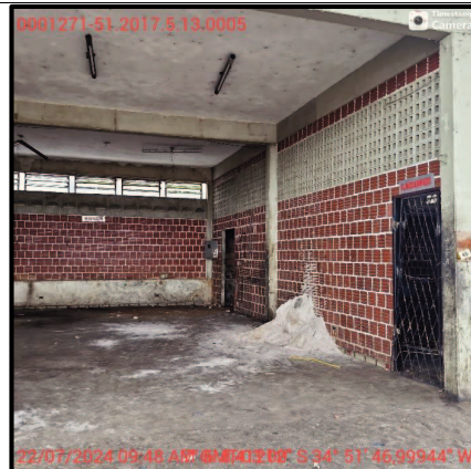
Foto 14 – Outra vista da área do pavimento térreo do imóvel 1.
