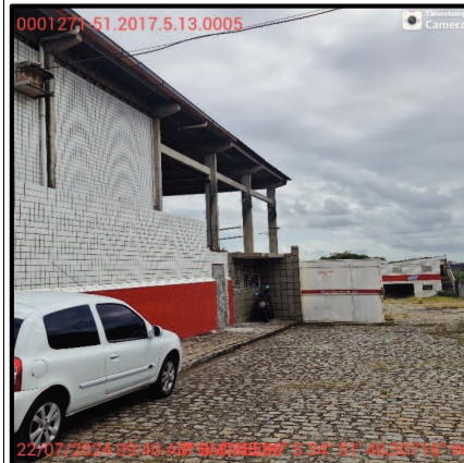
Foto 2 – Vista da fachada lateral.
