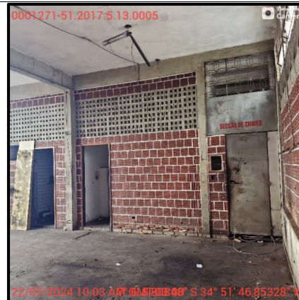
Foto 15 – Vista da entrada das salas do pavimento térreo do imóvel 1.
