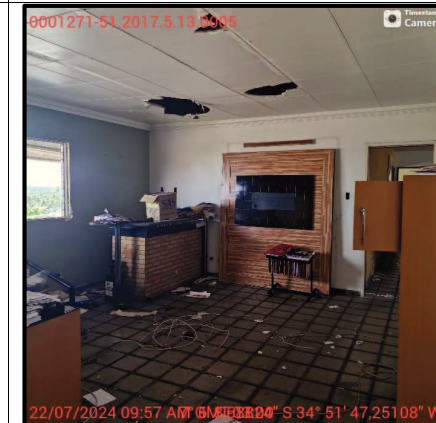
Foto 8 – Vista de uma das salas do imóvel 1 no 1º pavimento.
