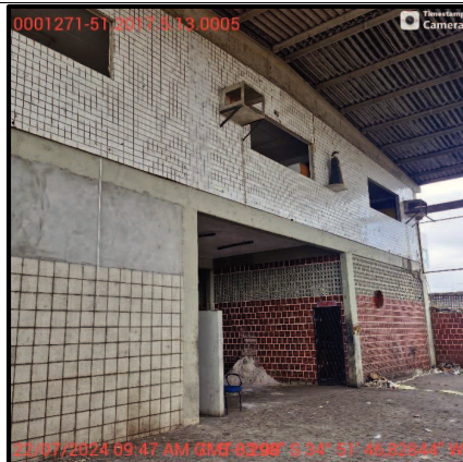
Foto 13 – Vista da área do pavimento térreo do imóvel 1.
