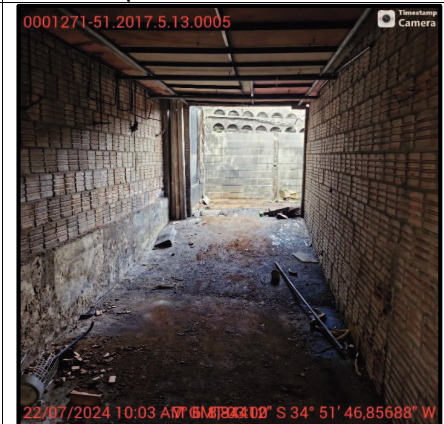
Foto 16 – Vista de área do pavimento térreo do imóvel 1.
