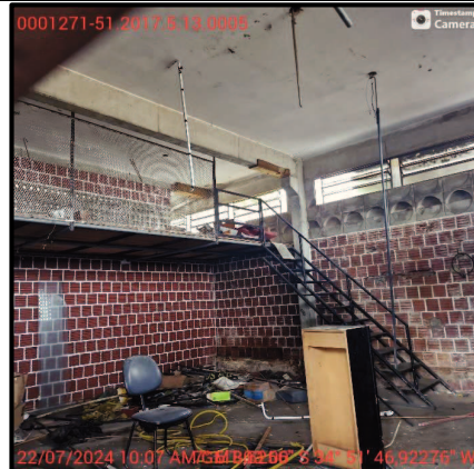
Foto 18 – Vista interna da sala do imóvel 1 no pavimento térreo.
