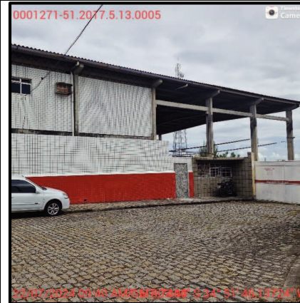
Foto 3 – Outra vista da fachada lateral do imóvel 1.
