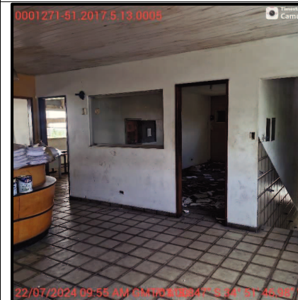
Foto 7 – Vista da parte do 1º pavimento do imóvel 1
