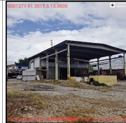
Foto 4 – Vista da fachada de atrás do imóvel 1.
