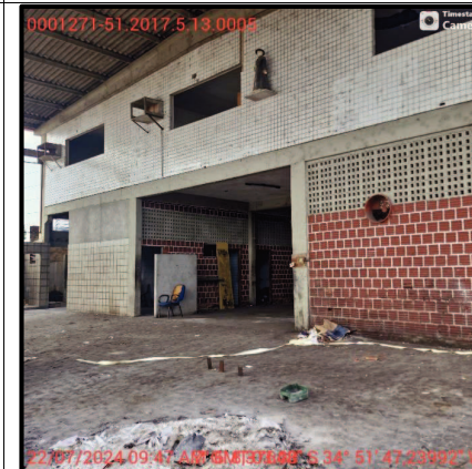
Foto 6 – Outra vista da fachada do imóvel 1 embaixo da área coberta.
