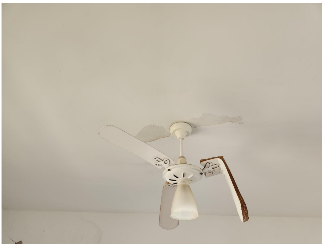
Pintura do teto danificada ao redor do ventilador.
