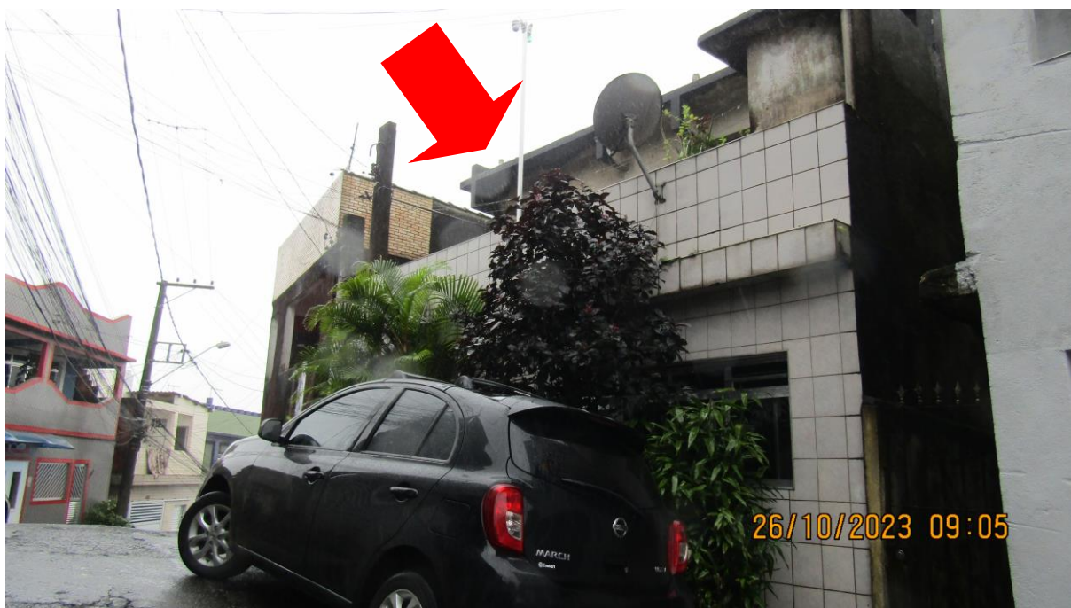
Foto 4 – Outra vista da fachada do imóvel avaliando.
