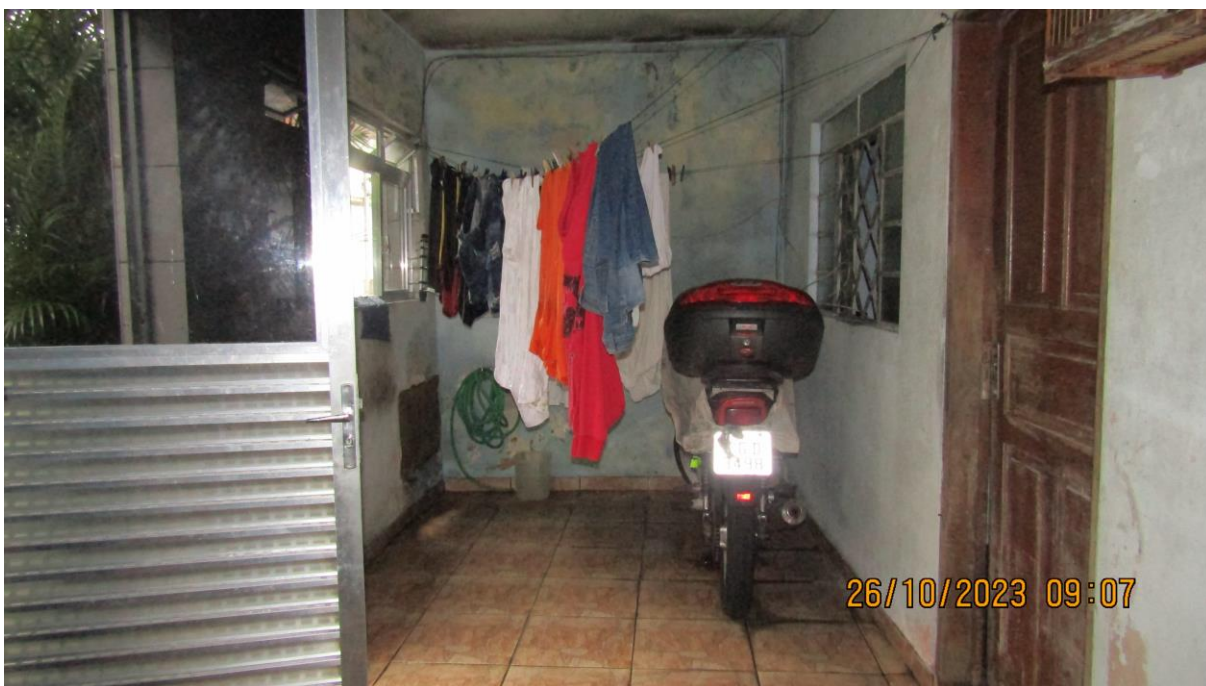
Foto 7 – Detalhes da varanda do imóvel avaliando.
