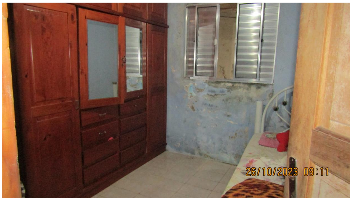
Foto 13 – Detalhes do dormitório 2, localizado na parte da lateral direita do imóvel.
