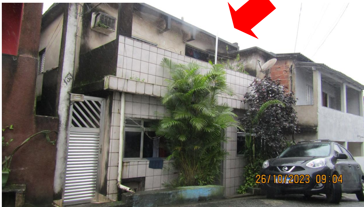
Foto 3 – Vista da fachada do imóvel avaliando.
