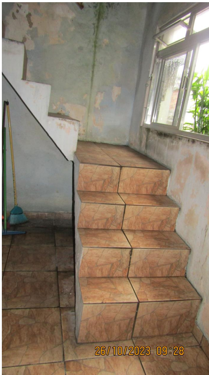
Foto 9 – Detalhes da escada de acesso ao pavimento superior.
