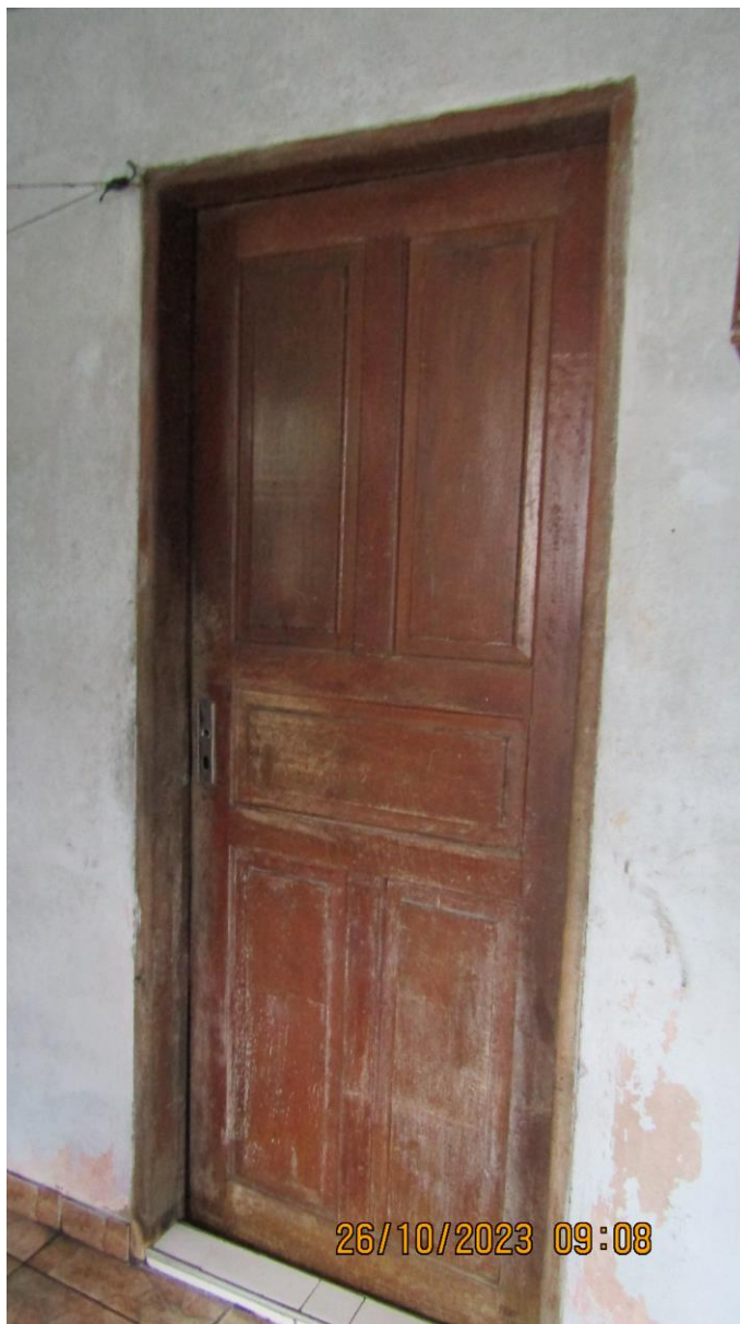
Foto 10 – Detalhes da porta de acesso à sala do imóvel avaliando.
