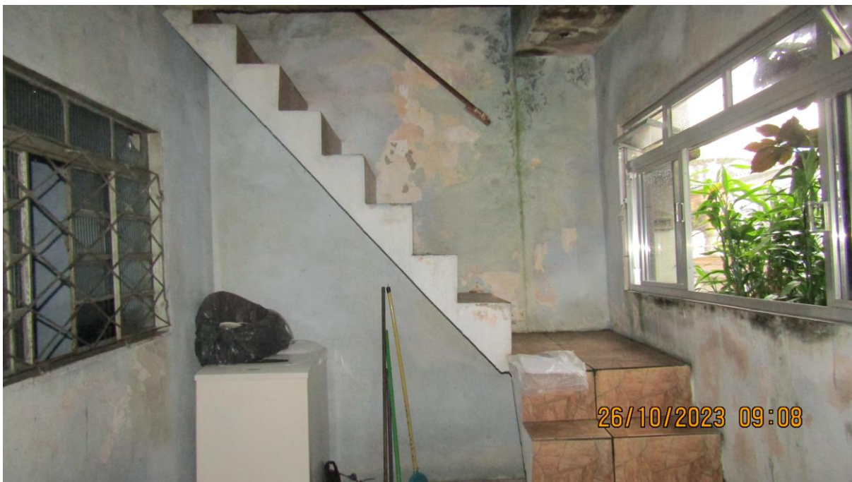
Foto 8 – Outra vista da varanda do imóvel avaliando. Note-se a escada de acesso ao pavimento superior.
