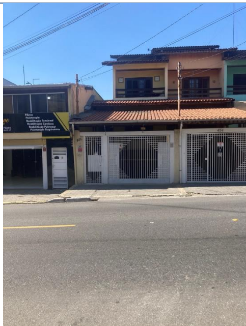
11 – Vista do imóvel avaliando.
