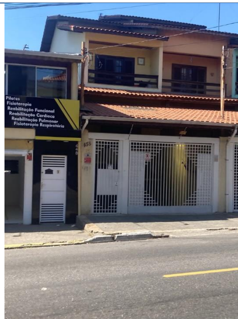
12 – Vista do imóvel avaliando.
