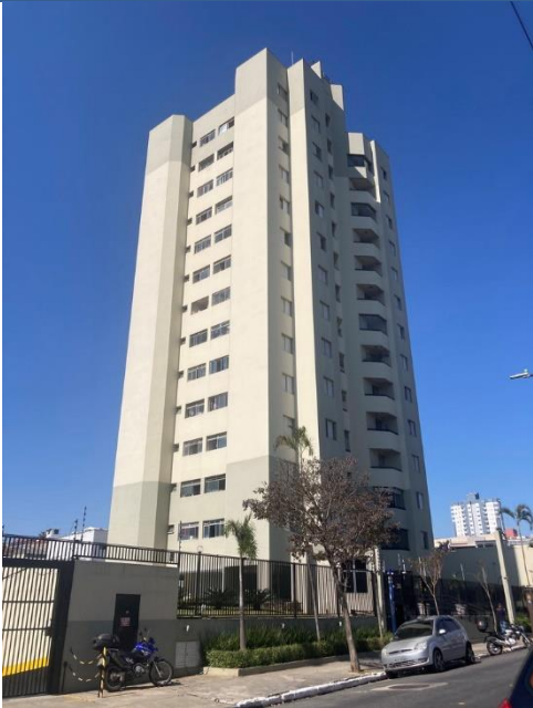
3 – Vista do Edifício Camila.
