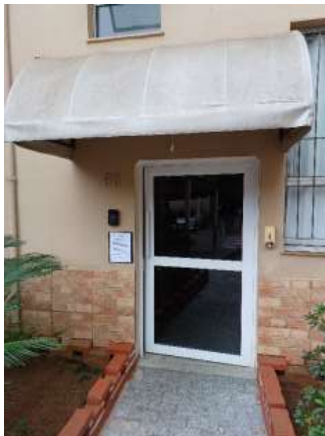
8 – Acesso do Bloco 58
