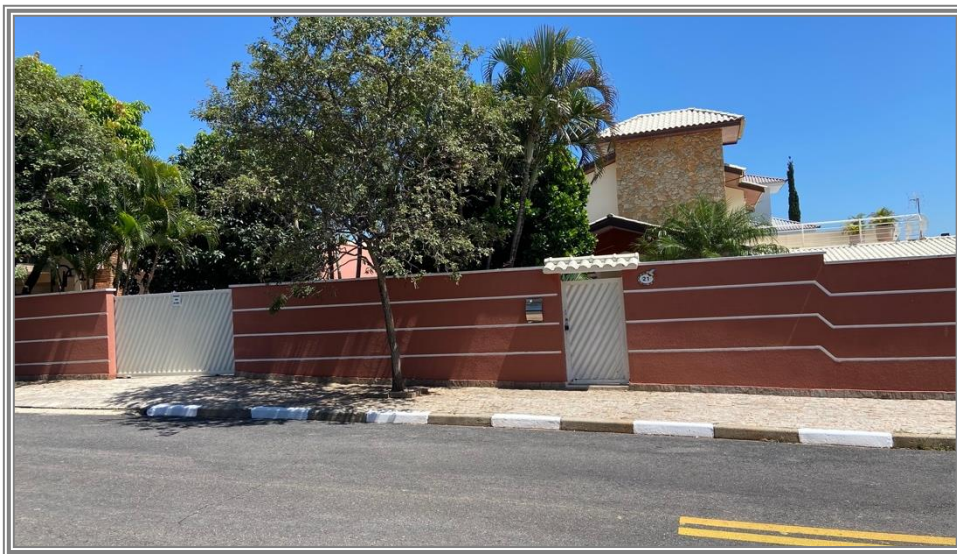
Comentário (↑): Vista da fachada do imóvel avaliando.
