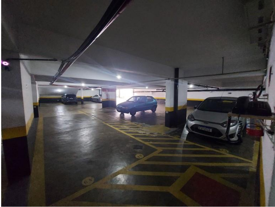
Foto 23: Áreas comuns – Garagem do 1º subsolo
