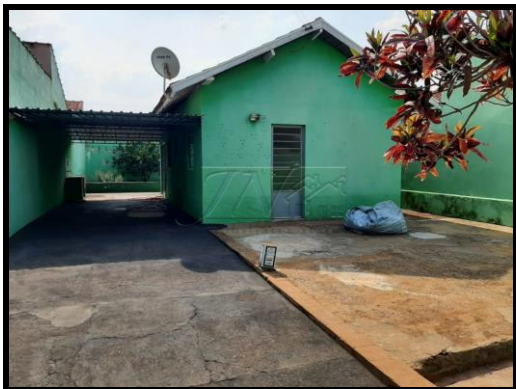
Figura 27: foto do imóvel obtida pelo site.
