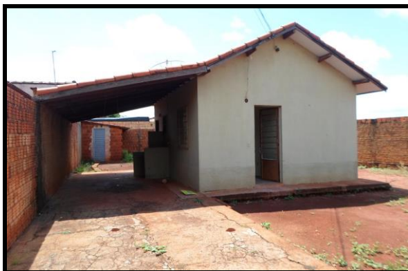
Figura 31: foto do imóvel obtida pelo site.
