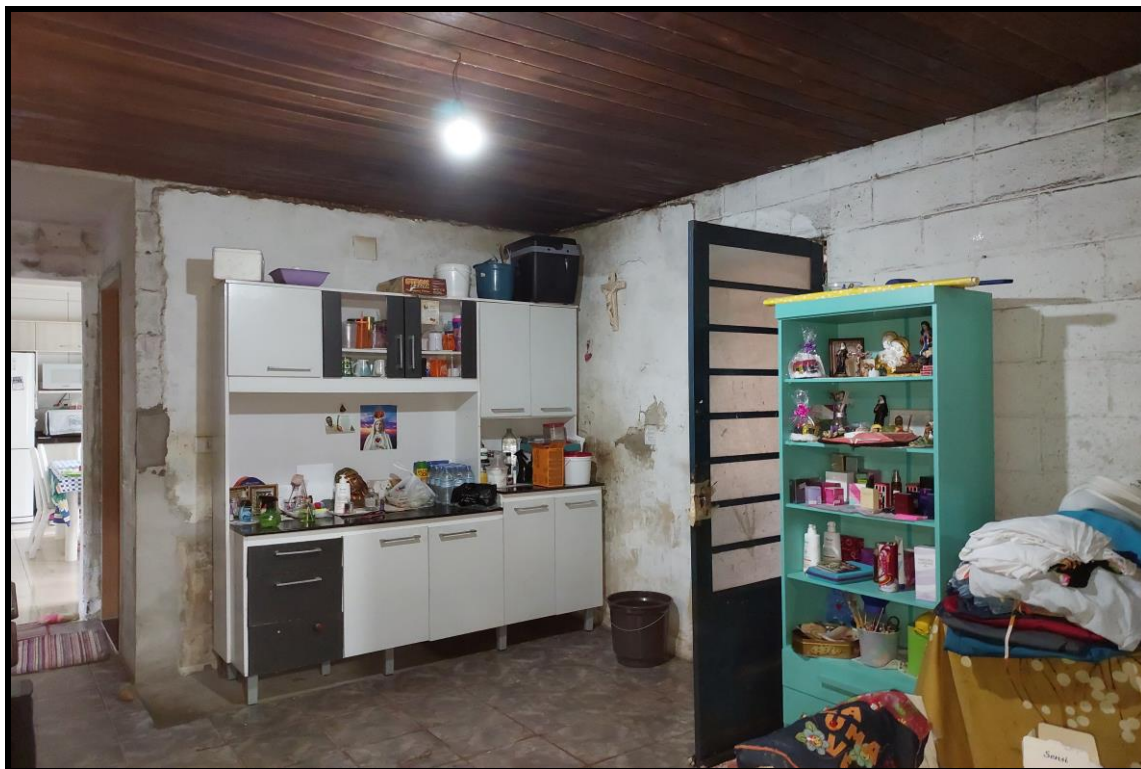
Figura 13: vista interna do imóvel.
