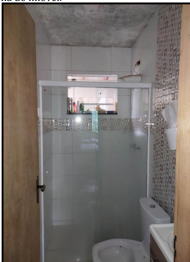
Figura 16: vista interna do imóvel.
