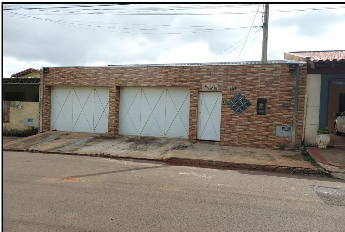
Figura 05: vista externa do imóvel.
