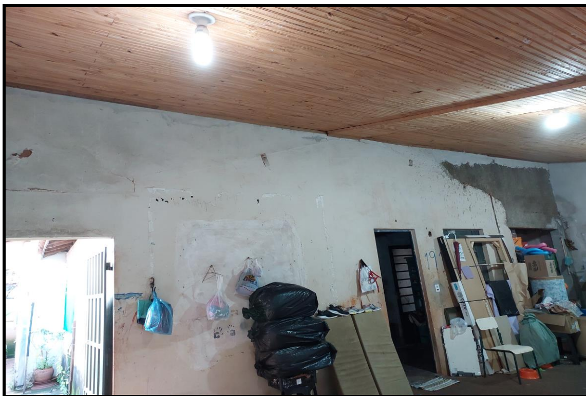
Figura 12: vista interna do imóvel.
