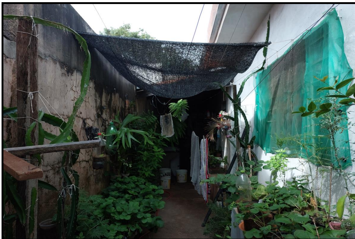
Figura 10: vista externa do imóvel.
