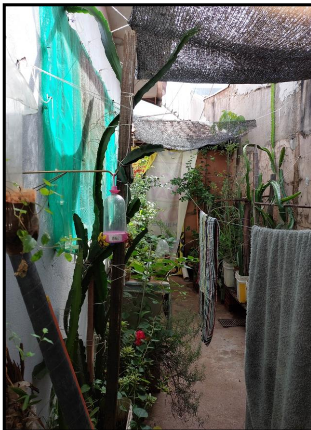
Figura 07: vista externa do imóvel.
