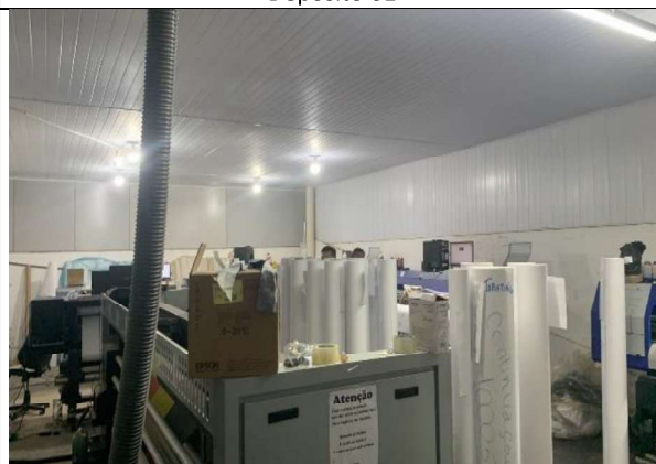
Sala de máquinas
