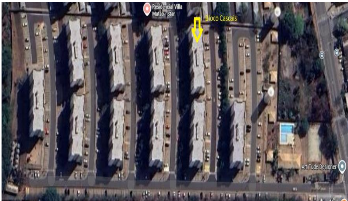
Visão do condomínio
