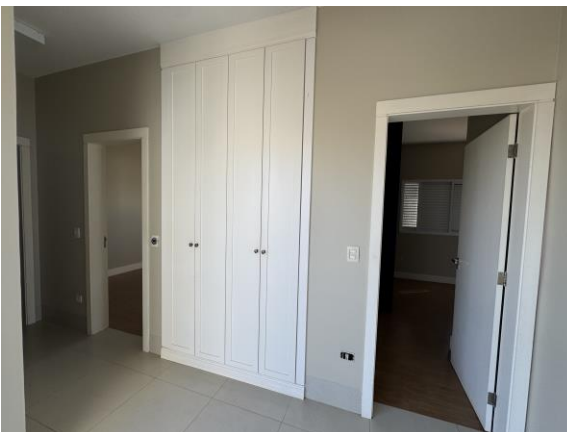
HALL DOS DORMITÓRIOS
