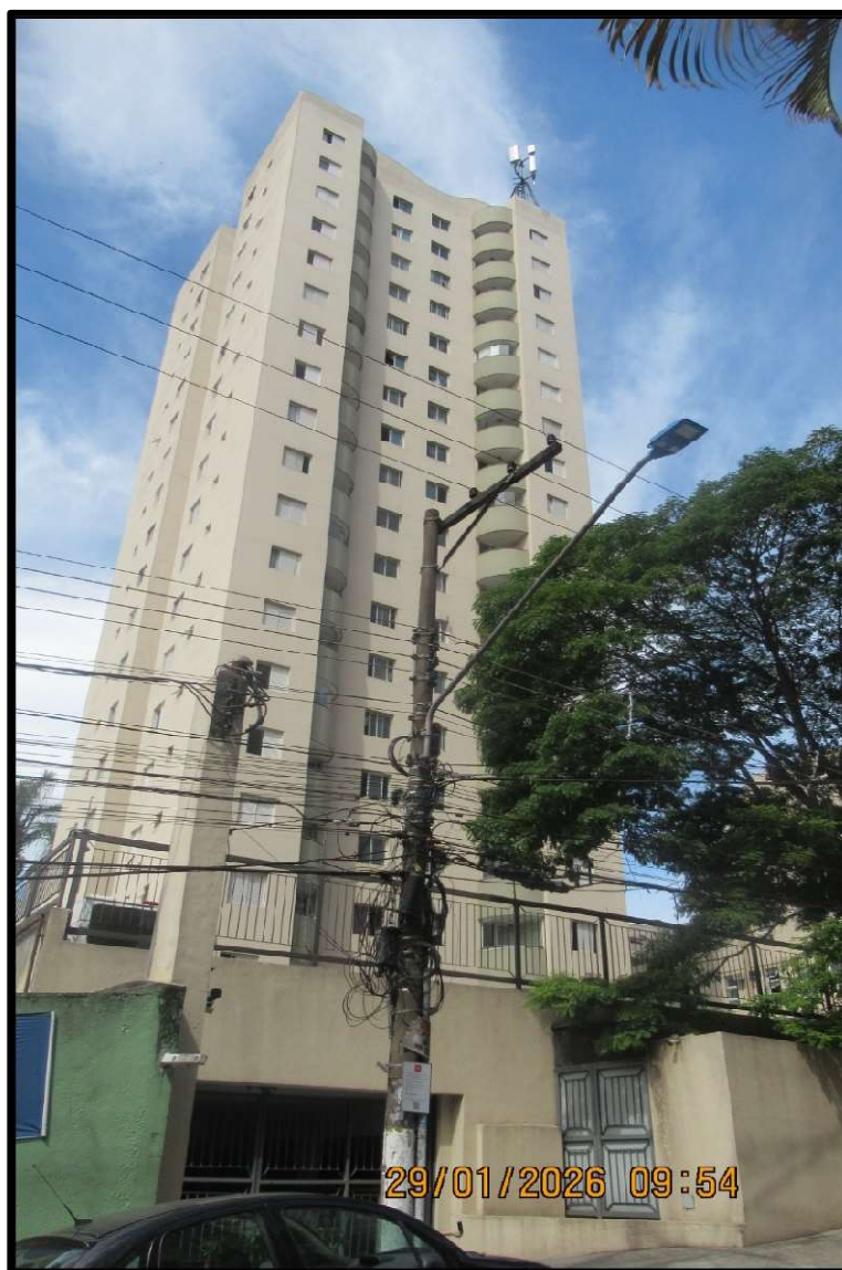
Foto nº 3: Vista do Edifício San Pietro, com acesso pelo nº 185 da Rua São Pedro.
