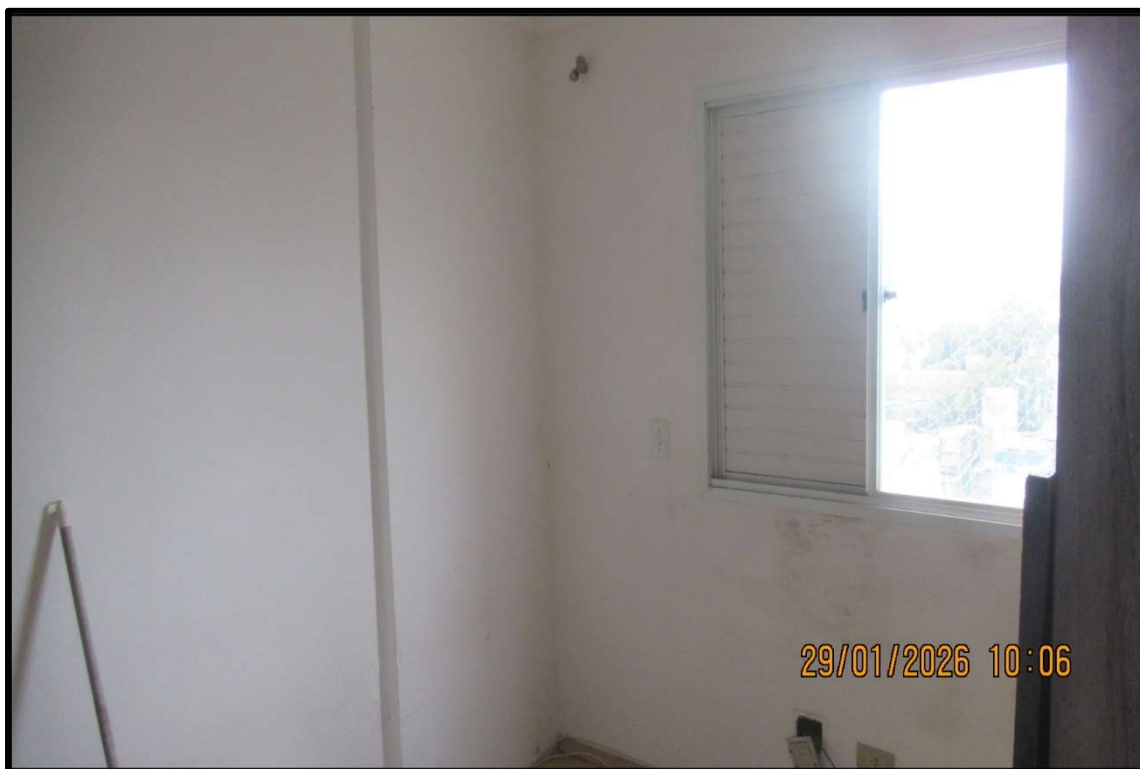
Foto nº 10: Vista de outro dormitório. Suas principais características construtivas são: piso em assoalho de madeira, paredes revestidas em massa corrida, pintadas em látex, forro em laje e esquadrias de alumínio.
