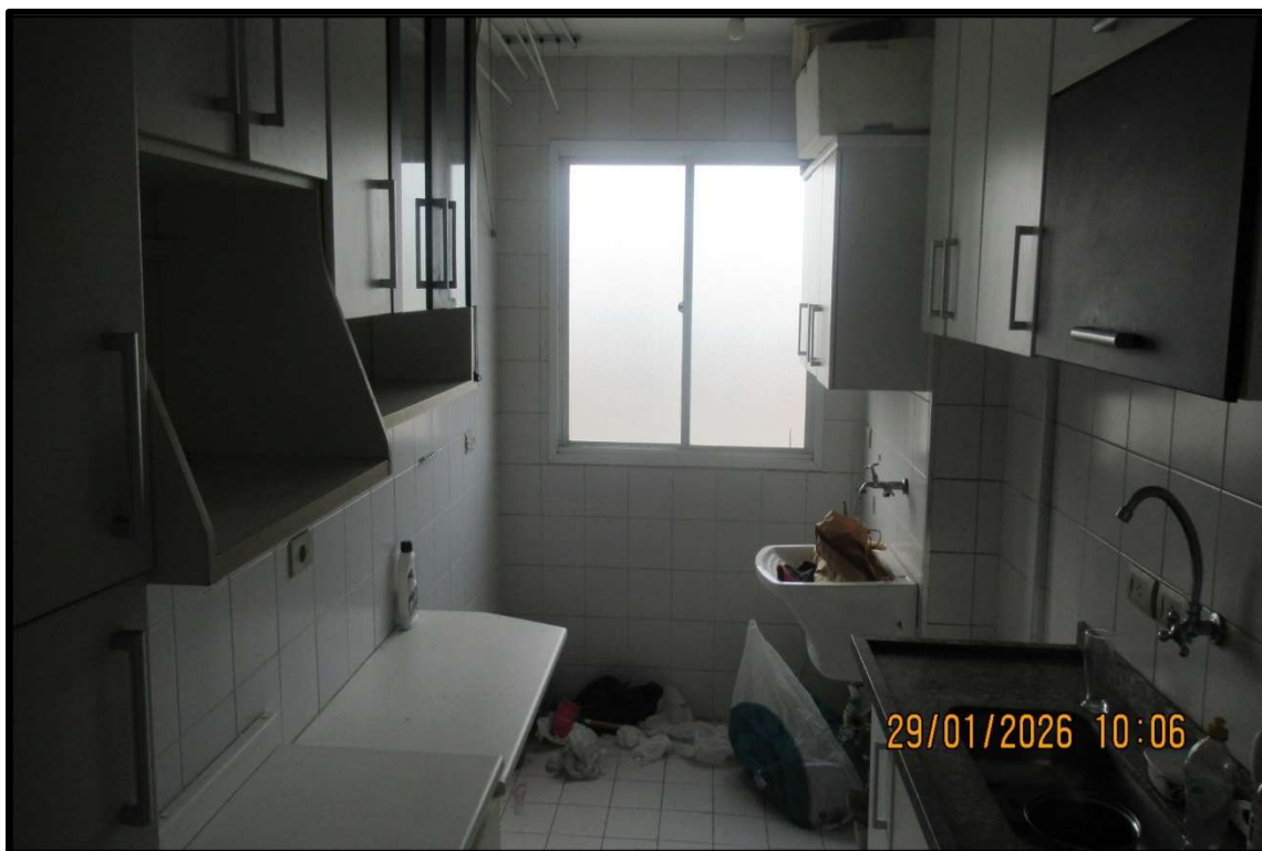
Foto nº 6: Vista da cozinha. Suas principais características construtivas são: piso cerâmico, paredes azulejadas, forro em laje e esquadrias de alumínio.
