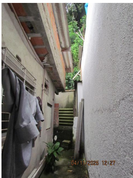
Corredor lateral e ao fundo alicve pronunciado notando área de APP com vegetação nativa
