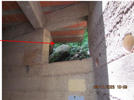
abertura no muro de arrimo e vista da Área de Preservação Permanente
