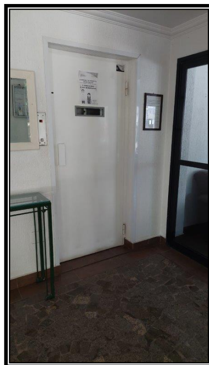
Figura 10 – Elevador do Edifício
