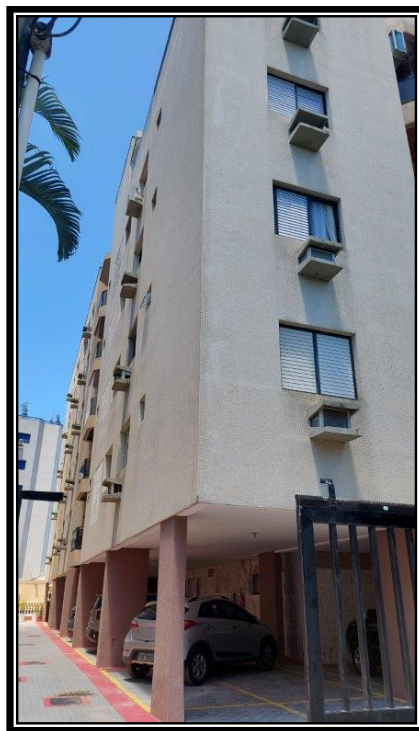
Figura 6 – Lateral do Edifício
