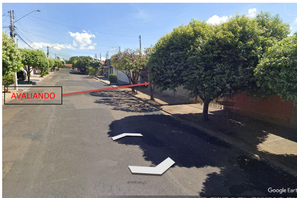
Figura 5 - Infraestrutura do entorno – av. João Correa voltada para a Rua Enzo Castelani
