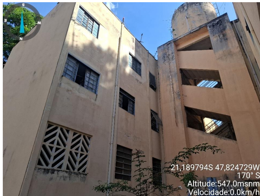
Foto 8 - Vista geral externa do bloco 22-B
