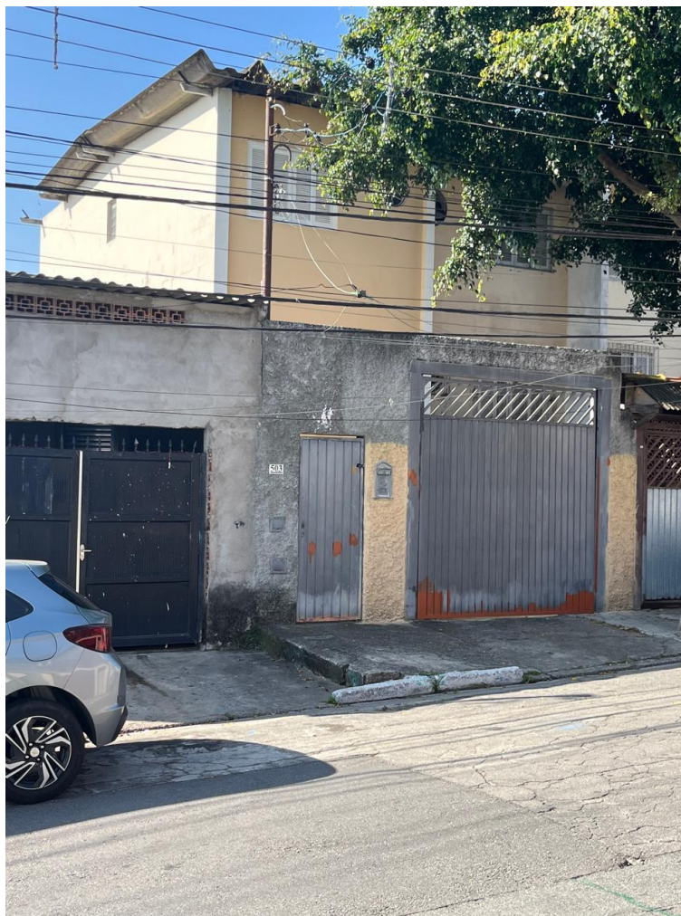
Foto nº. 1 – Vista da fachada do imóvel avaliando, a Rua Lauro Parente.
