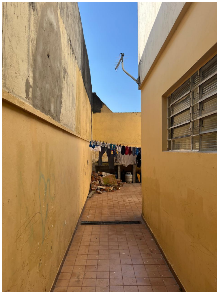
Foto nº. 3 – Vista do corredor lateral.
