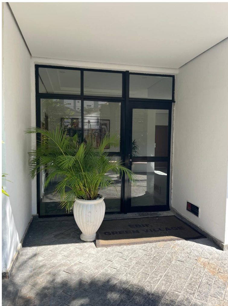
Foto nº. 11 – Vista da entrada do hall social.
