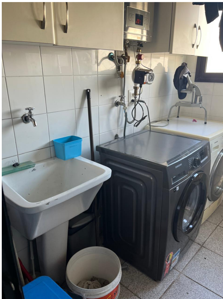
Foto nº. 20 – Vista da área de serviço.
