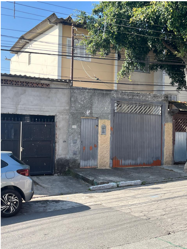
Vista da fachada do imóvel avaliando.
