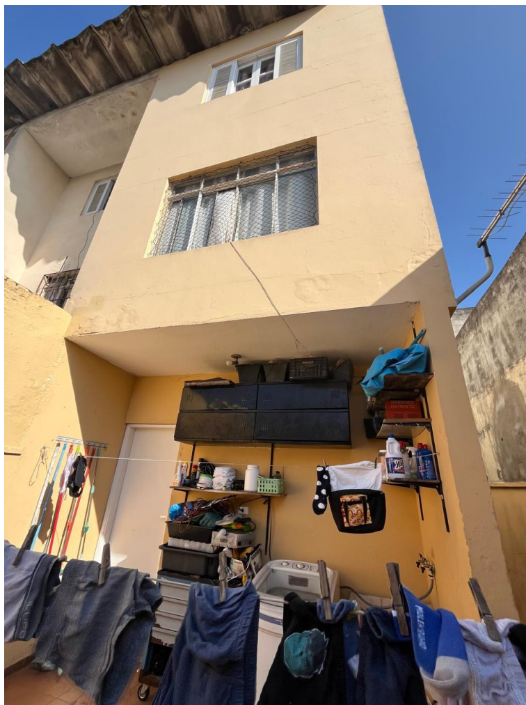
Foto nº. 5 – Vista da fachada posterior.
