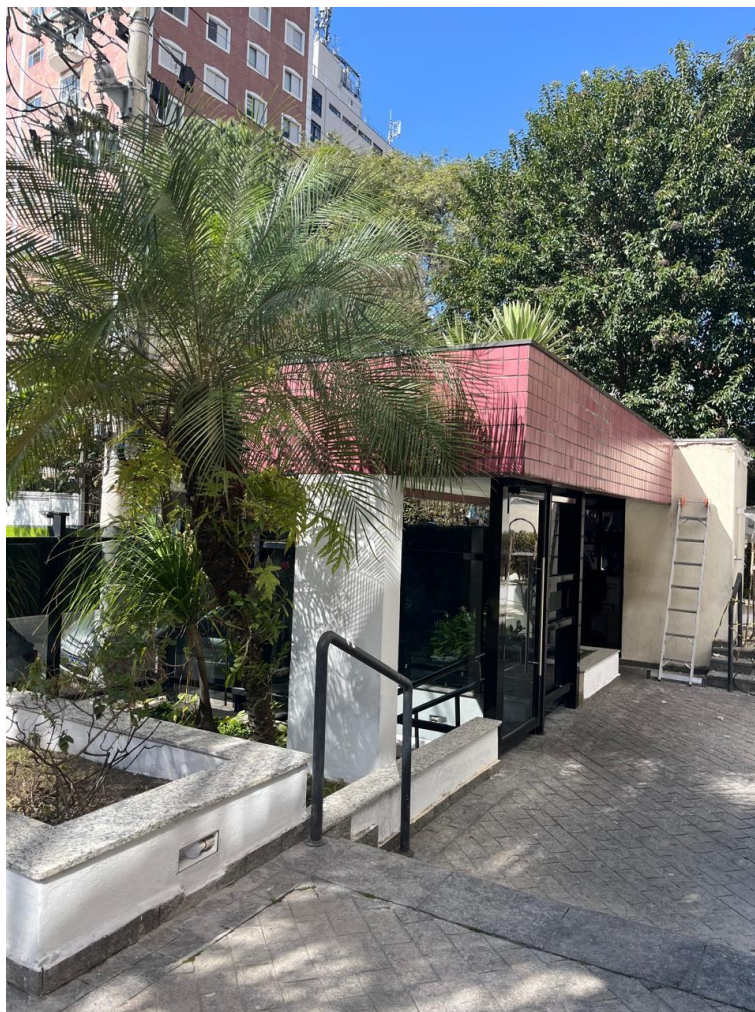
Foto nº. 5 – Vista da portaria.
