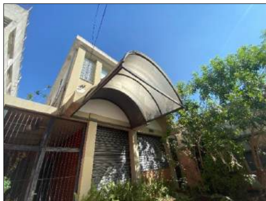
Foto 13 – Frente do imóvel
