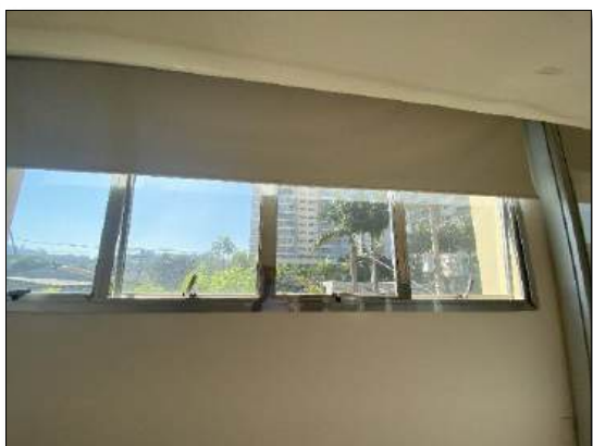
Foto 89 – Detalhe da esquadria de alumínio
