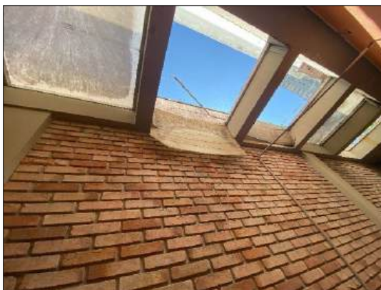
Foto 26 – Detalhe da cobertura da lateral esquerda
