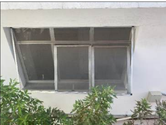
Foto 120 – Edícula (prédio anexo)
