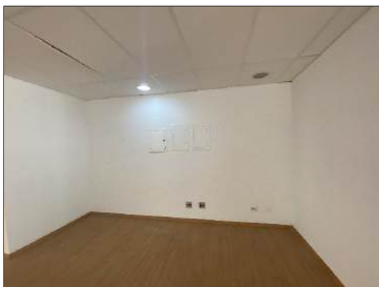
Foto 97 – Quadros de energia (1º andar)
