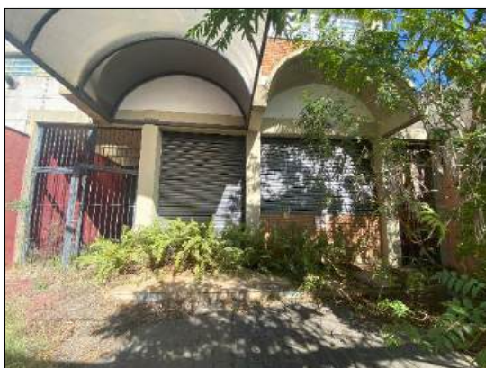
Foto 11 – Fachada do imóvel
