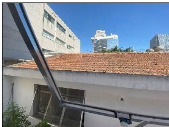
Foto 65 – Vista para edícula (prédio anexo)
