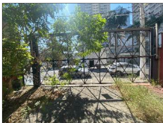
Foto 17 – Portão de entrada
