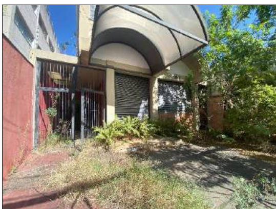
Foto 12 – Frente do imóvel (estacionamento)
