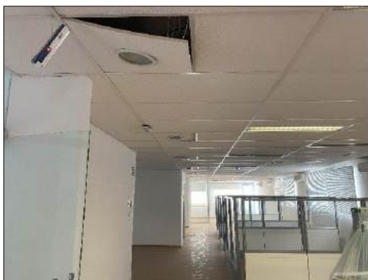
Foto 101 – Detalhe do forro (teto)
