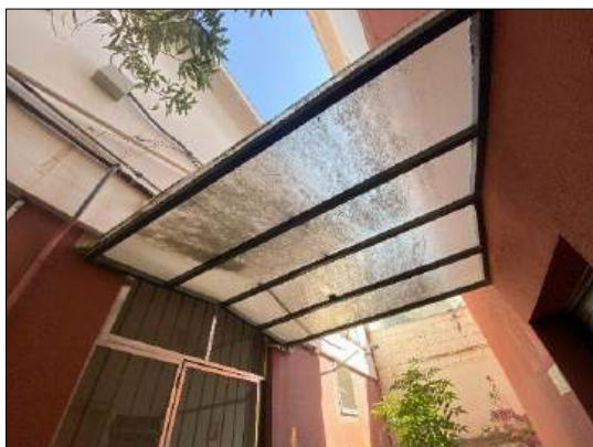
Foto 111 – Edícula (Prédio anexo)
