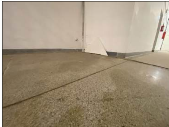
Foto 52 – Detalhe do piso (térreo)
