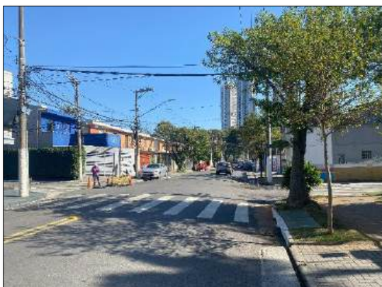
Foto 6 – Vista da rua
