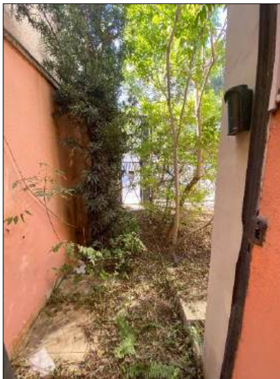
Foto 14 – Vegetação que está na frente do portão
