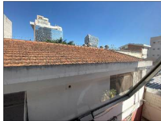
Foto 66 – Vista para edícula (prédio anexo)
