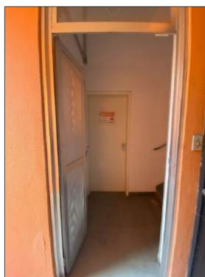
Foto 28 – Acesso para edificação principal
