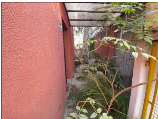
Foto 109 – Edícula (Prédio anexo)
