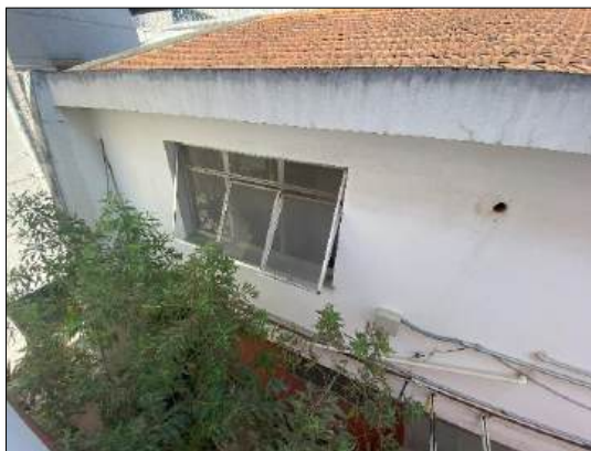
Foto 117 – Edícula (prédio anexo)
