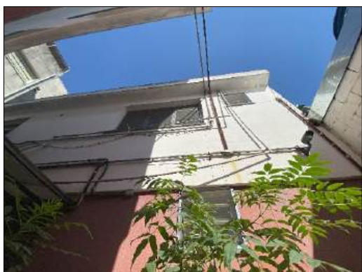
Foto 107 – Edícula (Prédio anexo)
