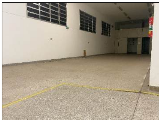
Foto 47 – Detalhe do piso (térreo)
