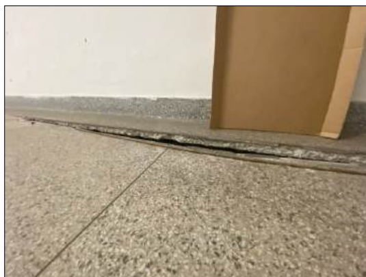
Foto 48 – Detalhe do piso (térreo)
