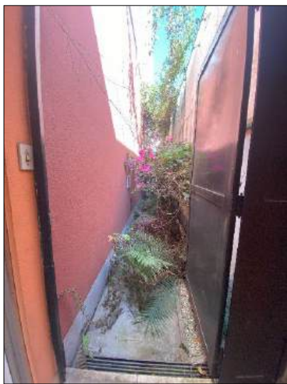
Foto 103 – Corredor lateral esquerda
