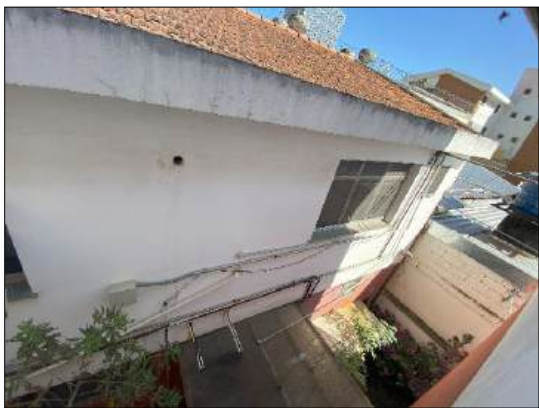
Foto 118 – Edícula (prédio anexo)
