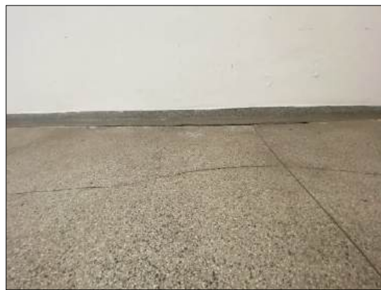
Foto 50 – Detalhe do piso (térreo)
