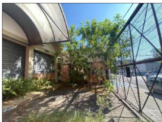
Foto 15 – Vegetação que está na frente do portão
