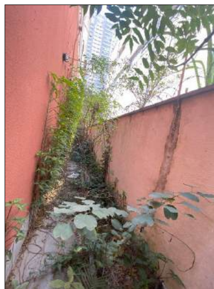
Foto 114 – Corredor lateral da direita
