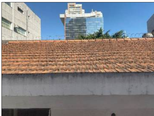
Foto 115 – Telhado do prédio anexo
