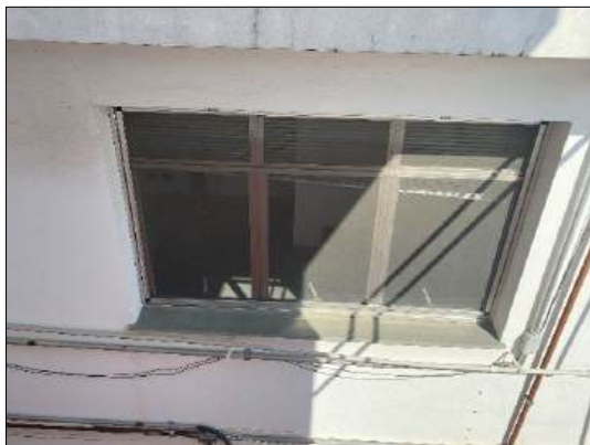
Foto 121 – Edícula (prédio anexo)
