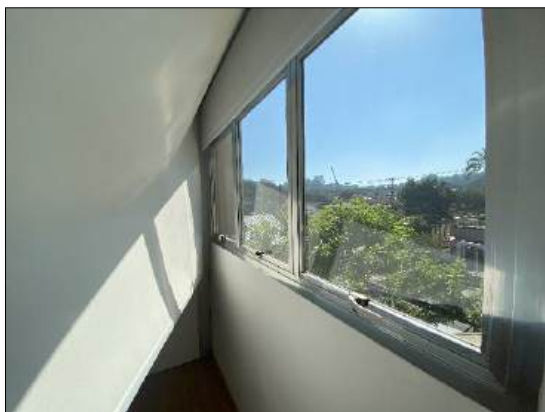
Foto 85 – Detalhe da esquadria de alumínio
