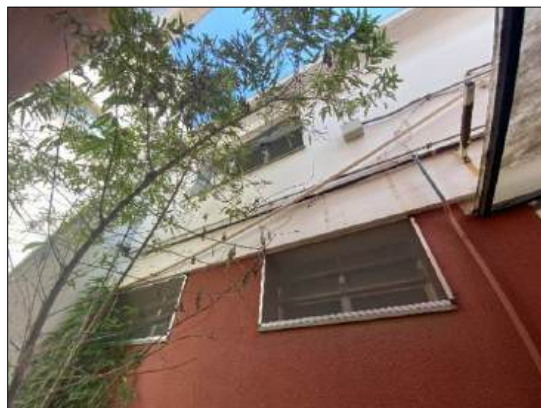
Foto 112 – Edícula (Prédio anexo)
