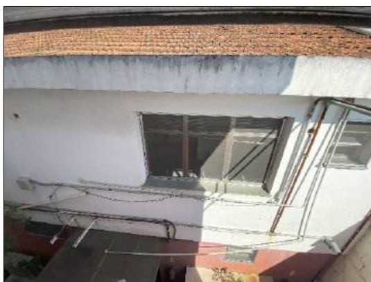
Foto 119 – Edícula (prédio anexo)
