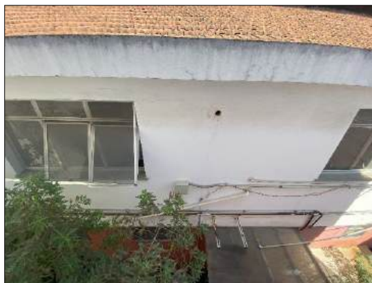
Foto 116 – Edícula (prédio anexo)
