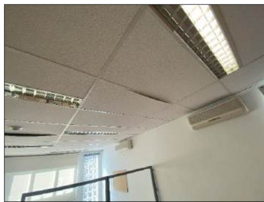
Foto 102 – Detalhe do forro (teto)
