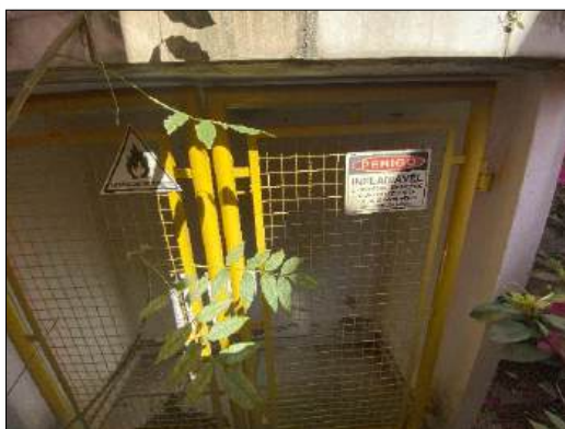
Foto 105 – Armazenamento de inflamáveis
