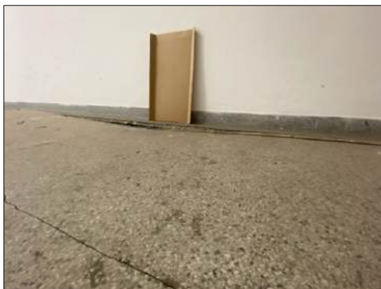
Foto 49 – Detalhe do piso (térreo)
