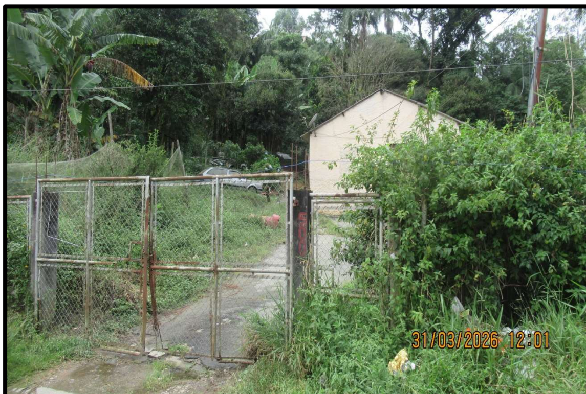
Foto nº 3: Vista frontal do imóvel avaliando, evidenciando a extensa cobertura vegetal existente no terreno junto à testada voltada para a Rua da Saúde.
