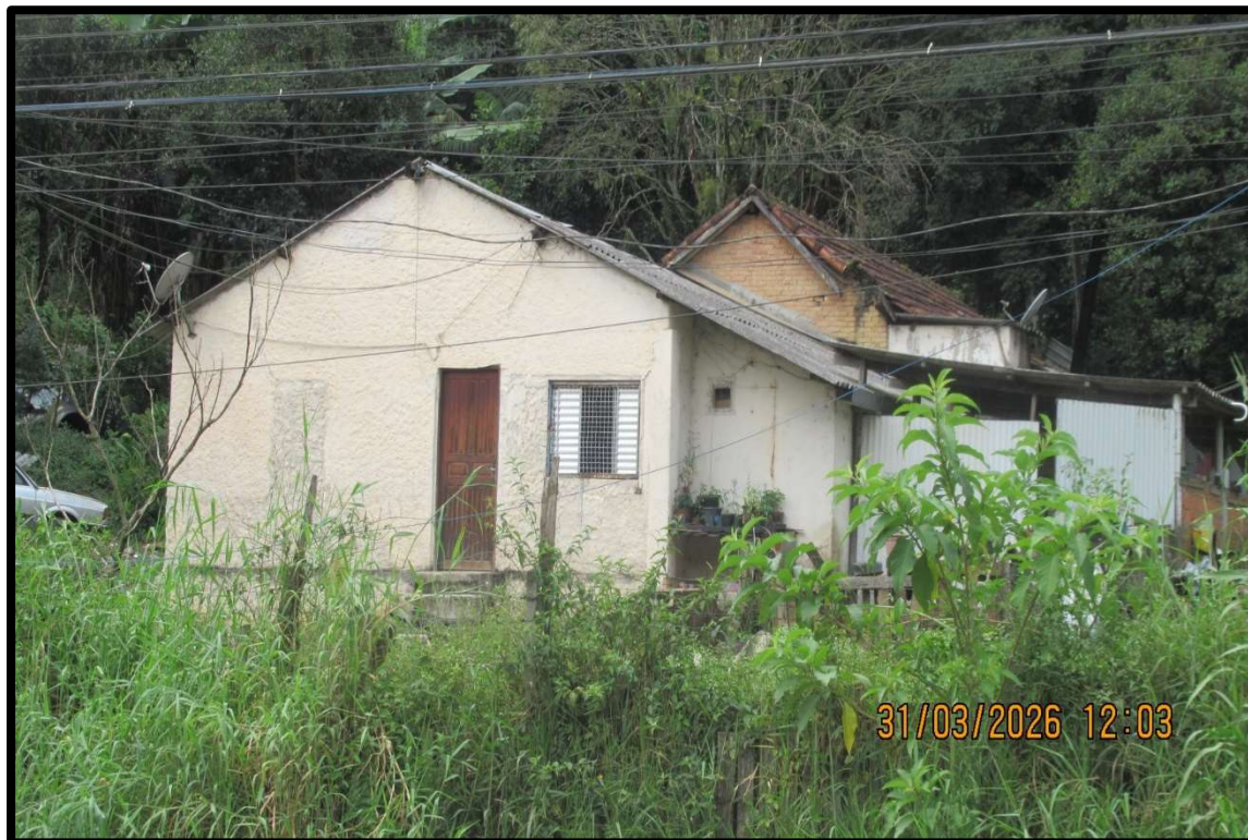
Foto nº 6: Detalhe das edificações erigidas em alvenaria, no interior da área.
