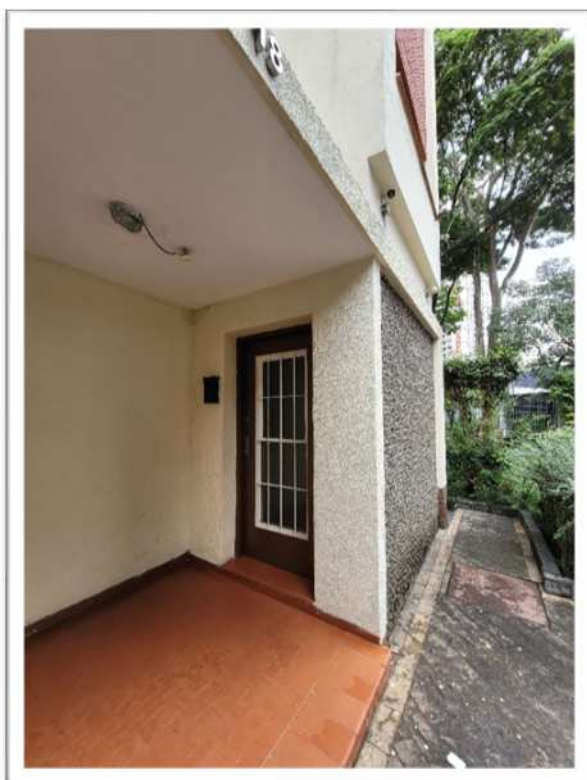
FOTO 04 – ENTRADA DO PRÉDIO DO IMÓVEL AVALIANDO
