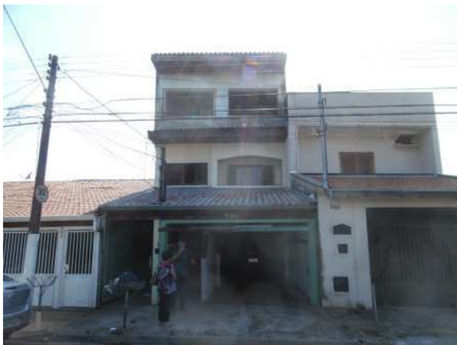
Fachada da edificação. Subsolo, Térreo, Pavimento Superior e um quarto pavimento construído irregularmente.
