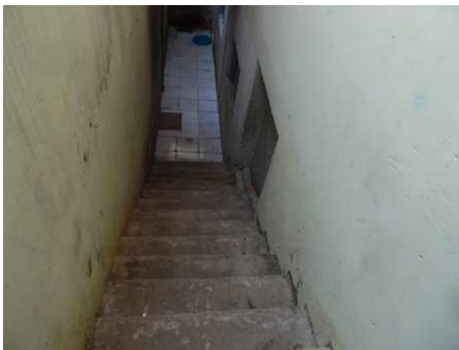
Acesso à casa do pavimento inferior.
