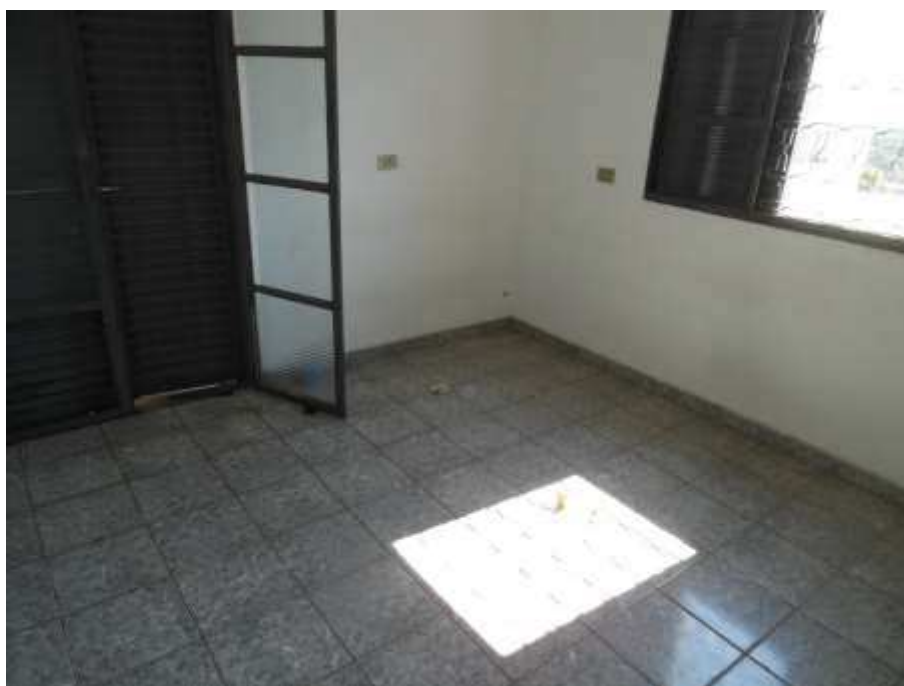
Outro dormitório da casa no pavimento térreo.
