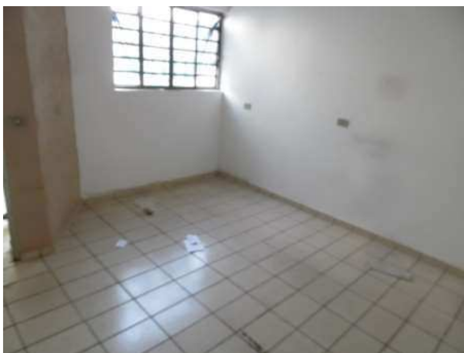
Sala da casa no pavimento térreo.
