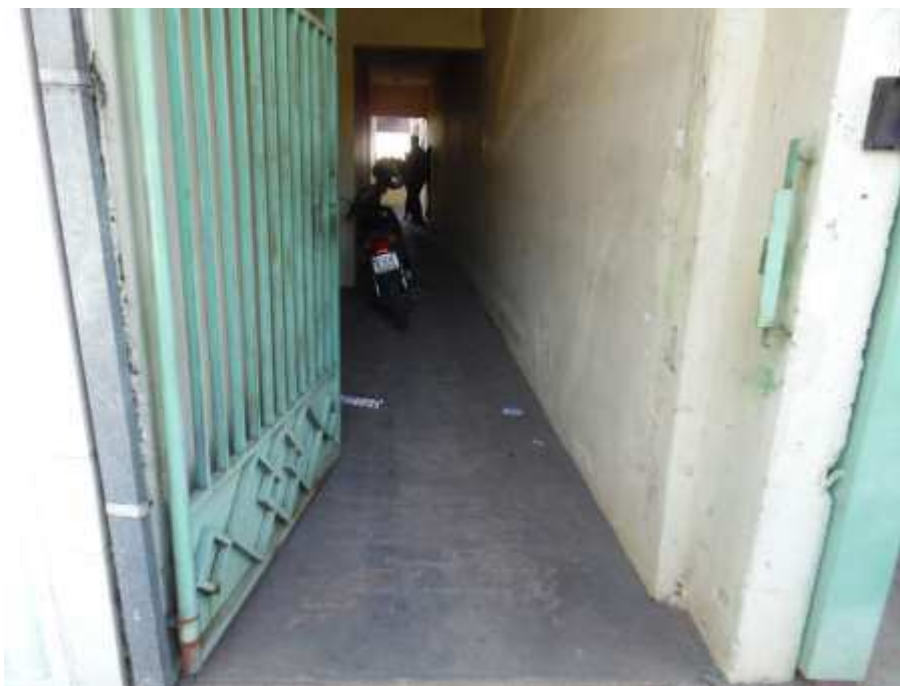
Acesso às casas que ficam no pavimento térreo e inferior da edificação.
