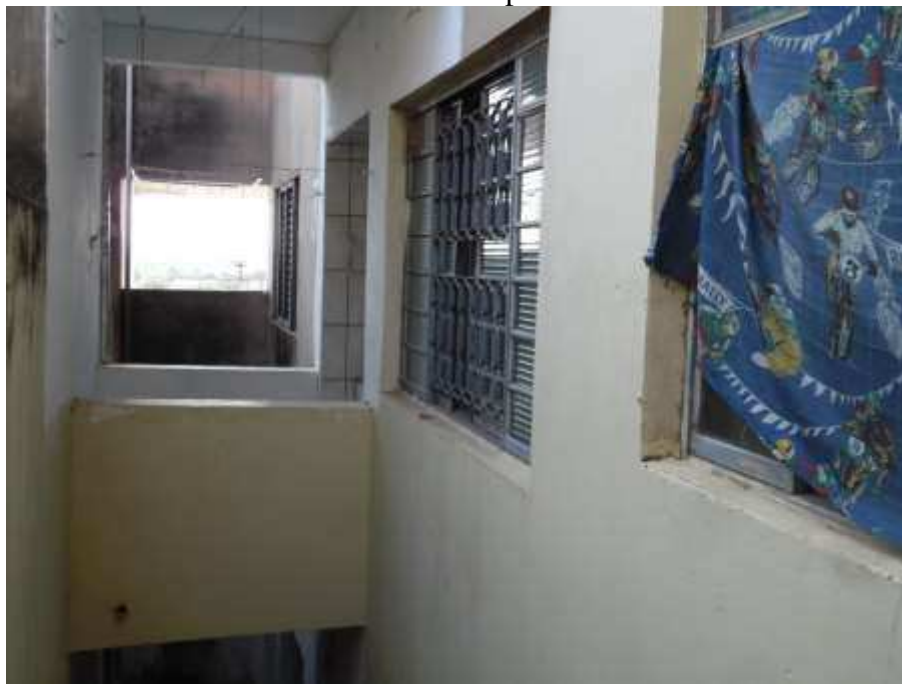
Vista da área de serviço da casa do pavimento térreo.
