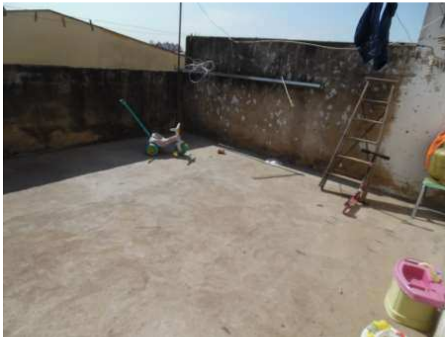
Quintal da casa no pavimento inferior.
