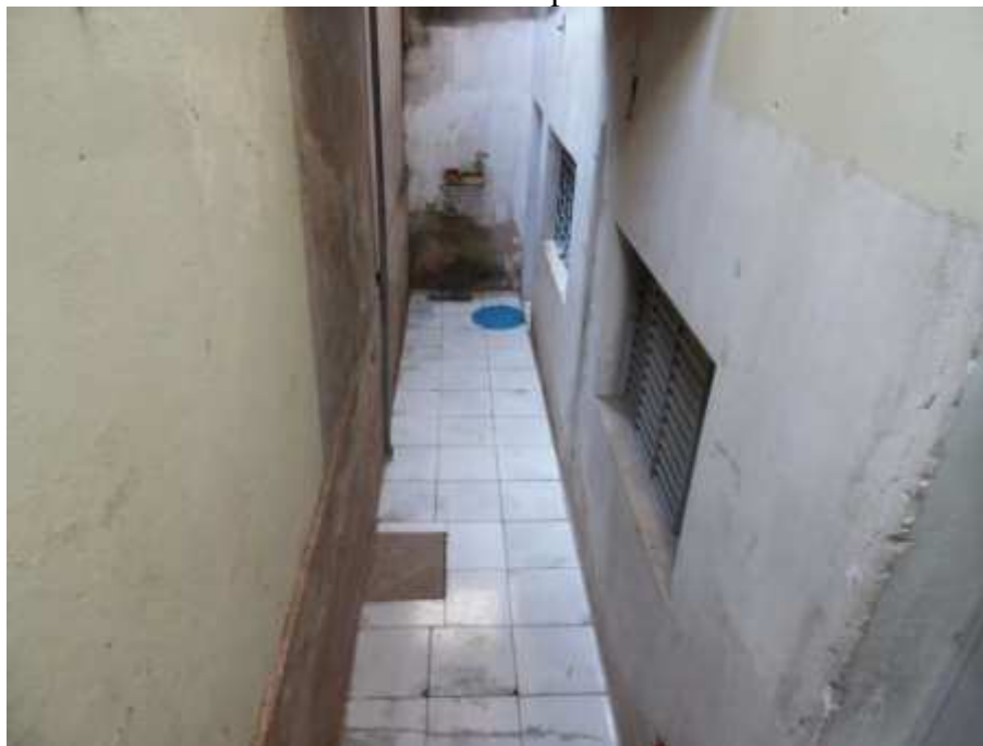
Acesso à casa do pavimento inferior.
