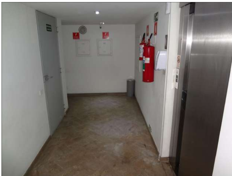
Foto 33 – Hall do elevador de serviço no pavimento térreo, a porta a esquerda dá acesso ao pátio e a piscina.
