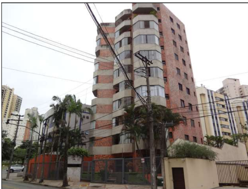
Foto 02 – Fachada Lateral do Condomínio Edifício Mares do Sul.
