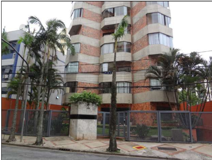
Foto 01 – Fachada frontal do Condomínio Edifício Mares do Sul.
