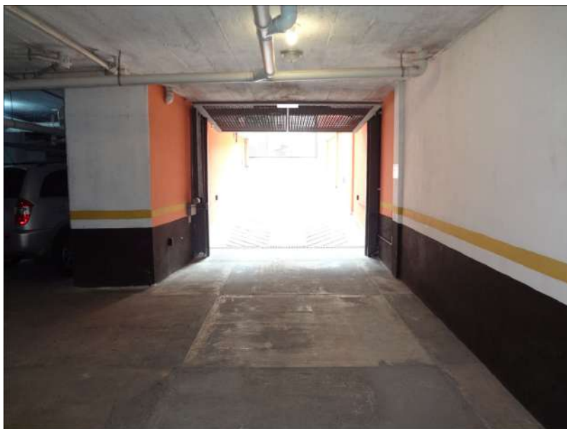
Foto 47 – Portão do 1º Subsolo para a rampa.
