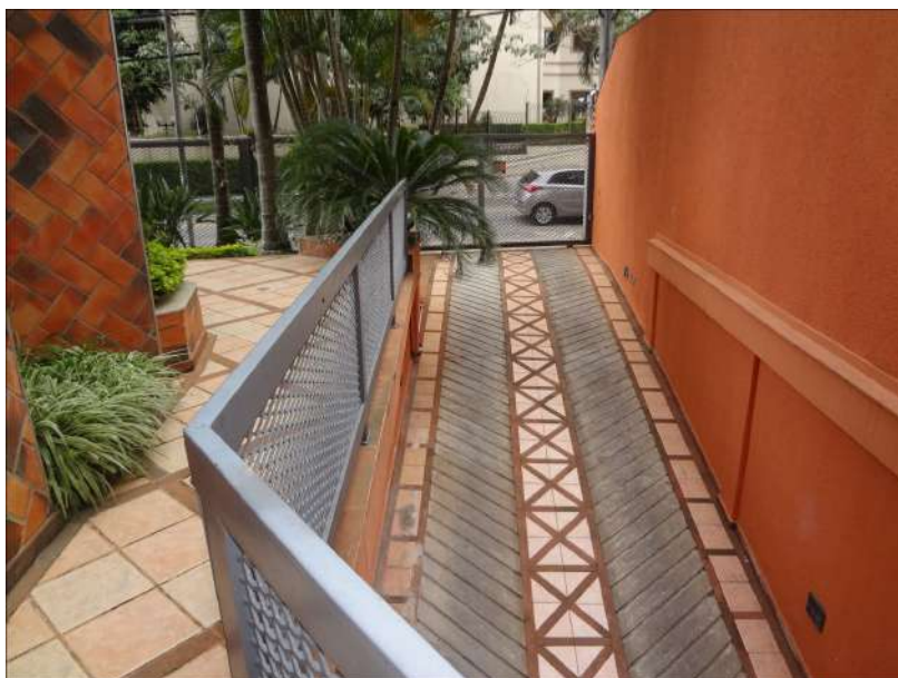
Foto 48 – Rampa de acesso do 1º Subsolo para a Rua David Ben Gurion.
