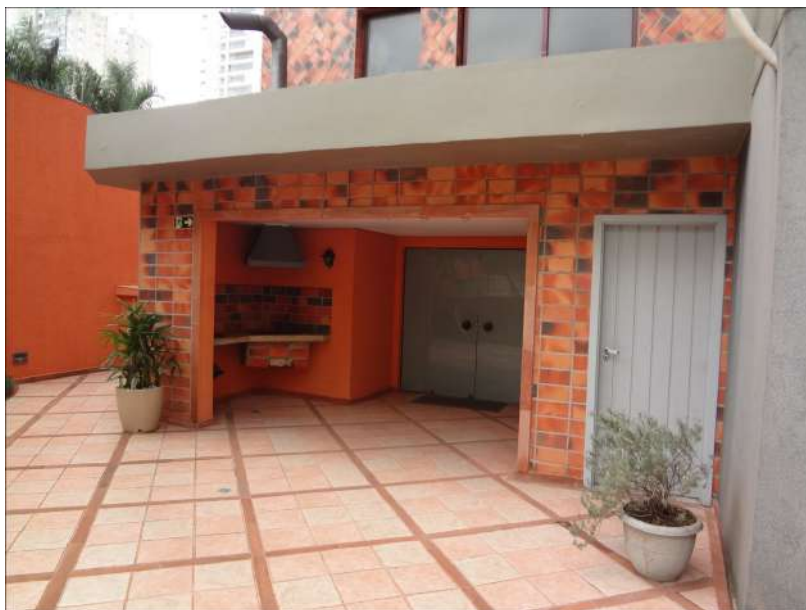
Foto 37 – Churrasqueira e porta em vidro para o Salão de Festas, e a porta em madeira da acesso ao Hall do elevador de serviço..
