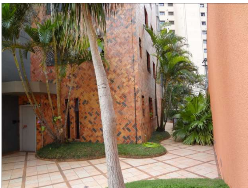
Foto 38 – Fachada fundo e lateral e piso revestido com cerâmica.
