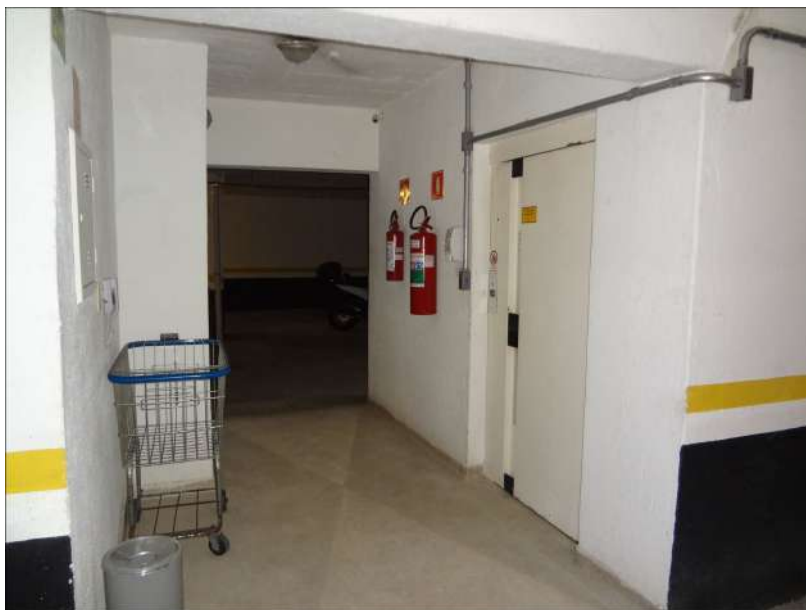
Foto 43 – Hall do elevador no 1º Subsolo.
