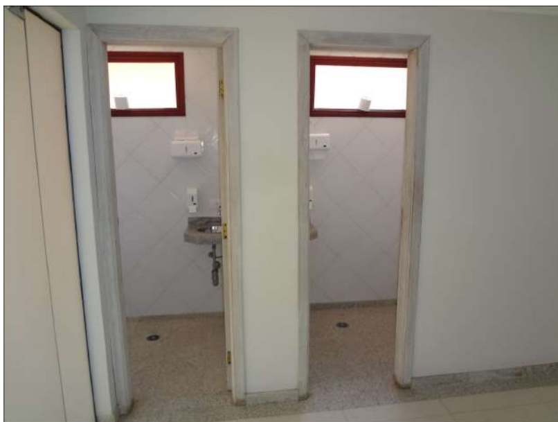
Foto 32 – Salão de Festas, vista dos banheiros.
