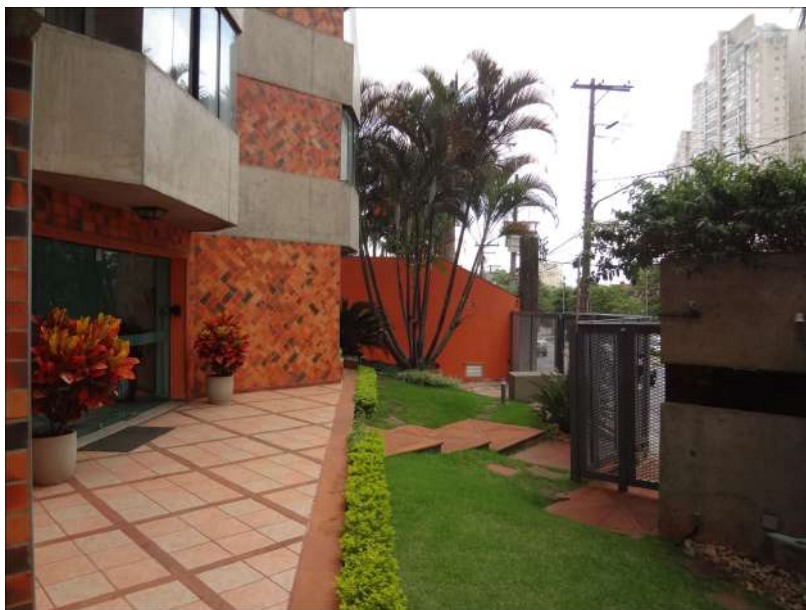
Foto 39 – Hall social, escada, portão, jardim e guarita.
