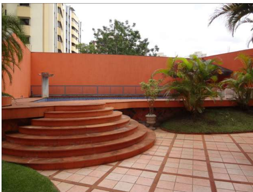
Foto 34 – Pátio revestido em cerâmica e escada de acesso a piscina.
