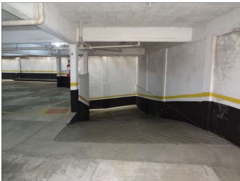
Foto 46 – Rampa de acesso do 1º Subsolo para o 2º Subsolo.
