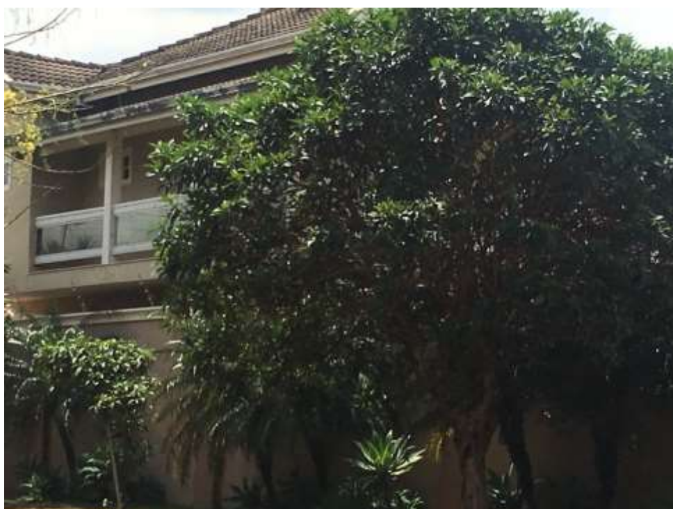
Foto nº 01 - Na foto acima, vemos a fachada do imóvel localizado na Rua Décio Pirágine nº 122, no Jardim Maria Luiza III - Jaú / SP, matrícula nº 66.397, pertencente a Luiz Fernando Rossini Barbeta.
