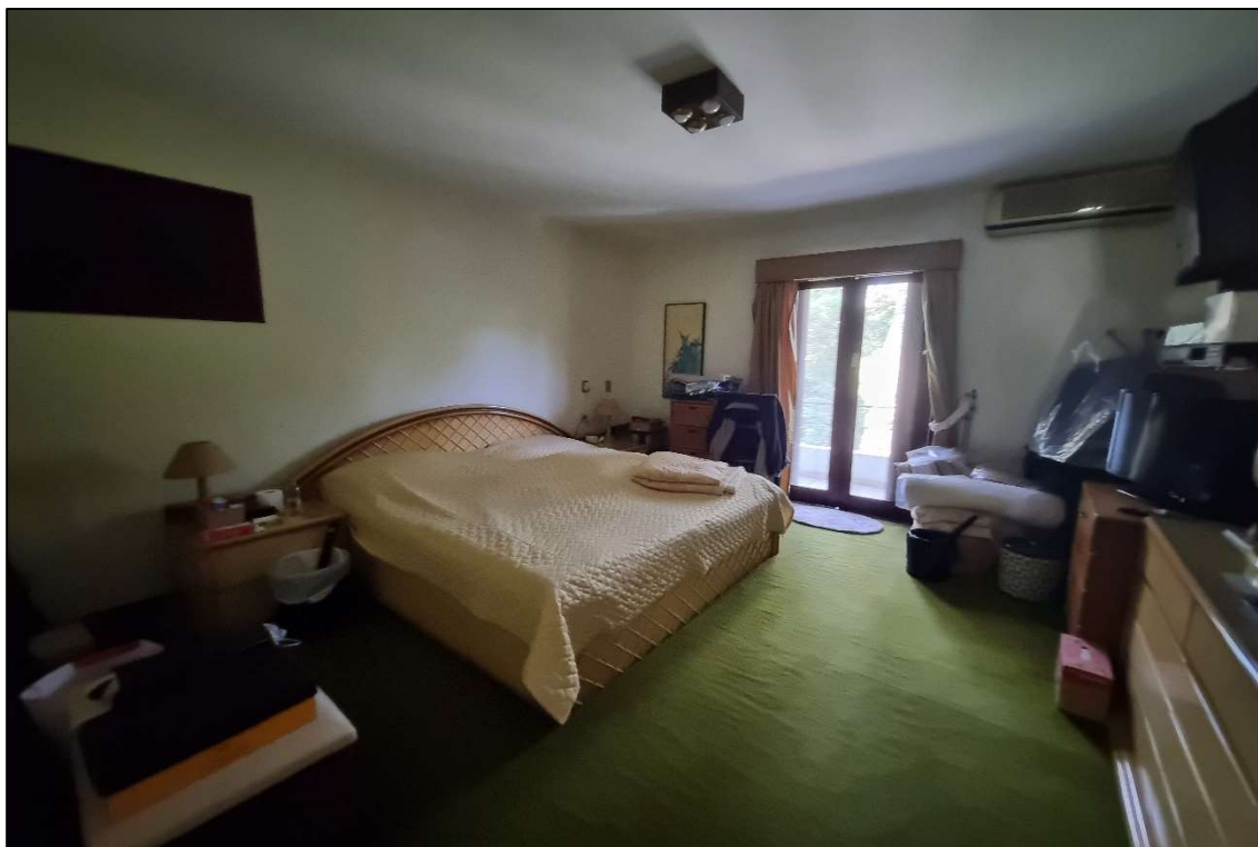
Foto nº 12: Vista de outro dormitório. Suas principais características construtivas são: piso em assoalho de madeira, paredes revestidas em massa corrida pintadas em látex, forro em laje e esquadrias de madeira.
