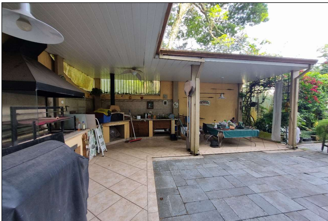
Foto nº 32: Detalhe da área de churrasqueira coberta com telhas de pvc.
