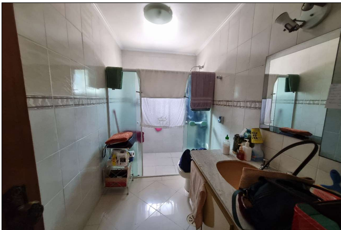
Foto nº 13: Vista da suíte do dormitório anterior. Suas principais características construtivas são: piso cerâmico, paredes azulejadas até o teto, forro em laje e esquadrias de madeira.
