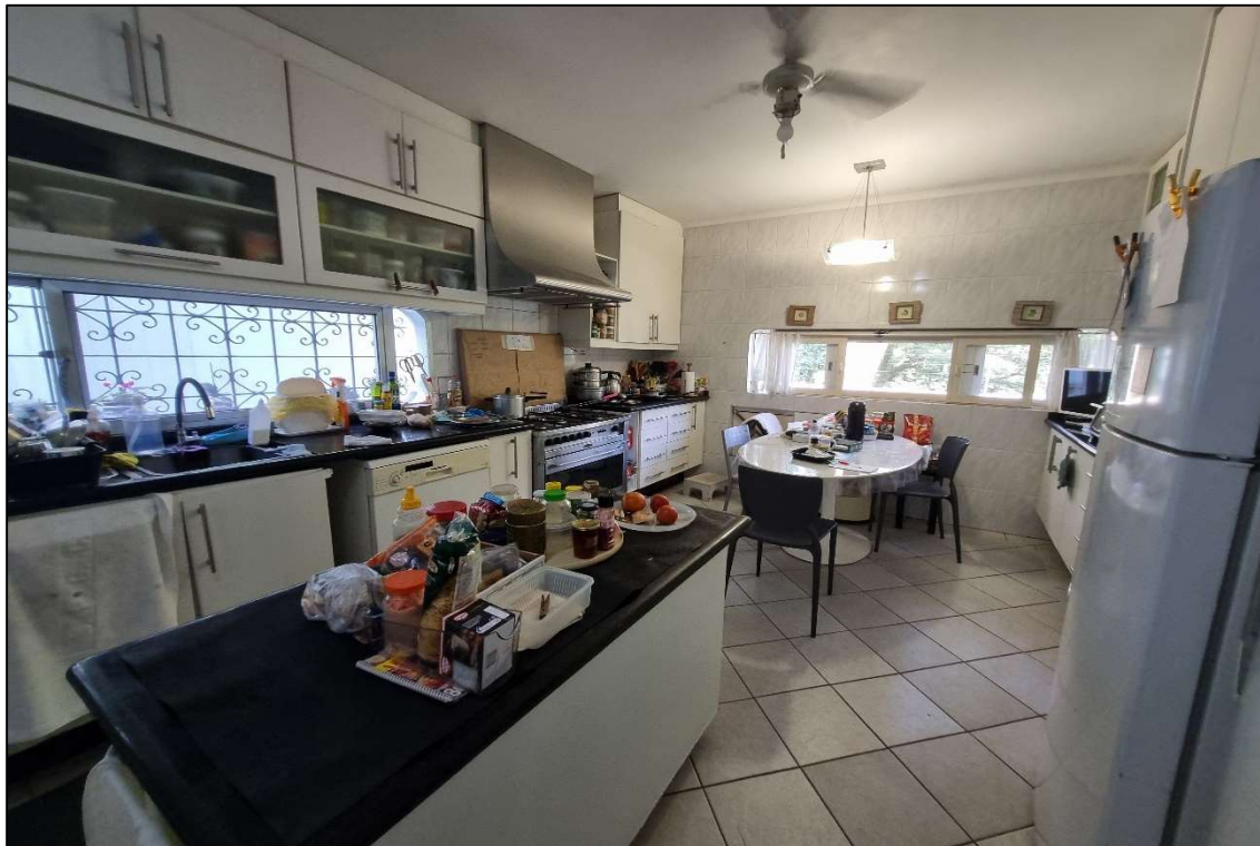
Foto nº 20: Vista da cozinha. Suas principais características construtivas são: piso cerâmico, paredes azulejadas até o teto, forro em laje e esquadrias de madeira.
