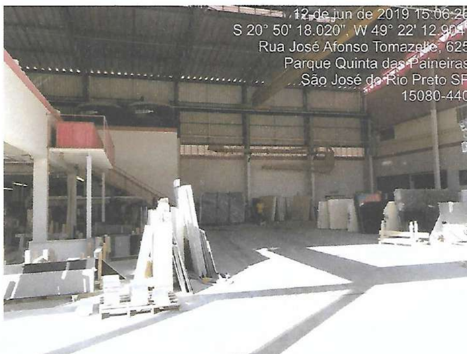
Foto 28 – vista interna do imóvel 04.
