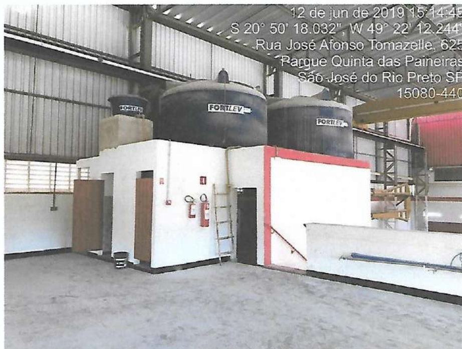
Foto 34 – vista do mezanino / reservatório de água / imóvel 04.
