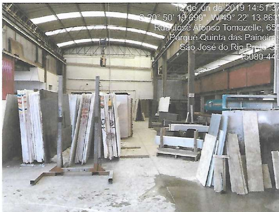
Foto 19 – vista interna / imóvel 02.
