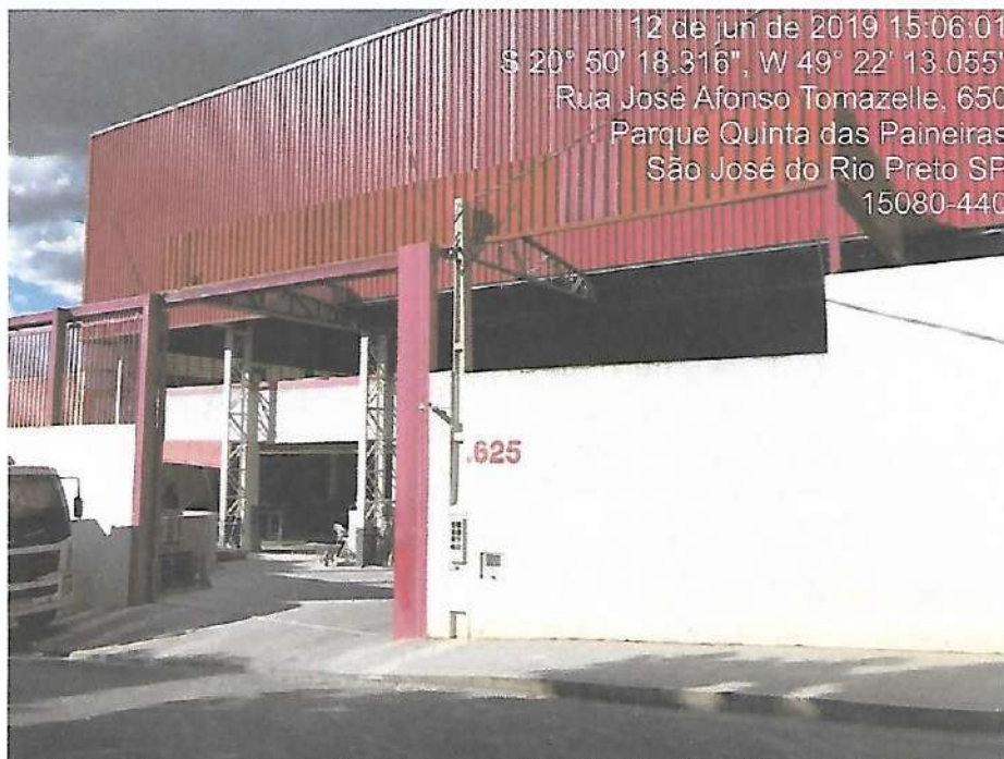
IMÓVEL 04 – RUA JOSÉ AFONSO TOMAZELLE Nº625
