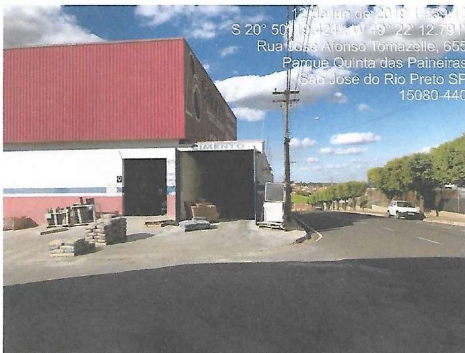
Foto 22 – vista da fachada / imóvel 03.
