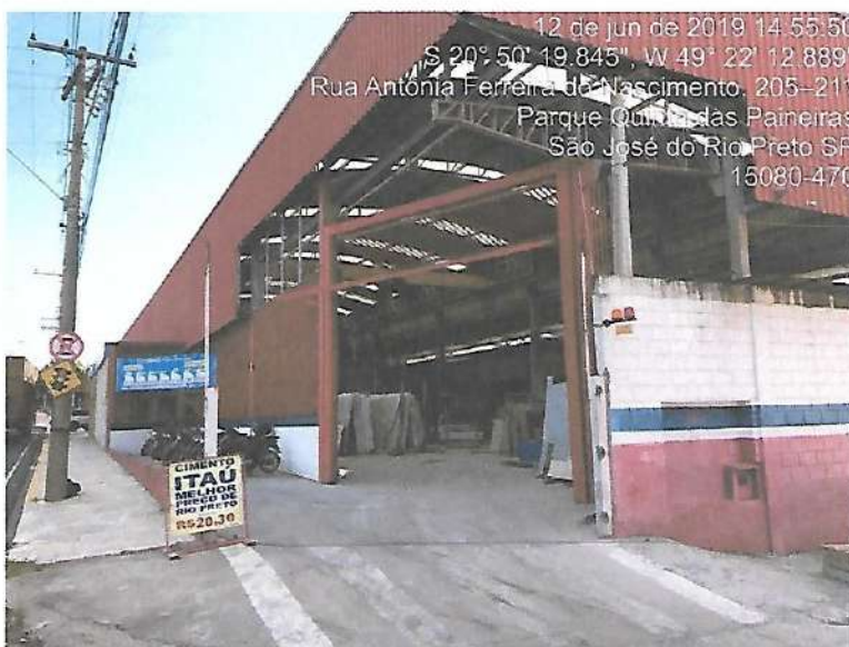
IMÓVEL 02 – RUA JOSÉ AFONSO TOMAZELLE Nº650
