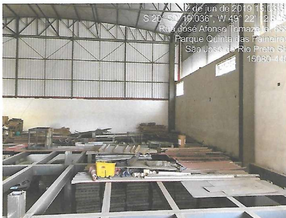
Foto 24 – vista interna / estrutura de ferro para receber placas WALL Para servir de piso no pavimento em nível com a rua / imóvel 03.
