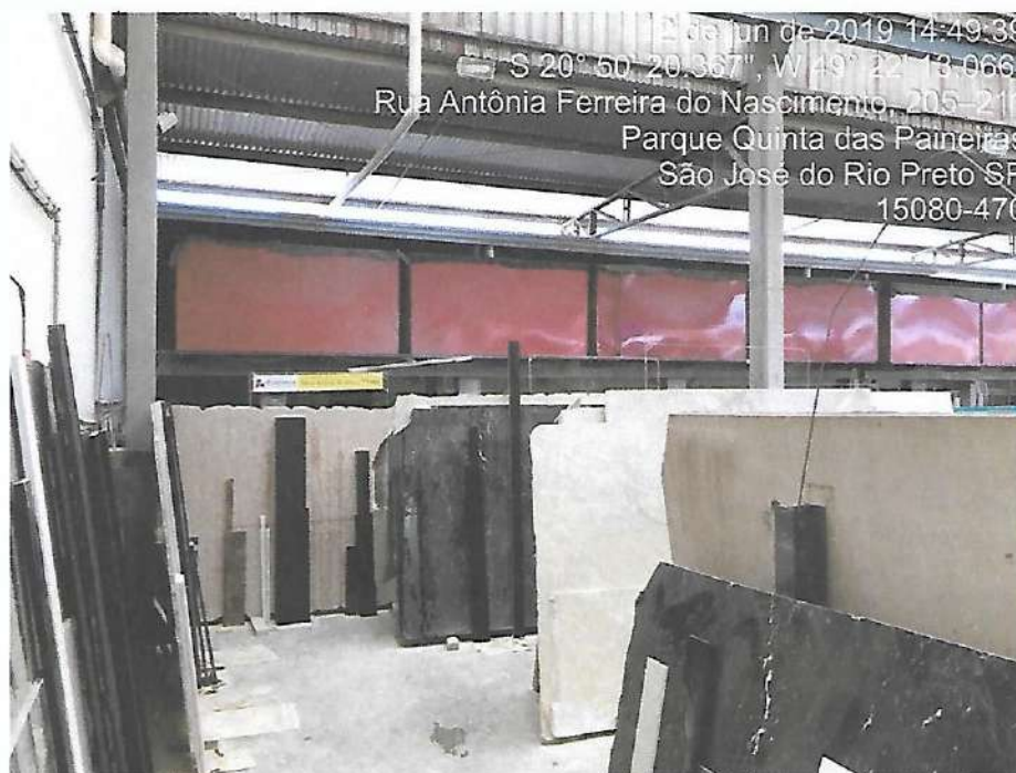
Foto 14 – vista interna / imóvel 02.
