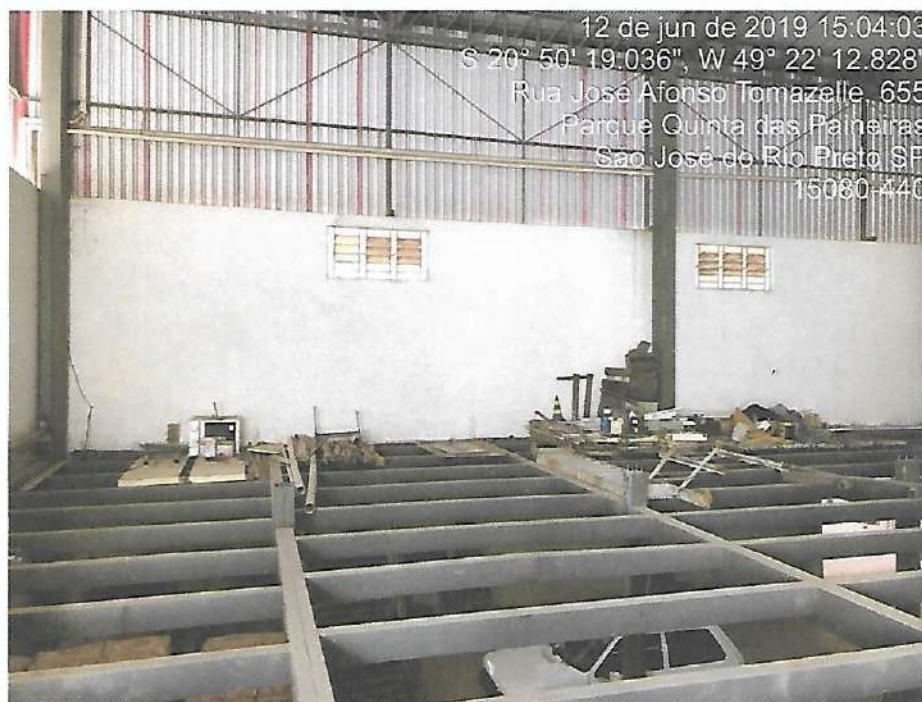
Foto 25 – vista da estrutura de ferro para receber placas WALL / imóvel 03.
