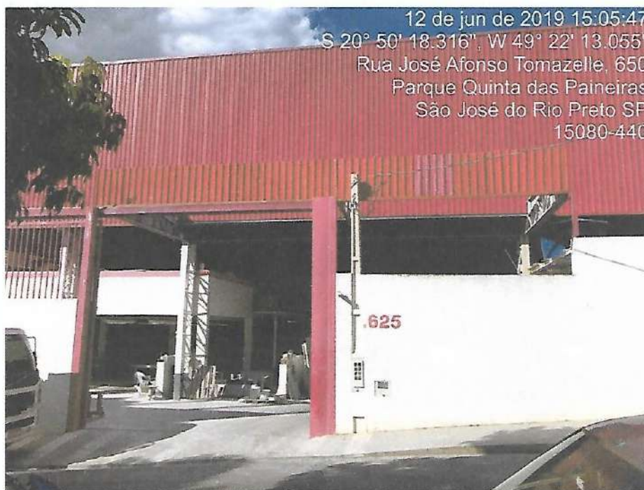
Foto 27 – vista da fachada do imóvel 04.
