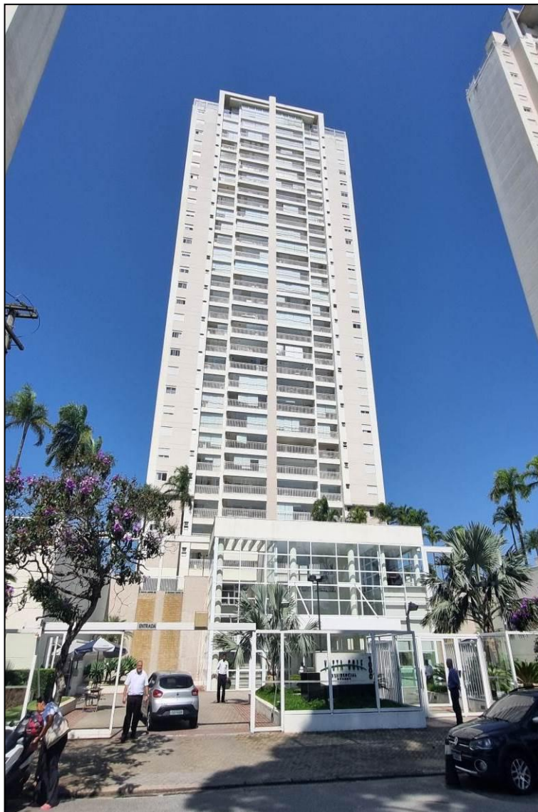
Foto nº 4: Vista do acesso para o Condomínio Vista Golf onde se localiza a unidade em estudo (apartamento nº 223 da Torre 3).
