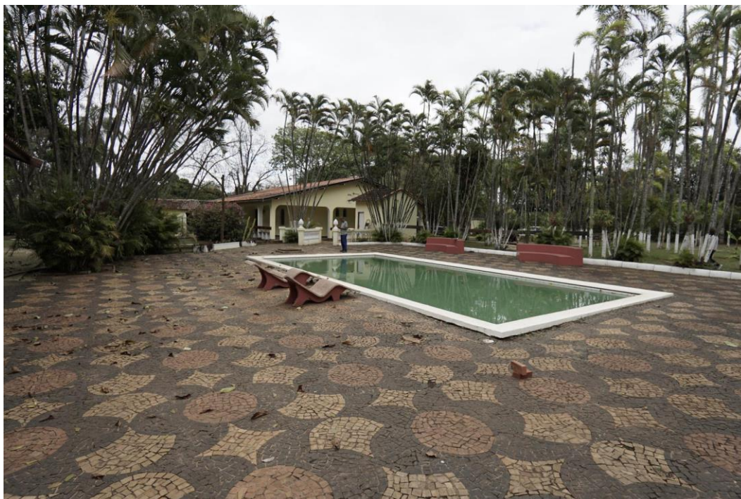
Figura 20. Deck da piscina.
