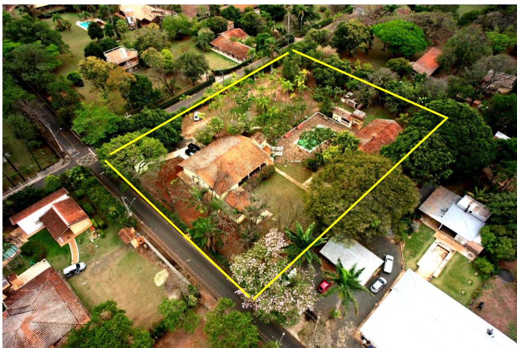
Figura 4. Vista do imóvel.
