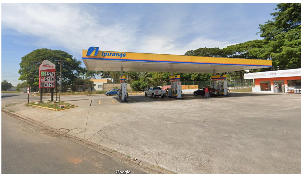
Figura 41. Posto de Gasolina.
