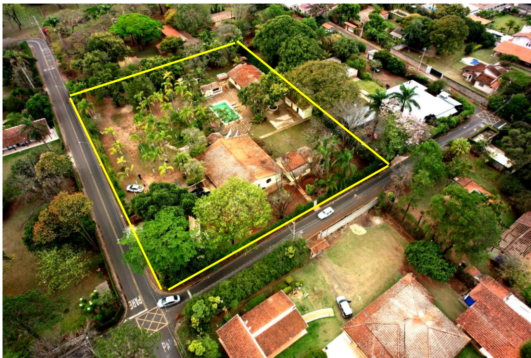
Figura 3. Vista do imóvel.
