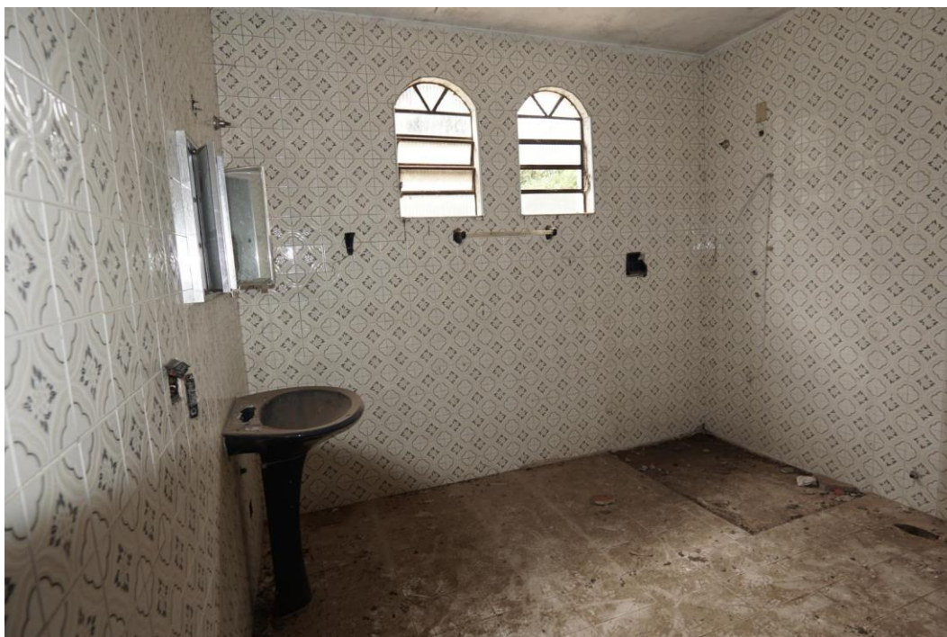
Figura 31. Casa 2, vista do banheiro 1.
