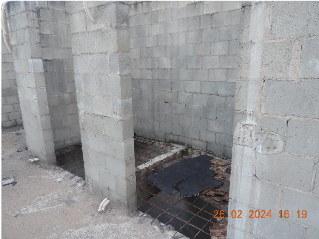
FOTO N° 47 – 4° PAVIMENTO DA EDIFICAÇÃO, VISTA PARCIAL
