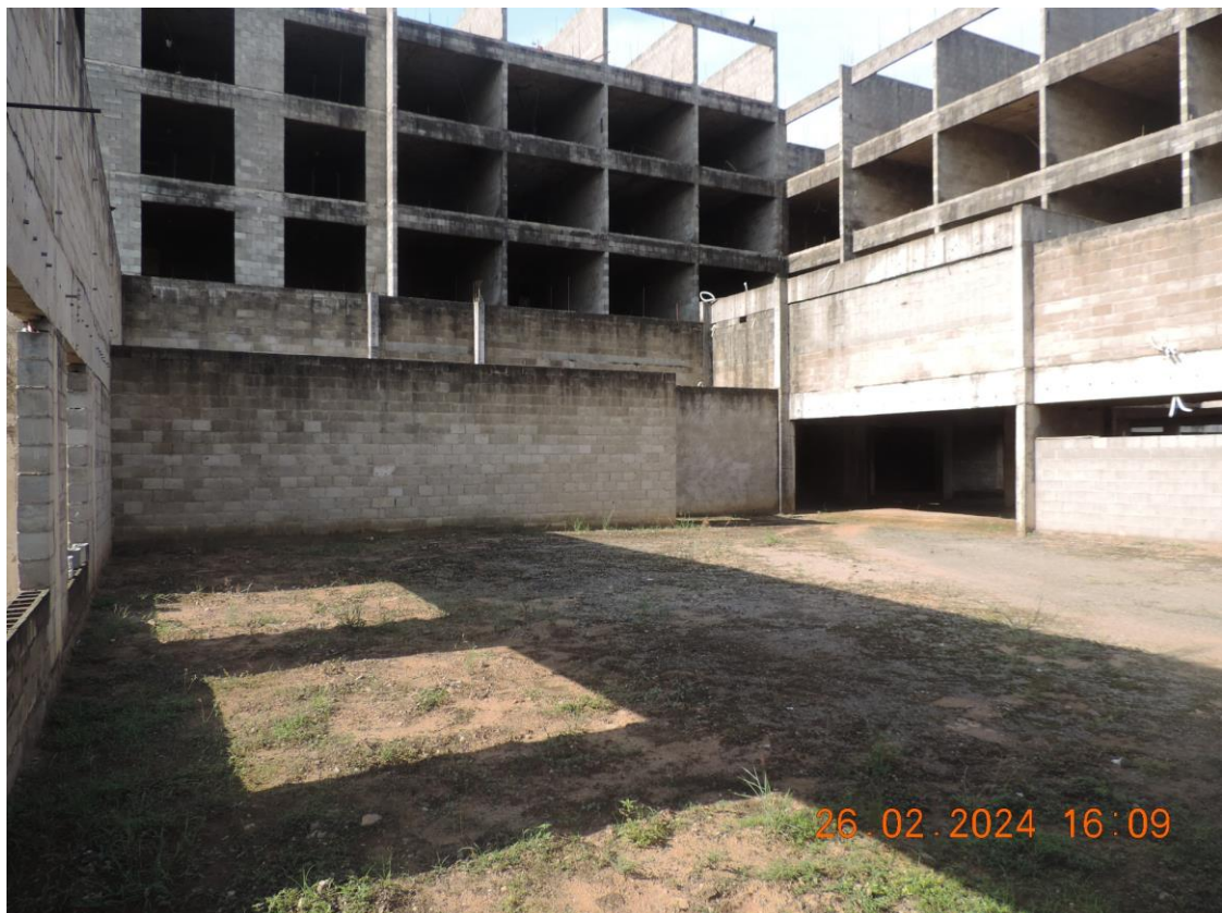
FOTO Nº 24 – PAVIMENTO TERREO DA EDIFICAÇÃO, VISTA PARCIAL
