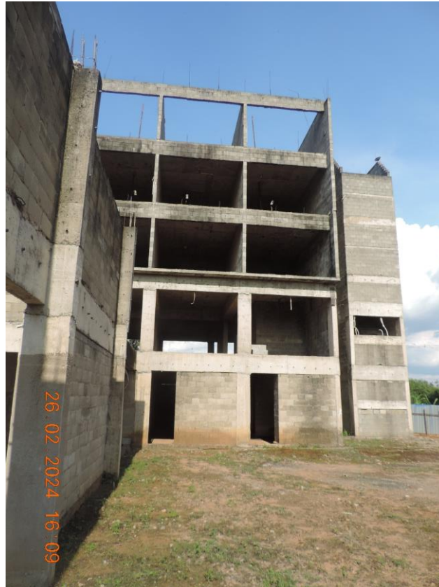
FOTO Nº 25 – PAVIMENTO TERREO DA EDIFICAÇÃO, VISTA PARCIAL
