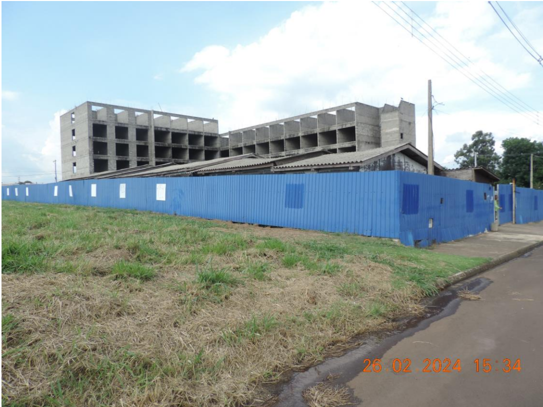
FOTO Nº 07 – VISTA EXTERNA DO IMÓVEL, A PARTIR DA RUA IMP. M. AURELIO
