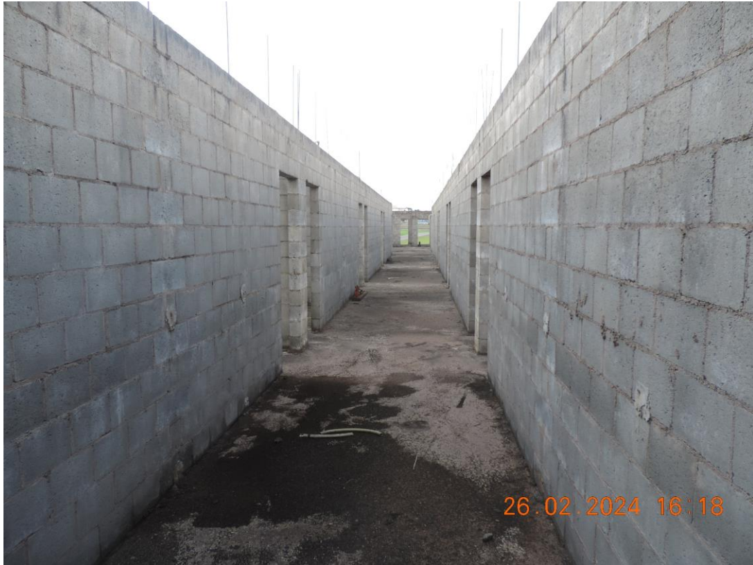
FOTO Nº 43 – 4º PAVIMENTO DA EDIFICAÇÃO, VISTA PARCIAL
