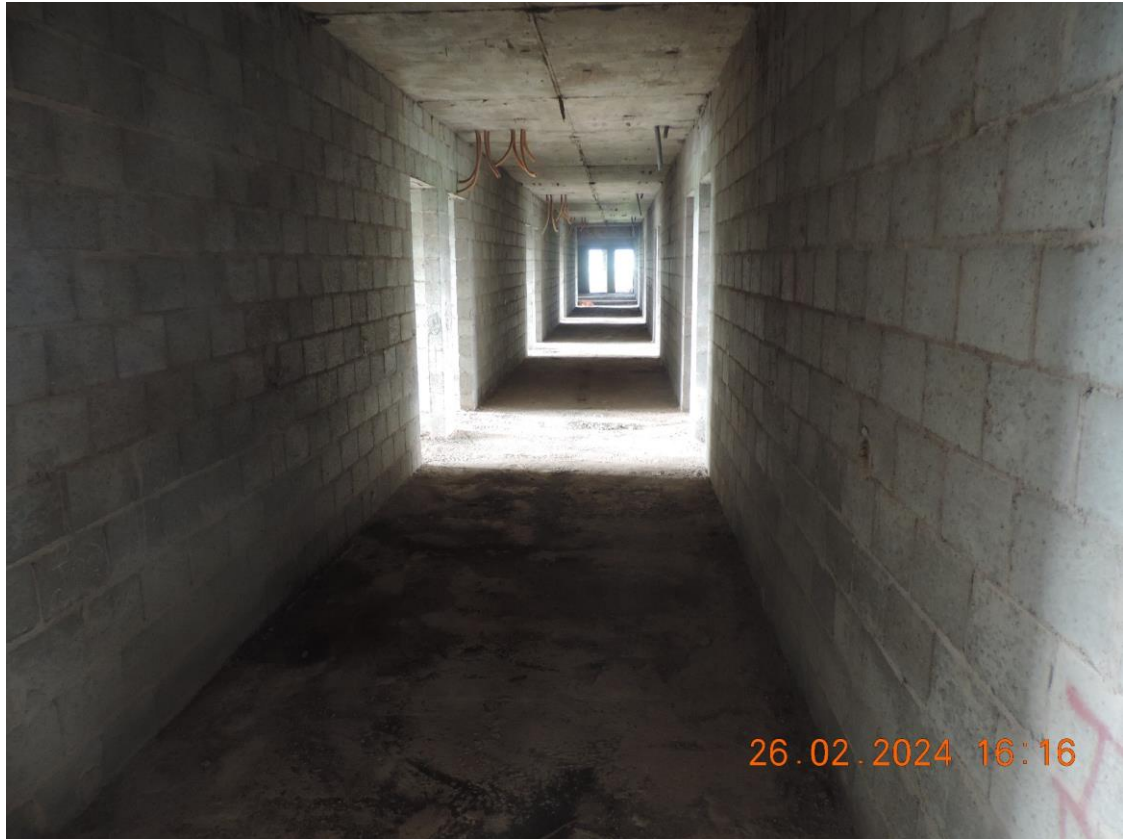
FOTO Nº 39 – 3º PAVIMENTO DA EDIFICAÇÃO, VISTA PARCIAL
