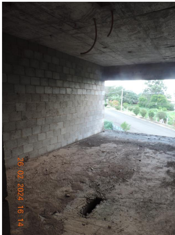
FOTO N° 34 – 2° PAVIMENTO DA EDIFICAÇÃO, VISTA PARCIAL
