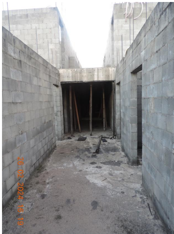
FOTO N° 48 – 4° PAVIMENTO DA EDIFICAÇÃO, VISTA PARCIAL
