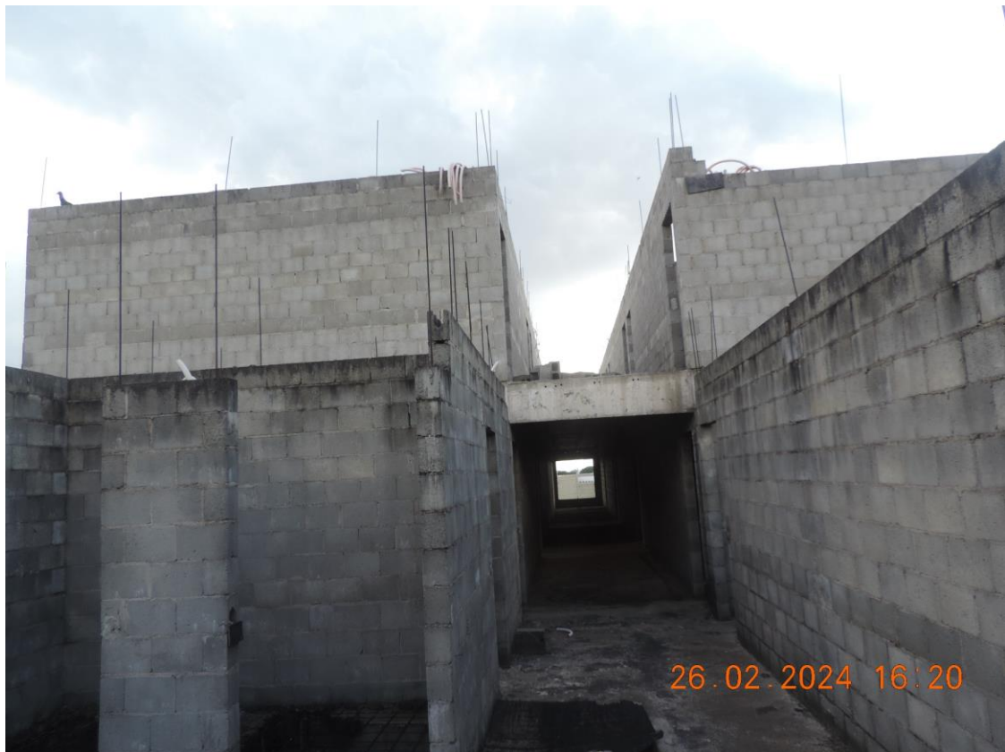
FOTO N° 50 – 4° PAVIMENTO DA EDIFICAÇÃO, VISTA PARCIAL
