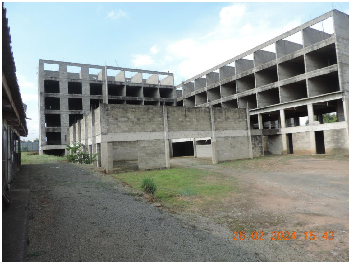
FOTO N° 14 – VISTA INTERNA DO IMÓVEL, POR OUTRO ÂNGULO
