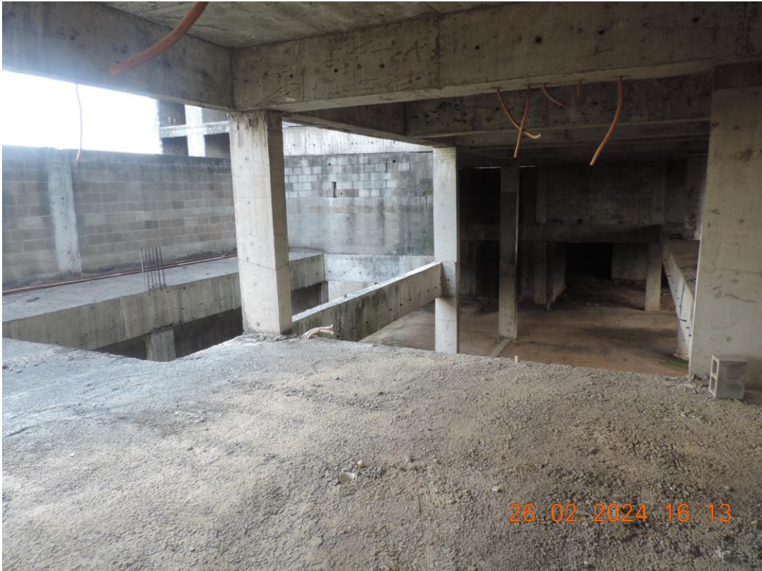
FOTO Nº 31 – 1º PAVIMENTO DA EDIFICAÇÃO, VISTA PARCIAL
