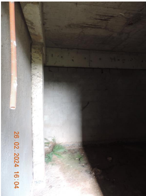
FOTO Nº 22 – PAVIMENTO TERREO DA EDIFICAÇÃO, VISTA PARCIAL
