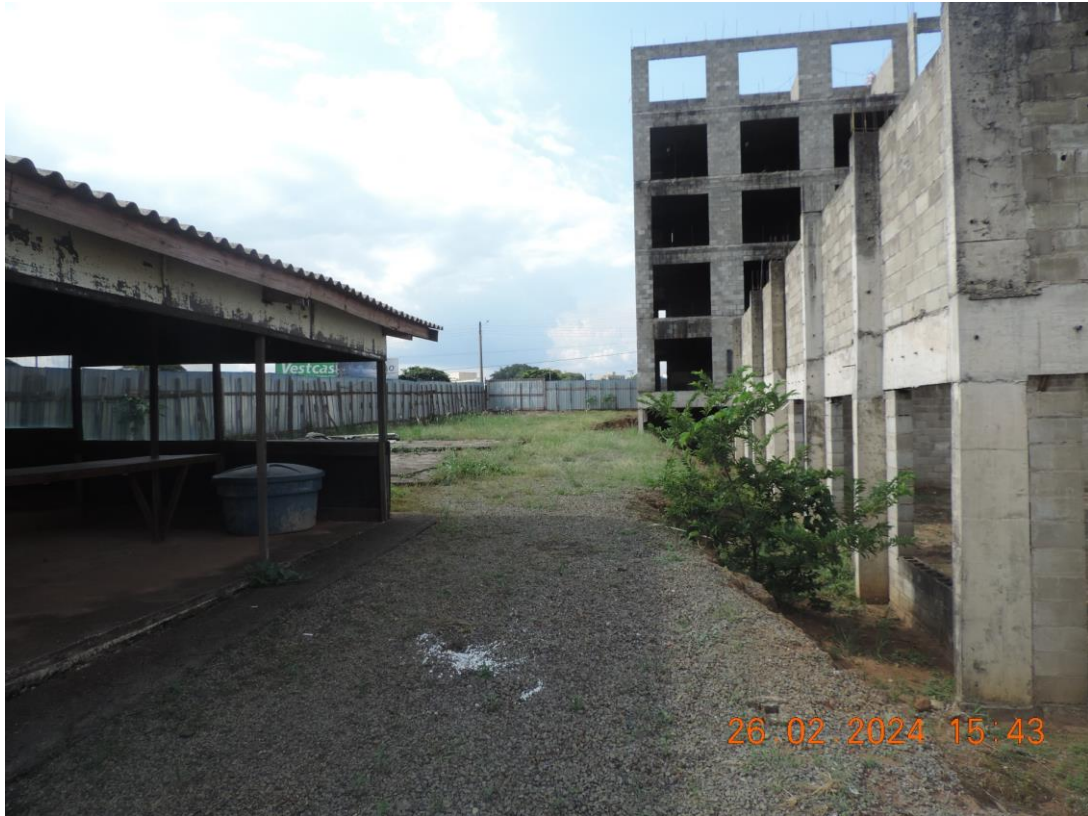
FOTO N° 15 – VISTA INTERNA DO IMÓVEL
