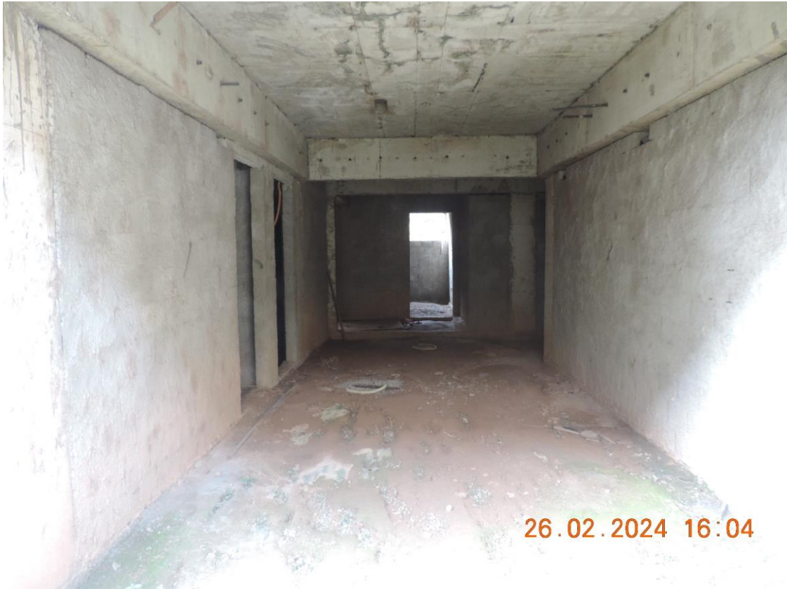
FOTO Nº 21 – PAVIMENTO TERREO DA EDIFICAÇÃO, VISTA PARCIAL
