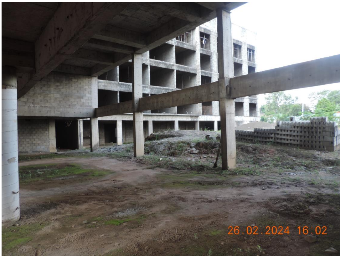
FOTO N° 18 – PAVIMENTO TERREO DA EDIFICAÇÃO, VISTA PARCIAL
