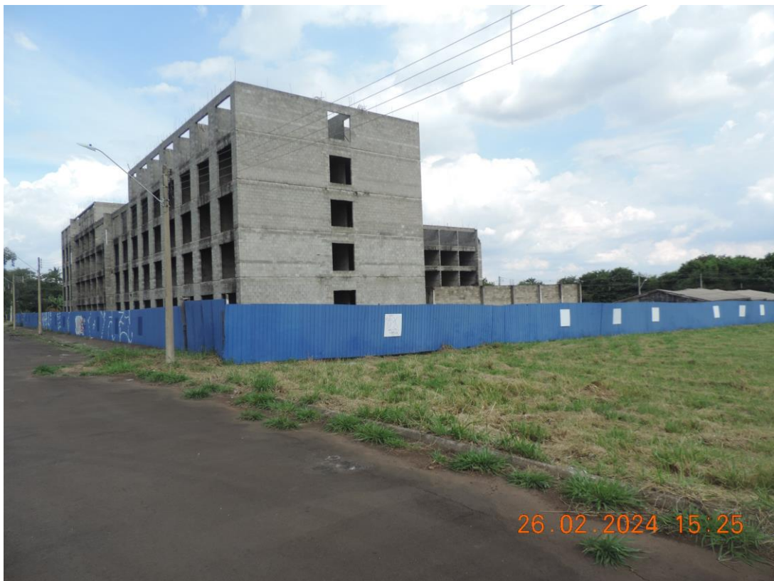
FOTO N° 02 – VISTA EXTERNA DO IMÓVEL, A PARTIR DA RUA IMP. GIULIANO
