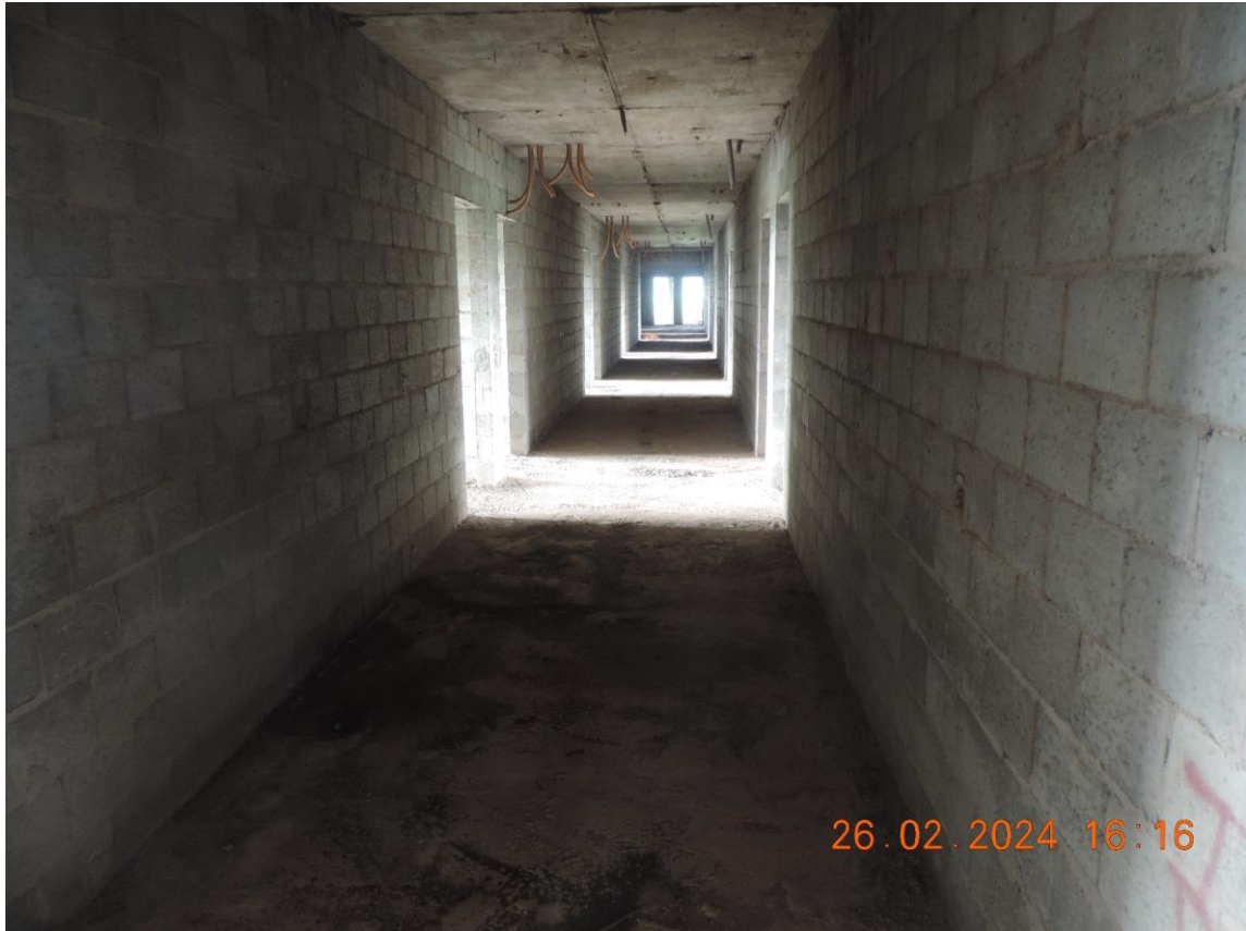
FOTO Nº 45 – 4º PAVIMENTO DA EDIFICAÇÃO, VISTA PARCIAL
