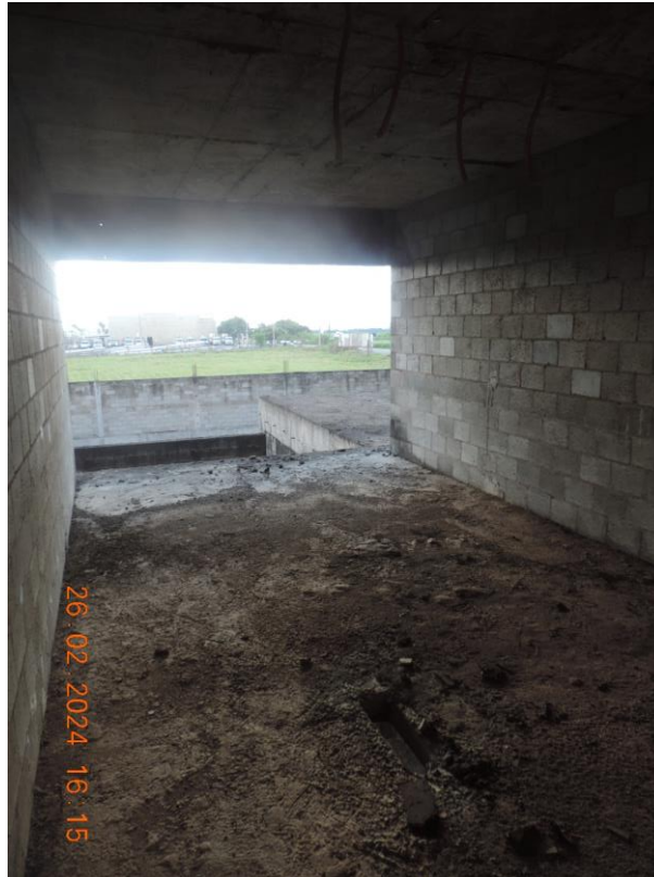
FOTO N° 37 – 2° PAVIMENTO DA EDIFICAÇÃO, VISTA PARCIAL
