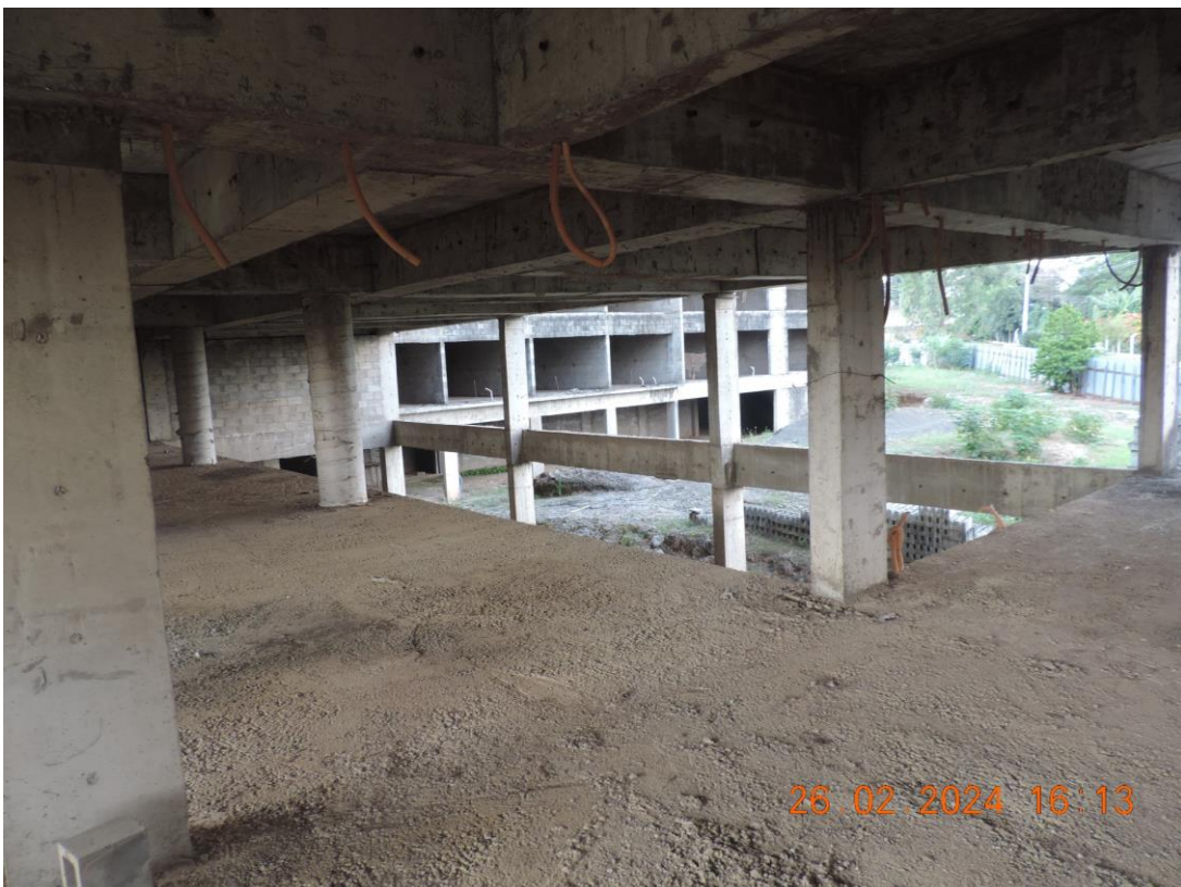
FOTO Nº 32 – 1º PAVIMENTO DA EDIFICAÇÃO, VISTA PARCIAL
