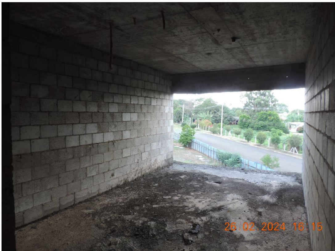
FOTO Nº 36 – 2º PAVIMENTO DA EDIFICAÇÃO, VISTA PARCIAL
