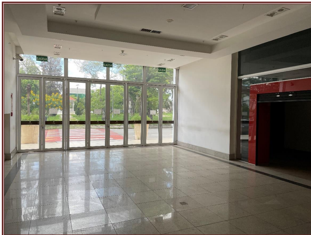
Foto nº 06: Vista geral do acesso ao pavimento térreo pela Praça Pio XII.
