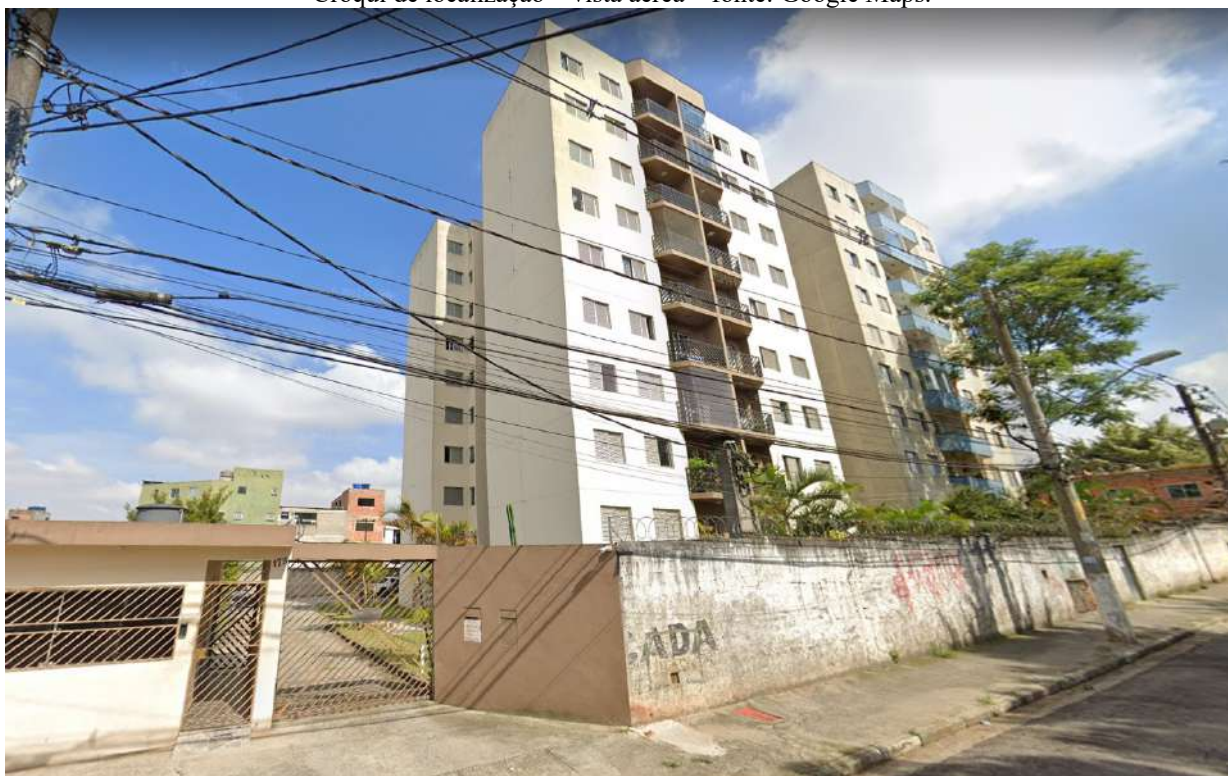
Figura 02: Identificação do local periciado - Fachada lateral
