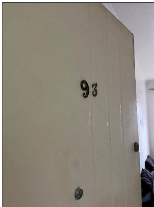
Foto 06 – Entrada do apartamento
