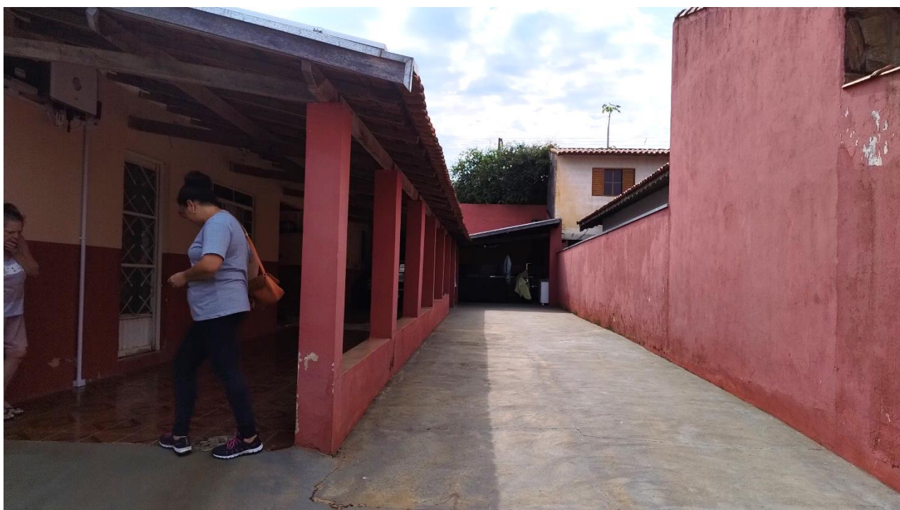
Foto 06 – Outra vista do recuo lateral, acesso aos fundos
