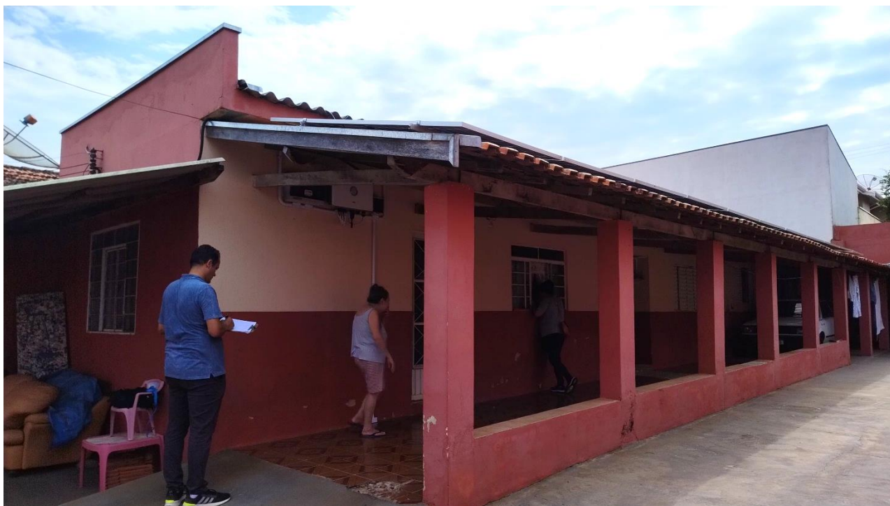
Foto 07 – Vista geral da construção
