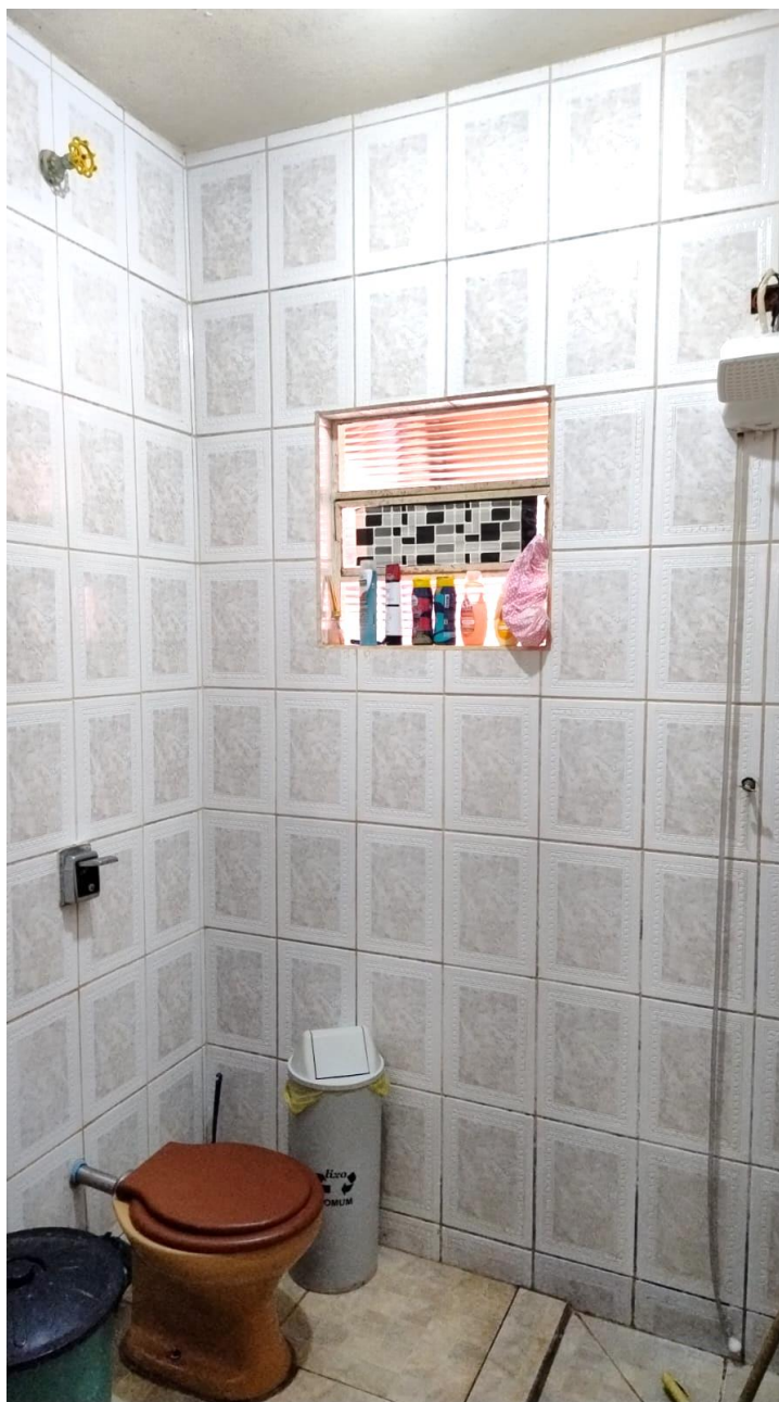
Foto 14 – Vista do banheiro geral
