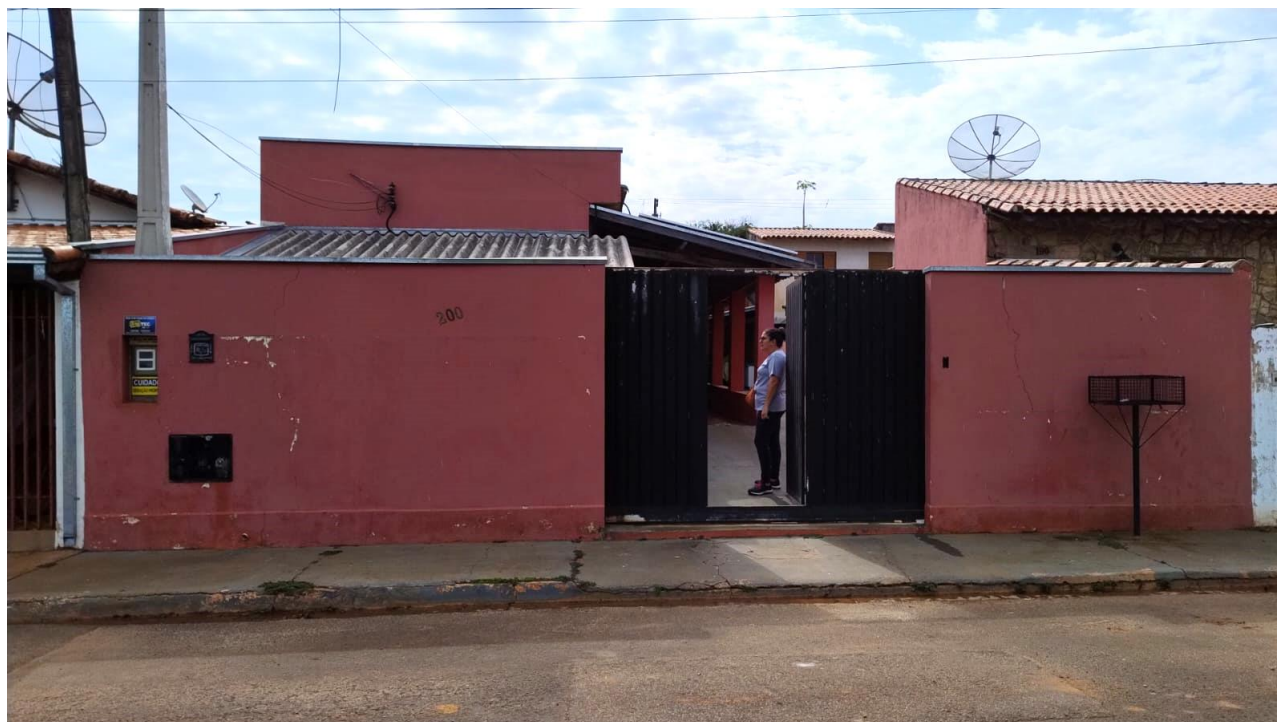
Foto 03 – Vista da fachada do avaliando
