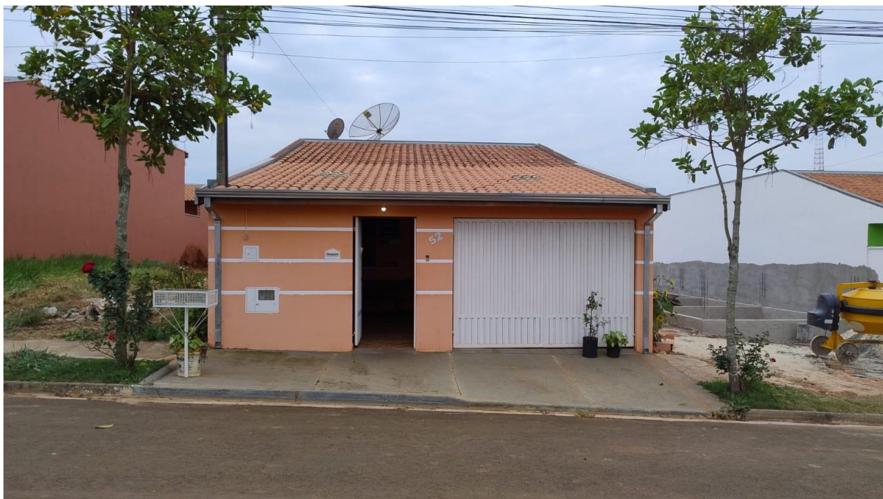
Foto 03 – Vista da fachada do avaliando
