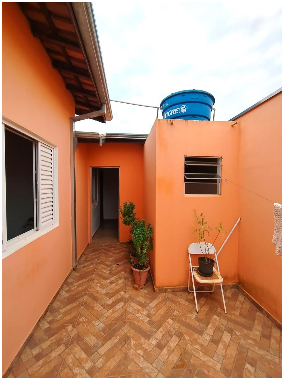
Foto 17 – Vista da fachada da edícula
