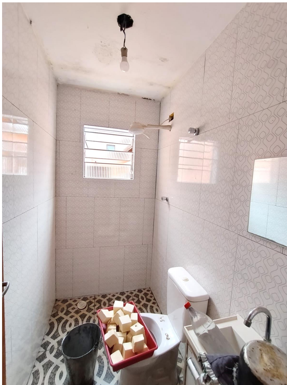
Foto 19 – Vista do banheiro da
