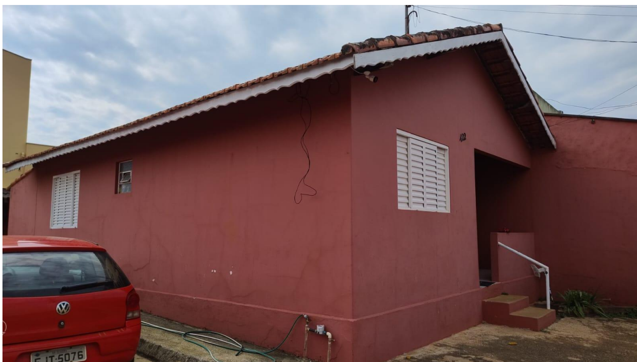
Foto 08 – Vista geral da casa principal
