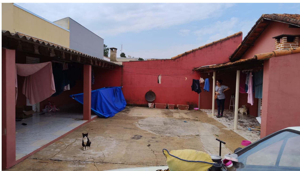
Foto 15 – Vista geral dos fundos
