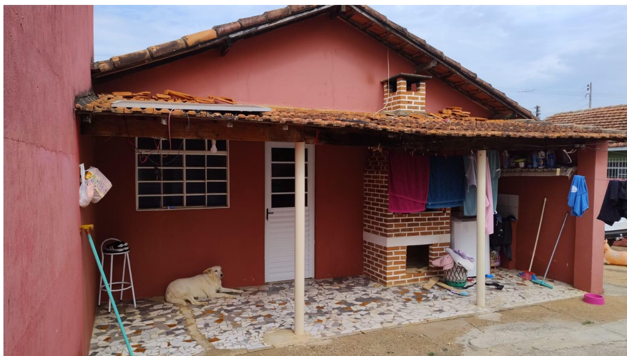
Foto 14 – Vista da fachada dos fundos
