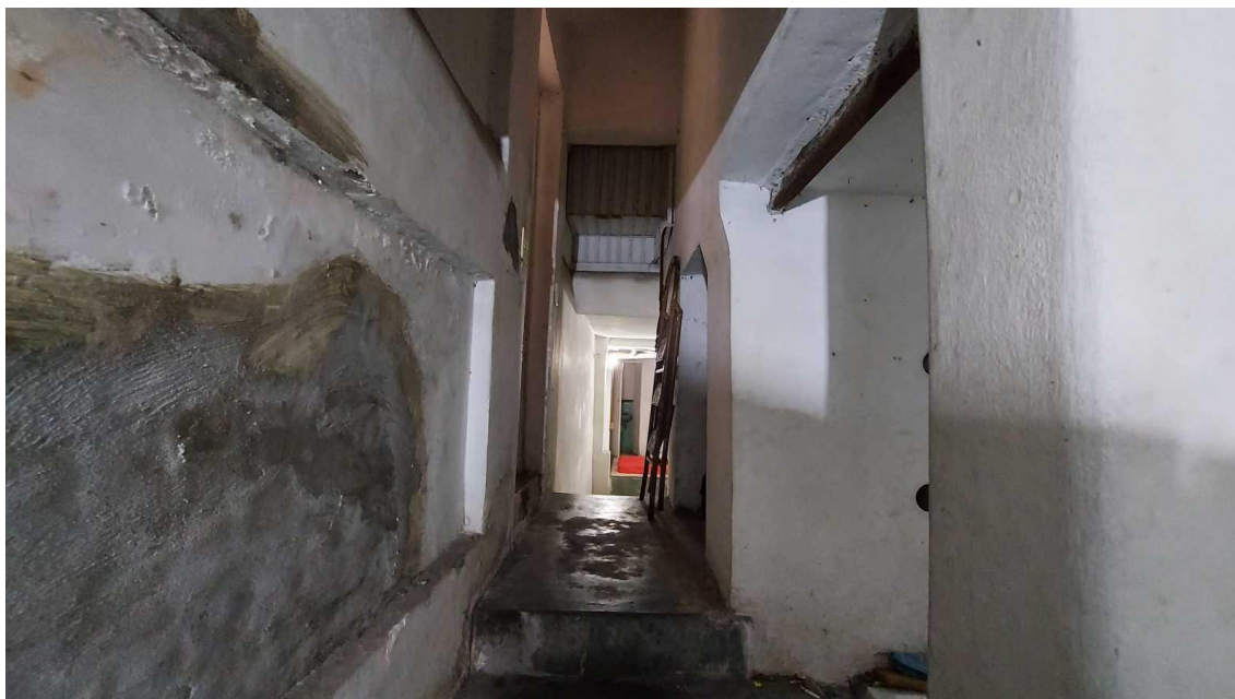
Foto 8: Escada de acesso as áreas do subsolo
