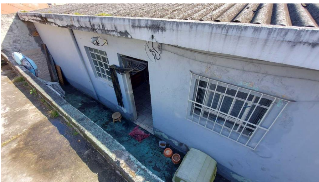
Foto 2: Vista da entrada da Casa da Frente
