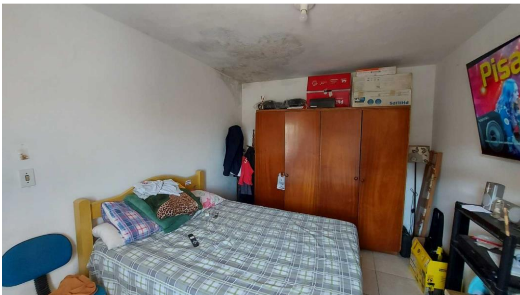
Foto 7: Quarto – Casa da Frente
