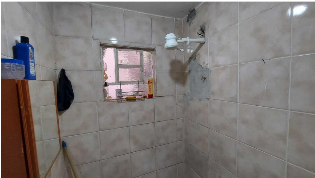
Foto 11: Banheiro – Casa da Frente
