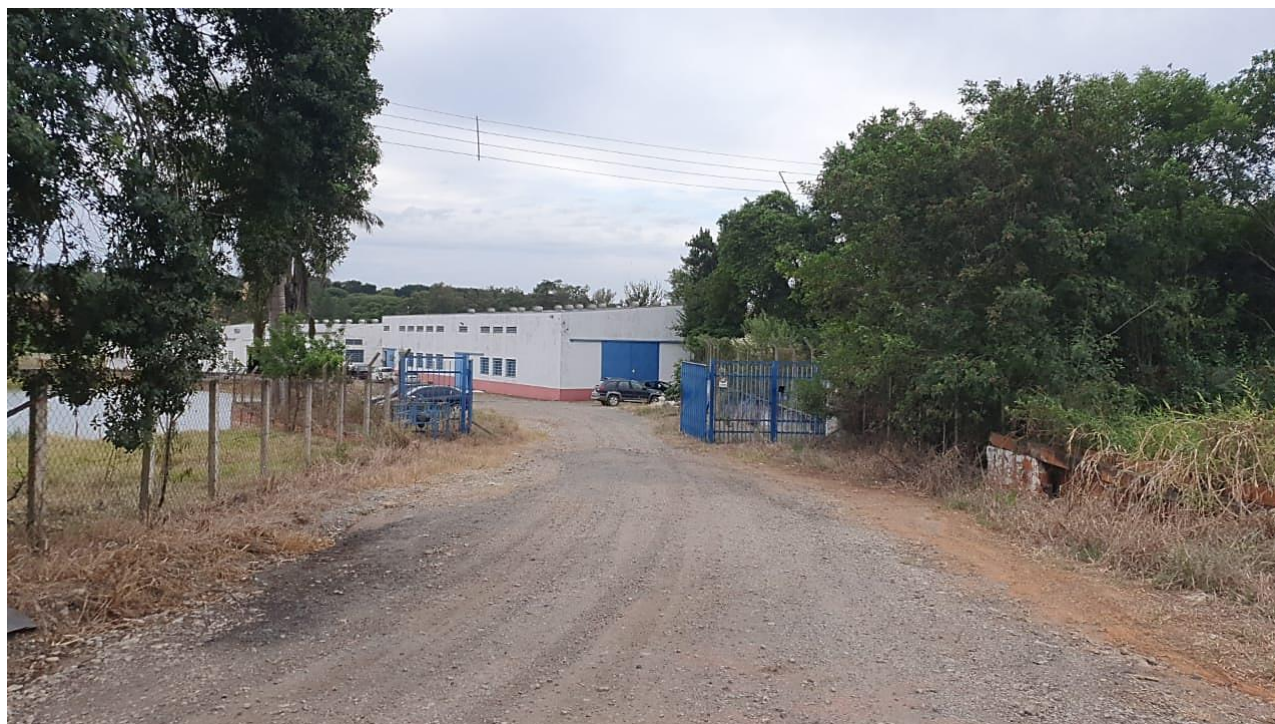
Foto 03 – Vista da fachada e acesso ao avaliando
