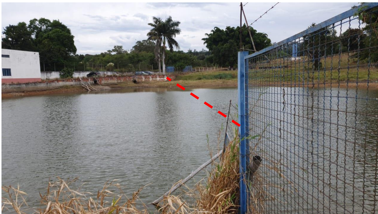
Foto 33 – Detalhe da cerca de divisa com imóvel vizinho e linha de divisa da propriedade avalianda situada a esquerda
