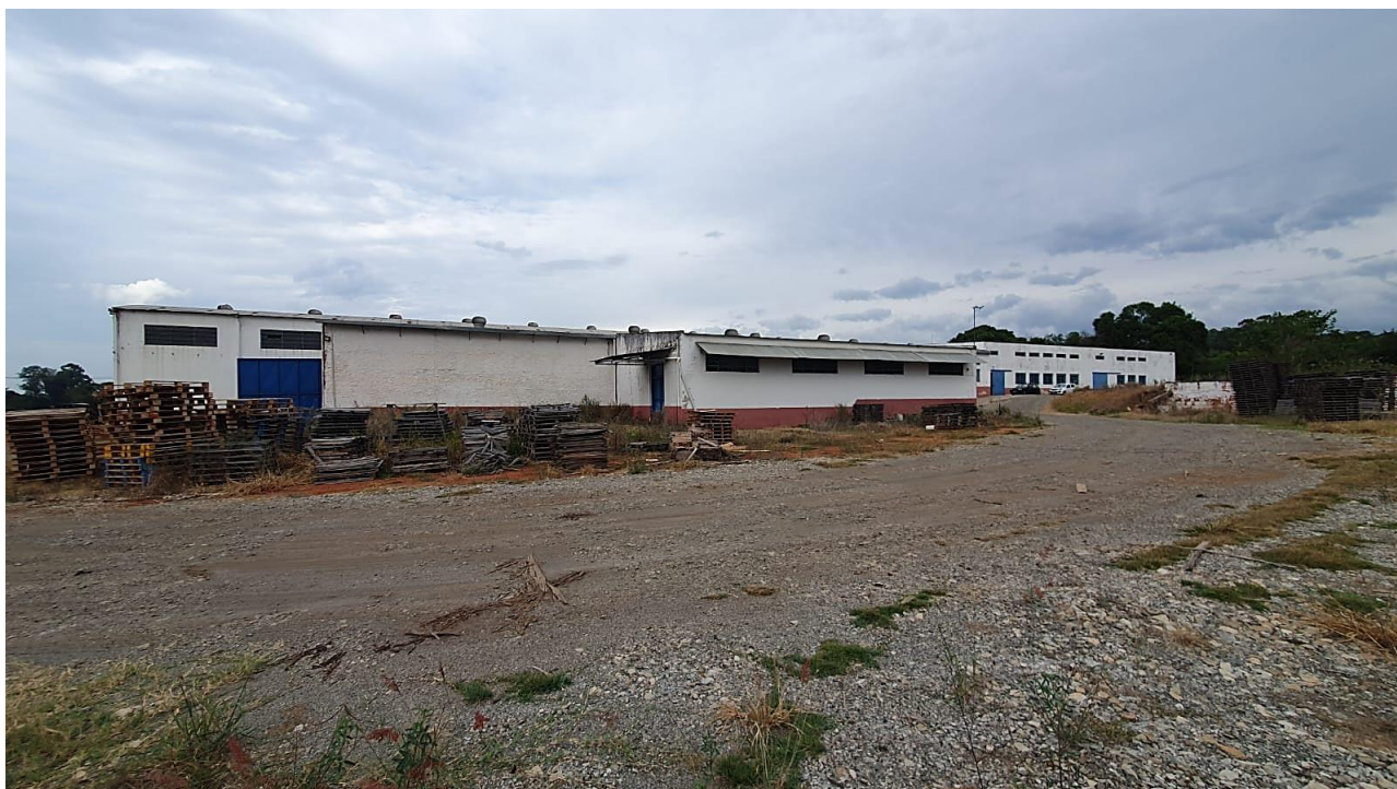
Foto 05 – Vista da fachada lateral dos galpões
