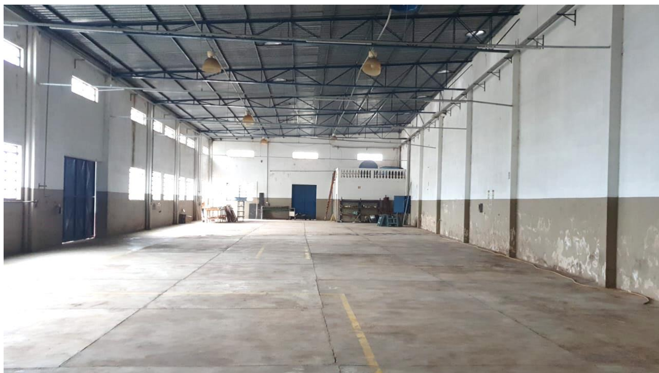
Foto 24 – Outra vista do galpão de ferramentas
