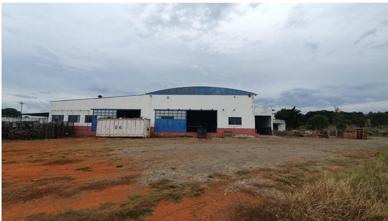
Foto 08 – Vista da fachada dos fundos dos galpões
