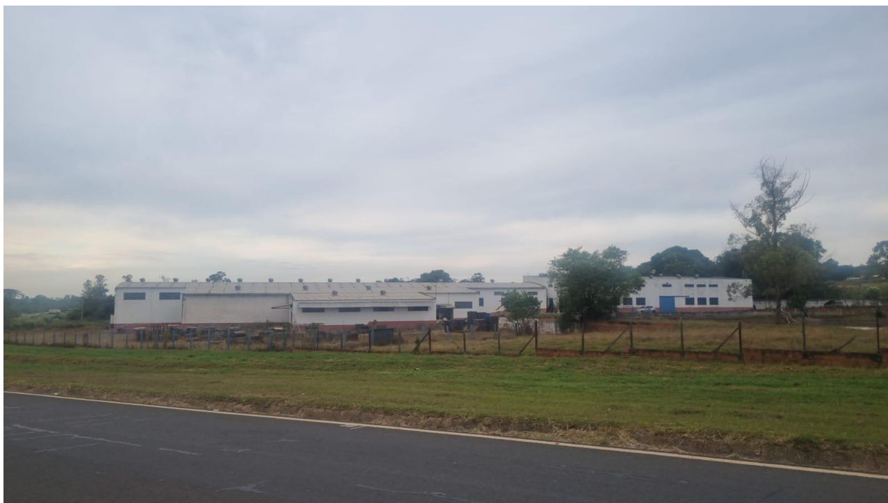
Foto 35 – Vista da fachada dos fundos (pela alça de acesso a Rod. Castelo Branco)
