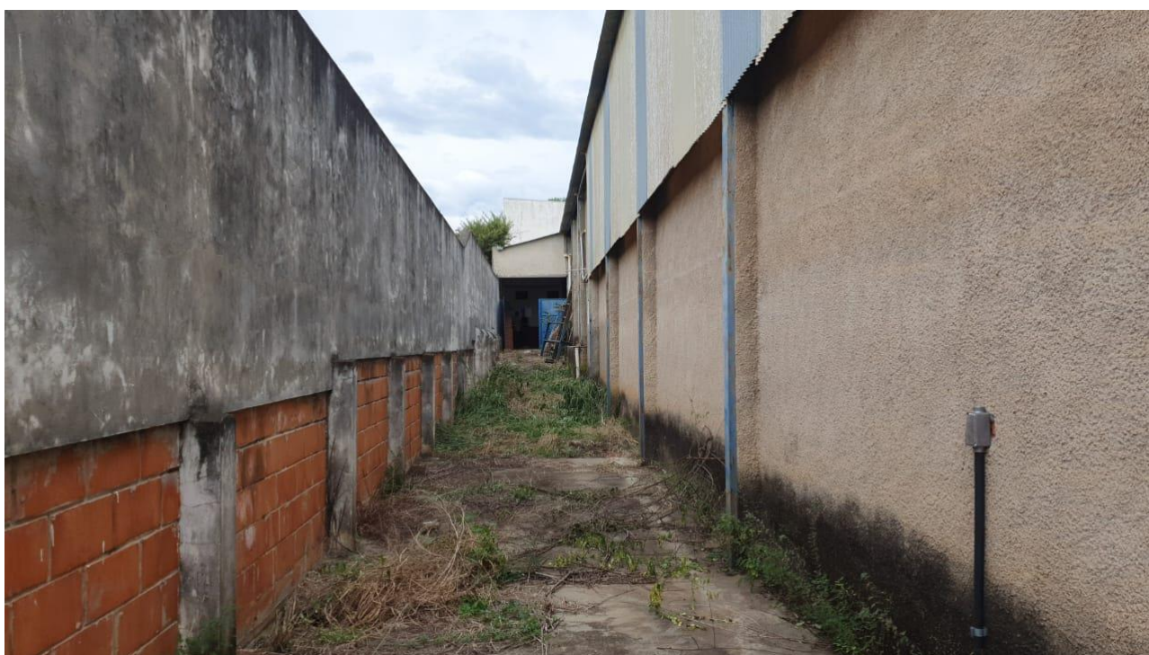
Foto 28 – Outra vista do corredor lateral junto ao muro de divisa
