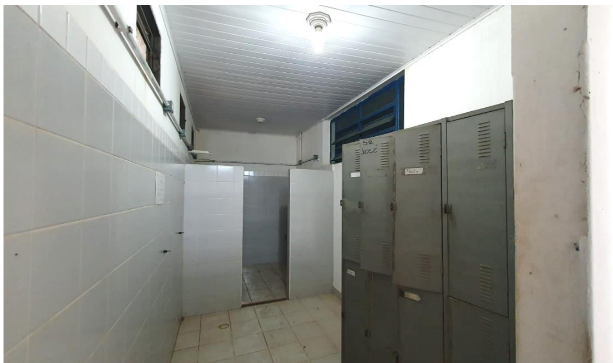
Foto 30 – Vista do vestiário
