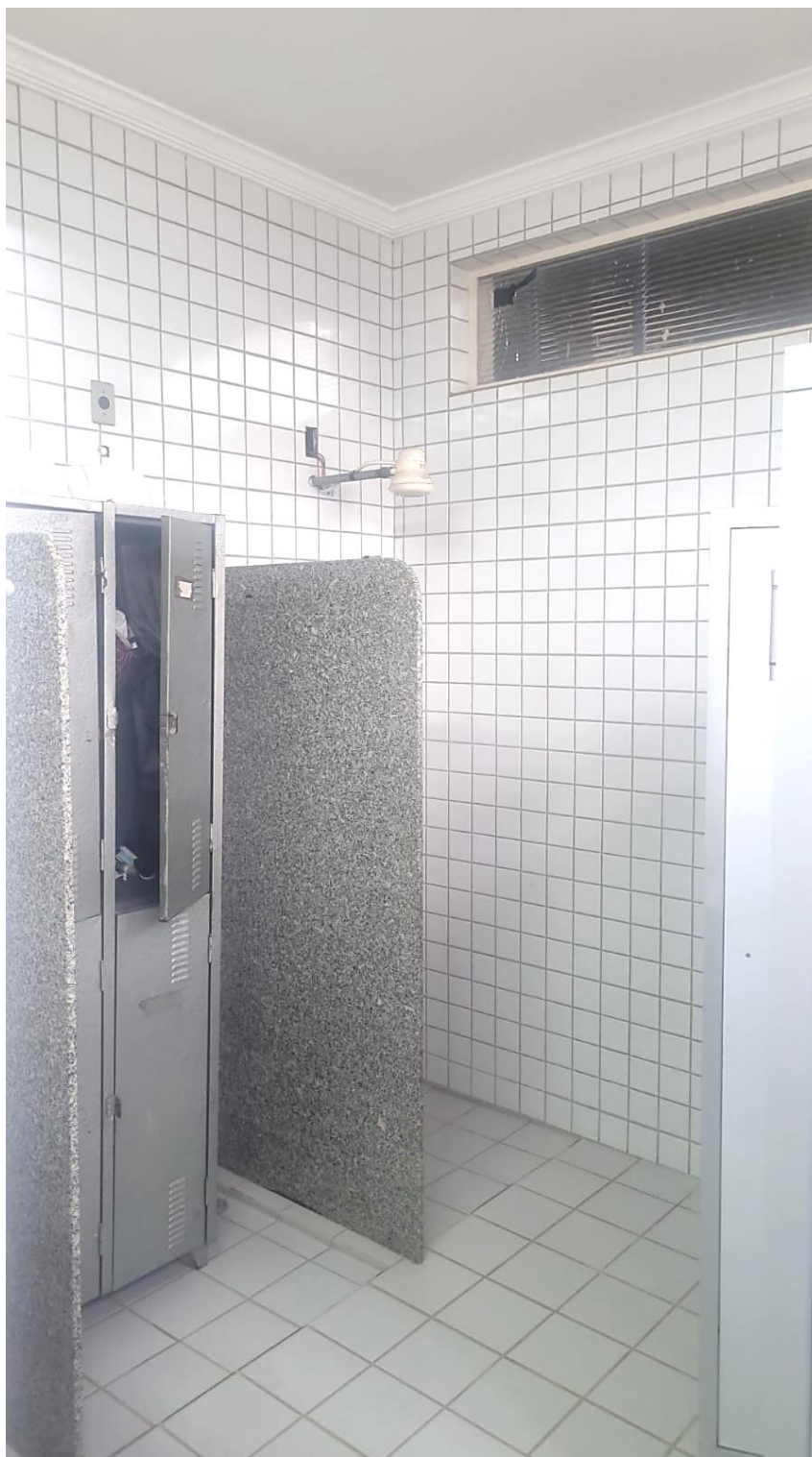
Foto 12 – Vista do banheiro feminino
