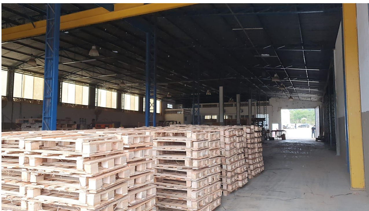
Foto 10 – Vista geral do galpão
