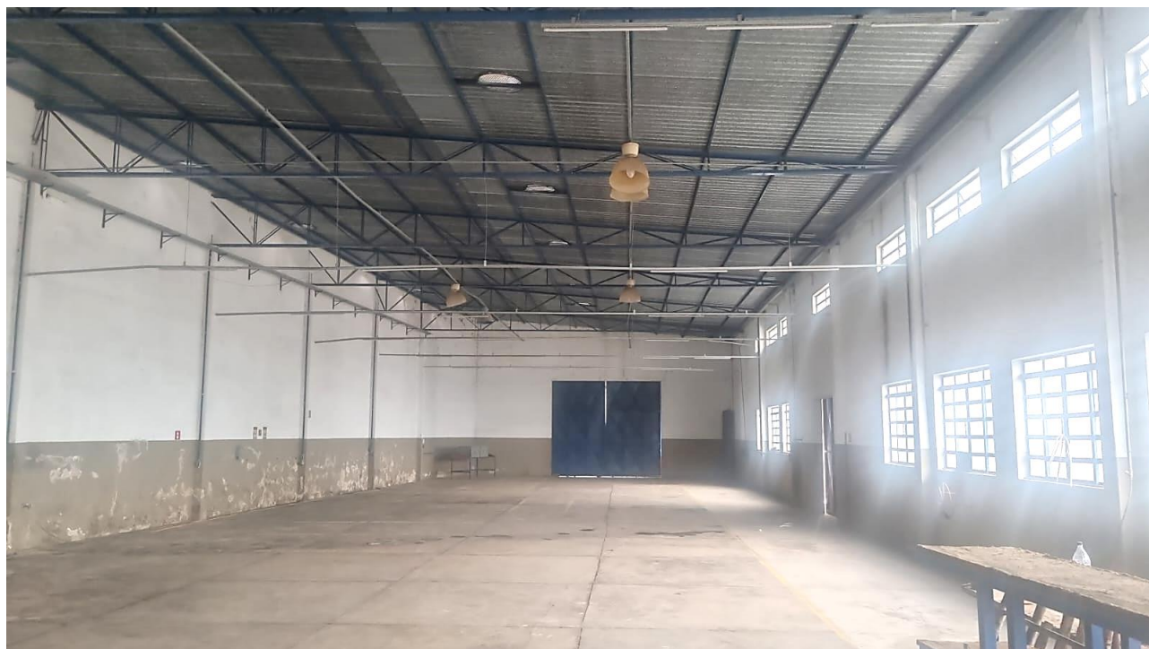
Foto 23 – Vista do galpão de ferramentas
