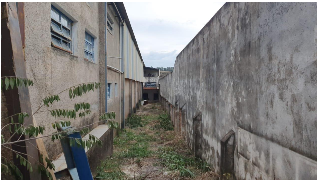
Foto 27 – Vista do corredor lateral junto ao muro de divisa
