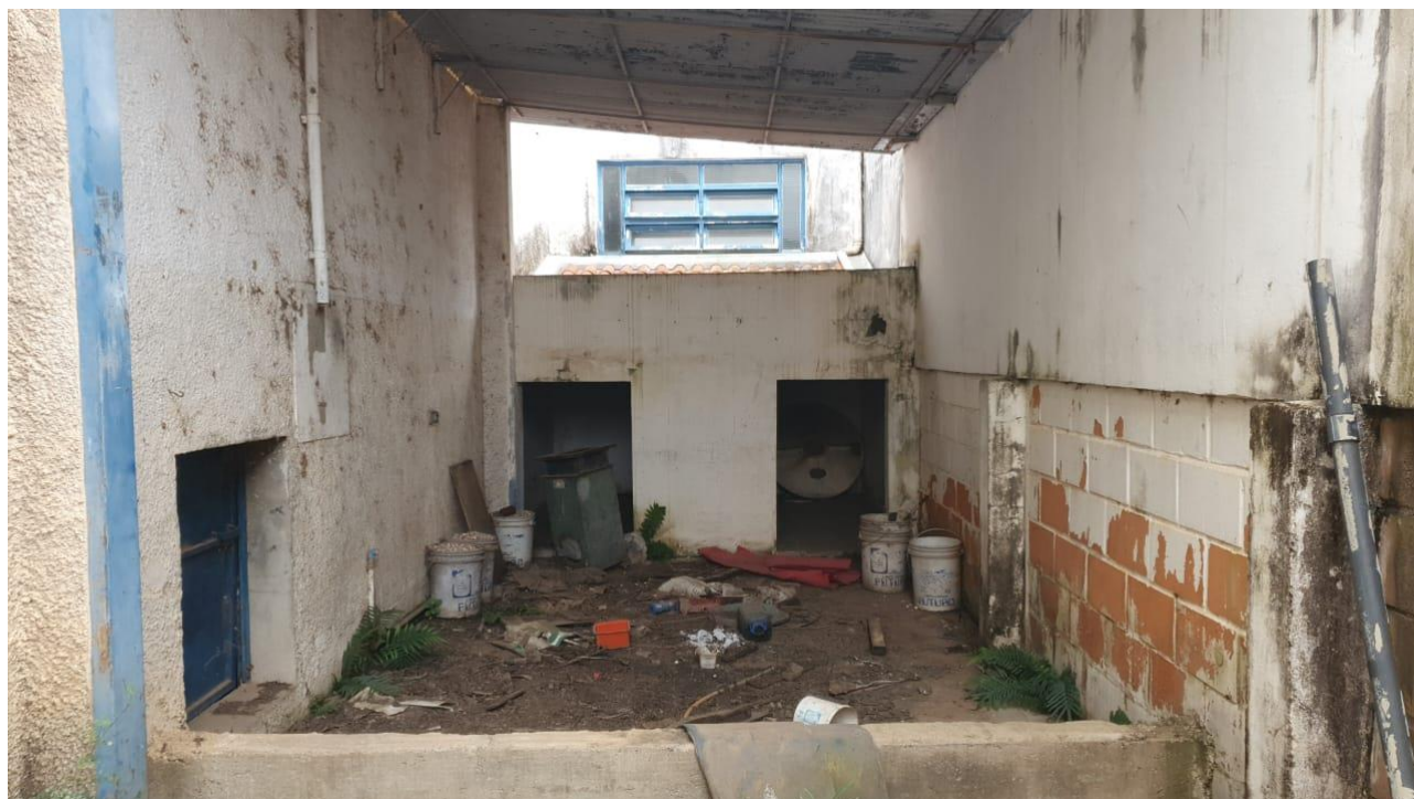
Foto 29 – Vista da casa de bombas
