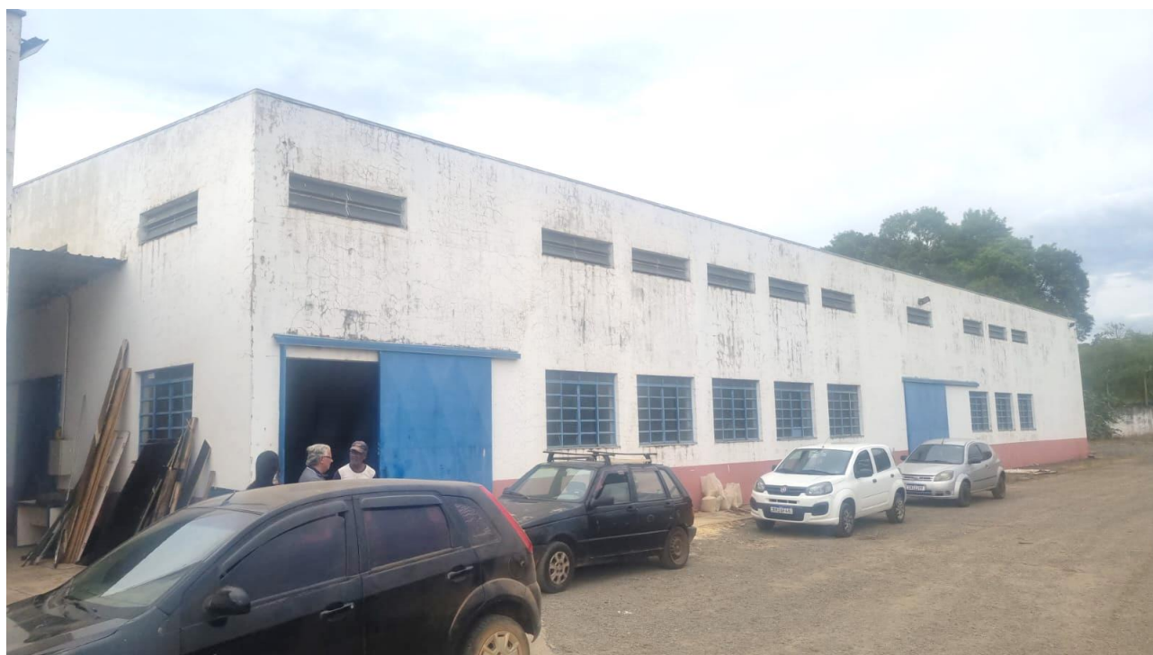
Foto 20 – Vista da fachada lateral do galpão de ferramentas
