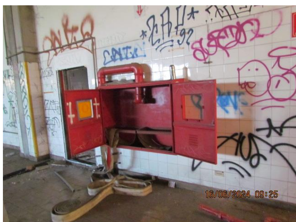
Vista de caixa de incêndio sem as peças metálicas (adaptador, esguicho e chave)
