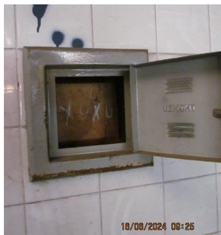
caixa de energia verificada sem fiação
