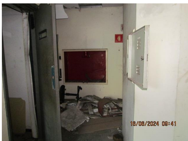
Porta do elevador no hall do andar térreo Placa metálica dos comandos retirada, e cabine depredada
