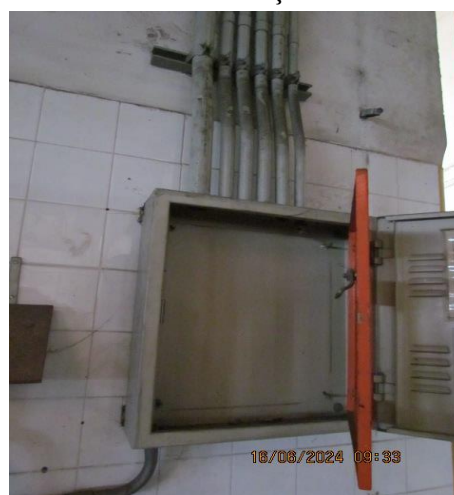
CGD – caixa geral de distribuição sem fio da instalação elétrica
