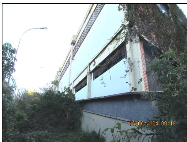
Cabine ao final da rampa com ferrugem avançada nas placas de fechamento e vegetação no entorno
