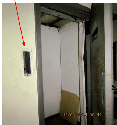
Porta do elevador no hall do andar térreo Placa metálica dos comandos retirada, e cabine depredada
