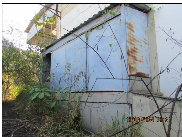
Cabine ao final da rampa com ferrugem avançada nas placas de fechamento e vegetação no entorno
