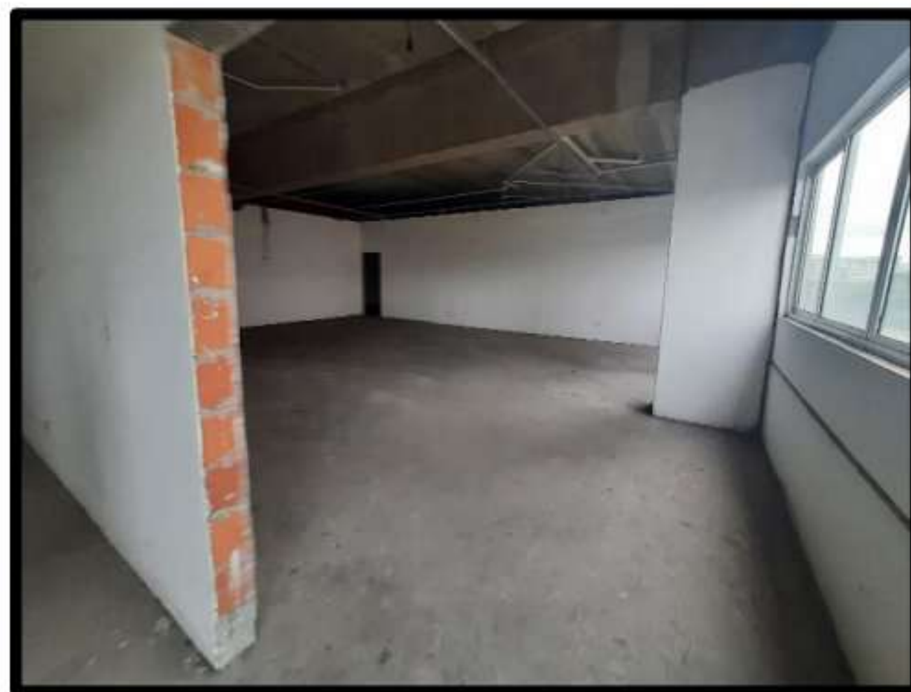
FOTO 24 - SALAS DO 3º PAVIMENTO
