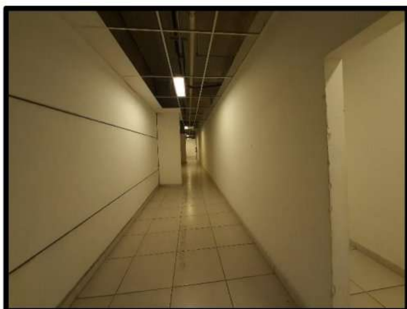
FOTO 19 - CORREDOR DE ACESSO ÀS SALAS DO 2º PAVIMENTO
