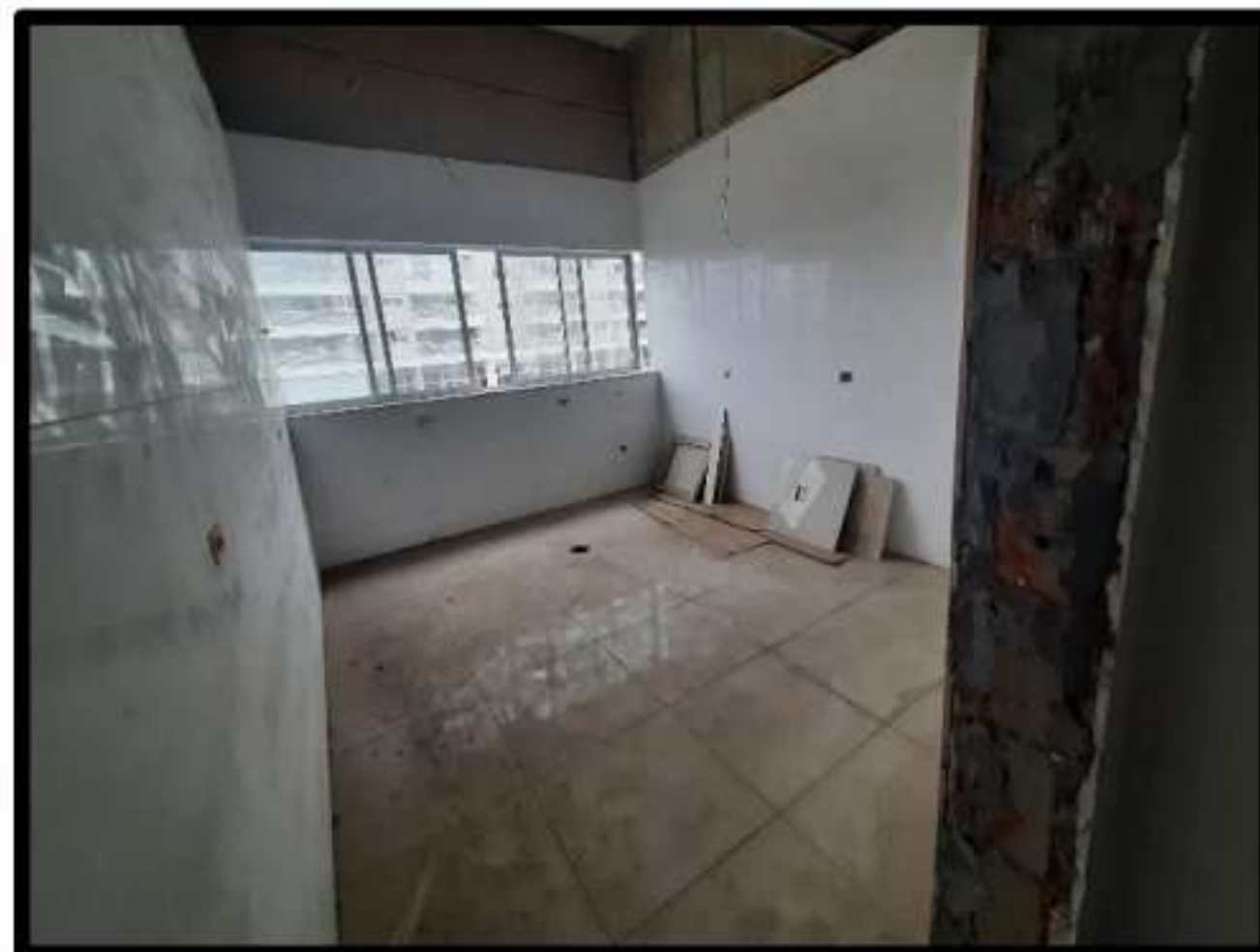
FOTO 28 - BANHEIROS DO 4º PAVIMENTO
