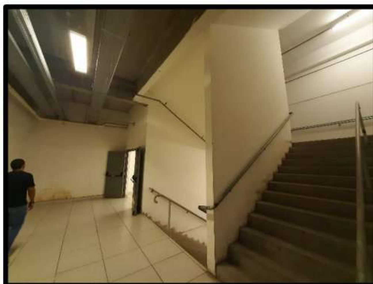
FOTO 18 - HALL DE ESCADAS
