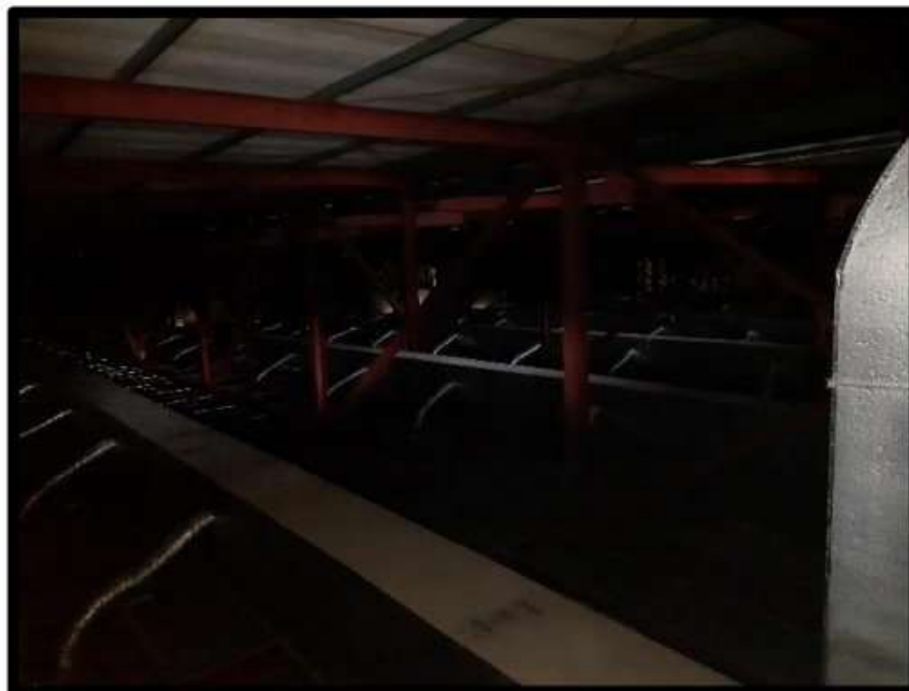
FOTO 42 - VIGAS E SISTEMA DE AR CONDICIONADO
