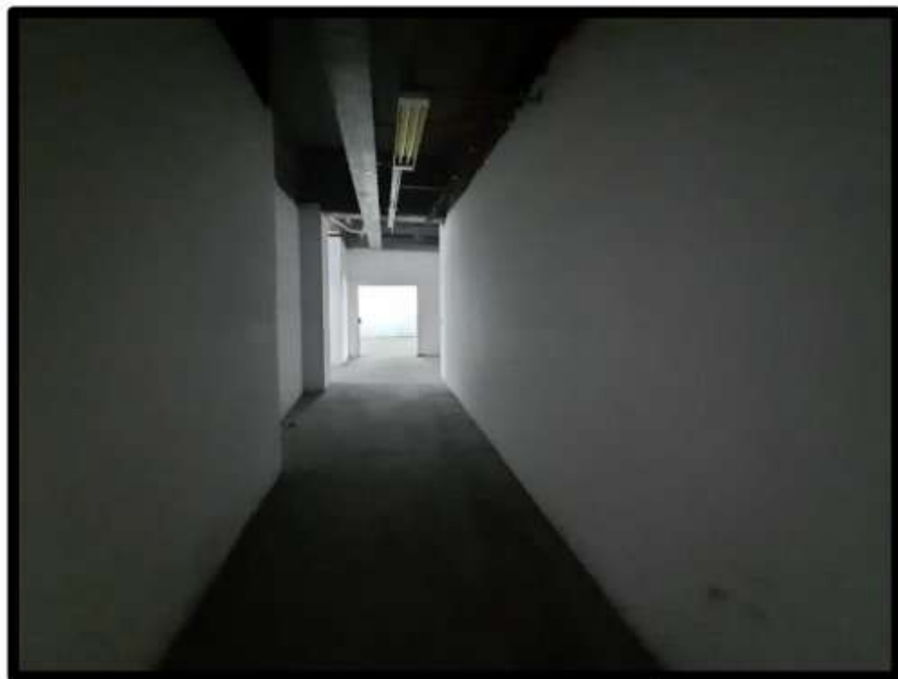
FOTO 21 - CORREDOR DE ACESSO ÀS SALAS DO 2º PAVIMENTO
