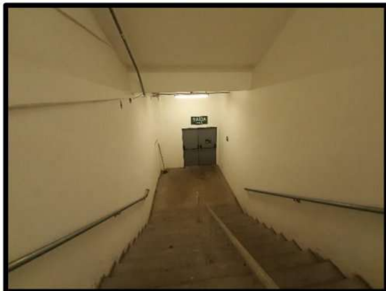
FOTO 15 - ESCADAS DE CIRCULÇÃO
