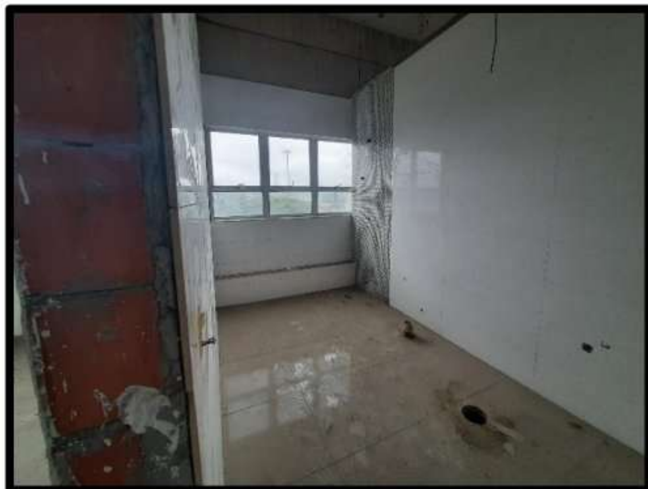
FOTO 27 - BANHEIROS DO 4º PAVIMENTO
