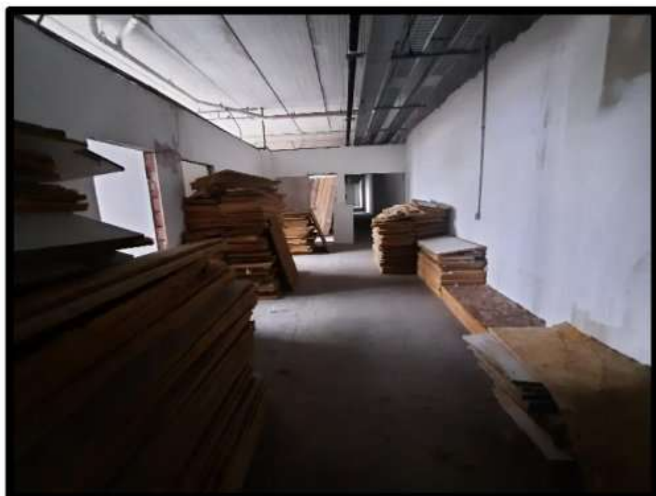
FOTO 25 - SALAS DO 4º PAVIMENTO
