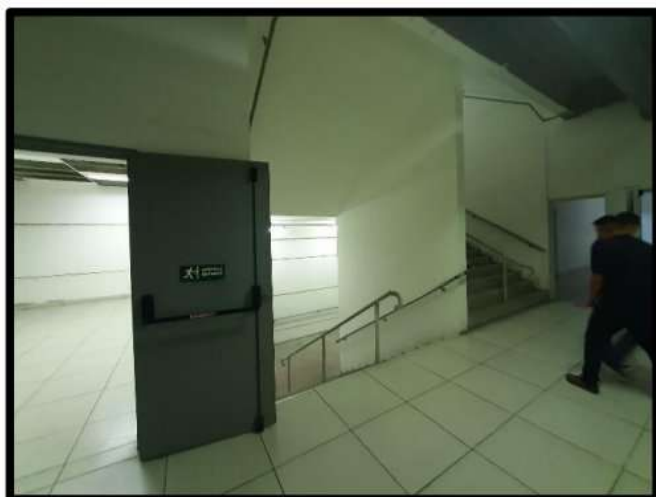
FOTO 17 - HALL DE ESCADAS
