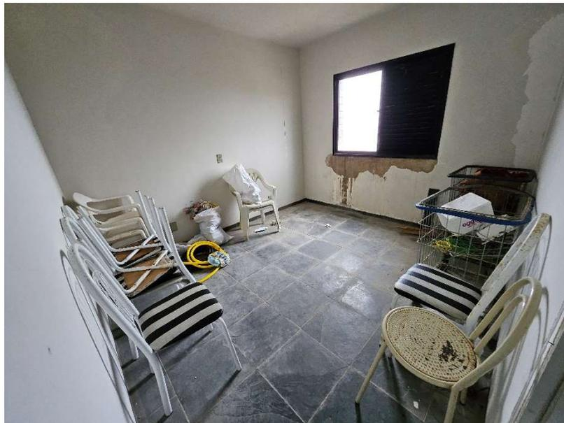
**Foto 30** – Vista do dormitório II do apartamento nº 42, imóvel avaliando, apresentando os seguintes padrões construtivos: Piso de ardósia, paredes e teto revestidos em pintura látex PVA sobre massa corrida; porta em madeira e esquadrias em alumínio.
