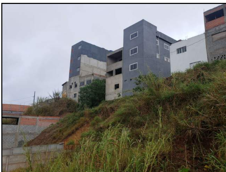
Foto 8 – Vista do fundo das edificações localizados na rua das Palmeiras
