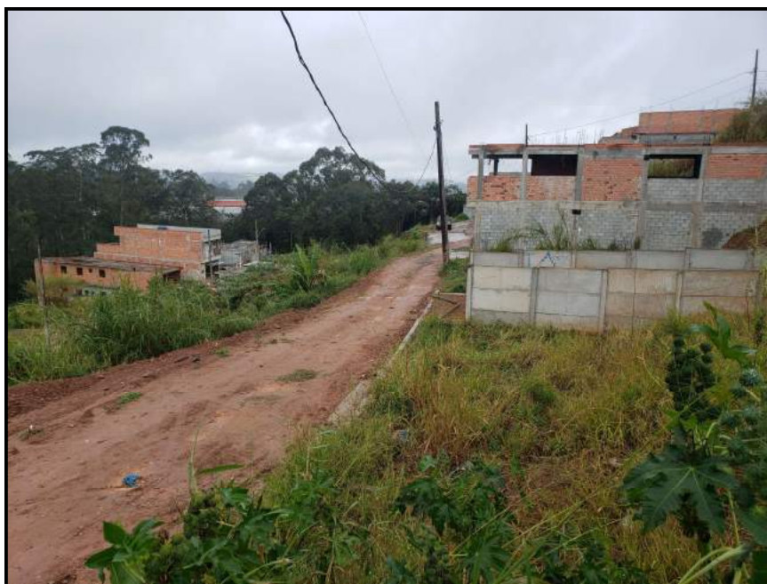
Foto 6 – edificações nas ruas internas
