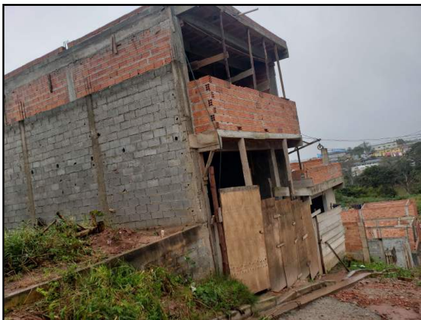
Foto 5 – edificações nas ruas internas
