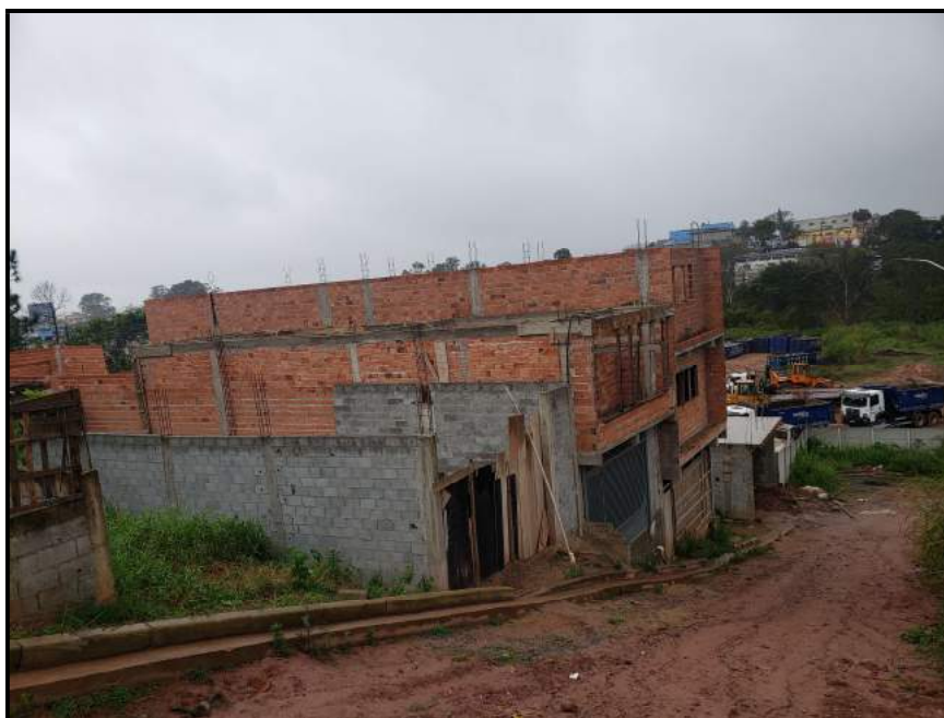
Foto 7 – edificações nas ruas internas
