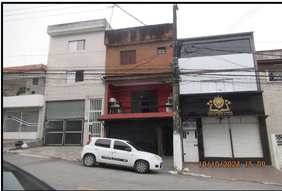
Foto nº 3: Vista do imóvel avaliando sob nº 181 da Rua Bororós.
