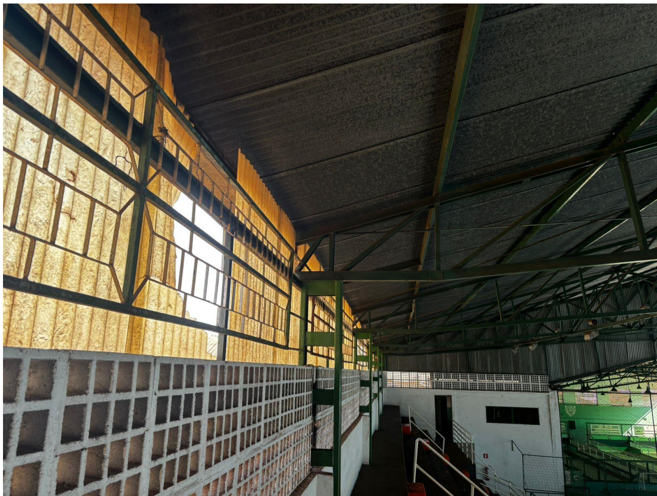
FOTO 02 – Vista parcial da lateral da cobertura avaliada. Nota-se os pilares metálicos
