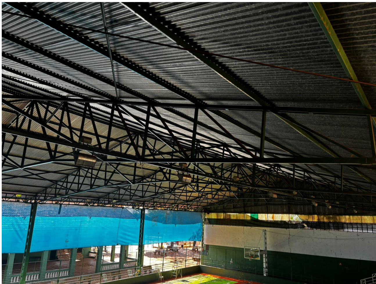
FOTO 03 – Vista parcial da estrutura da cobertura da quadra.
