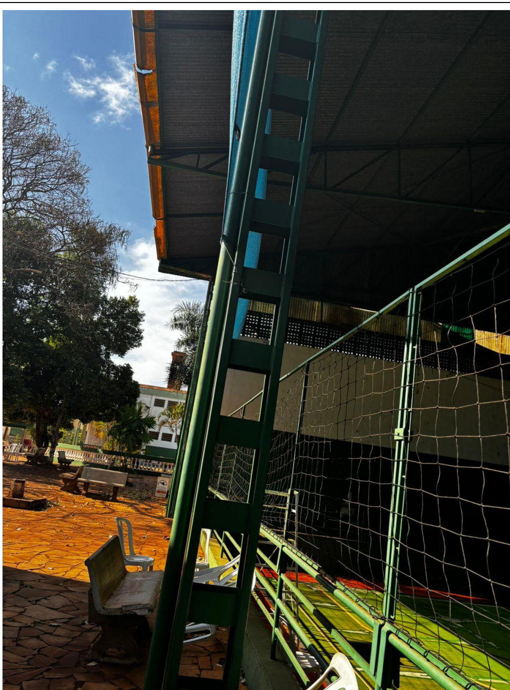
FOTO 06 – Vista parcial da lateral da cobertura. Nota-se o pilar metálico e o beiral
