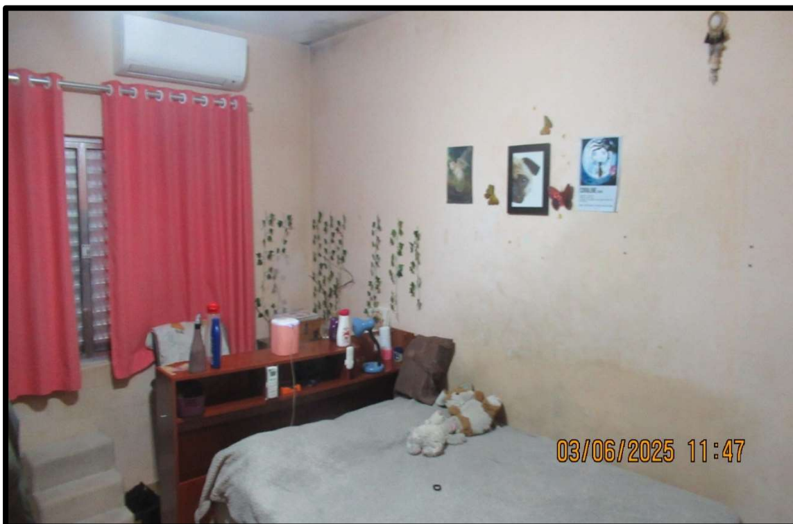
Foto nº 13: Vista de um dormitório. Suas principais características construtivas são: piso cerâmico, predes revestidas em massa corrida, pintadas em látex, forro em laje.
