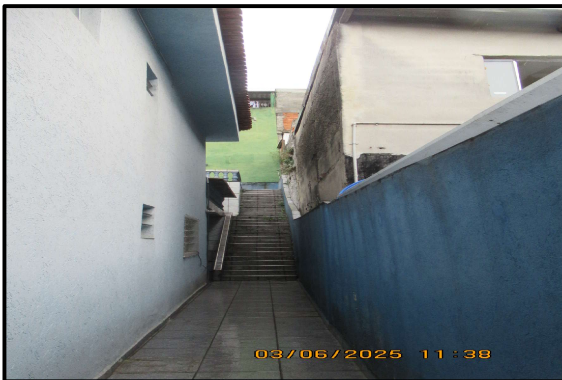
Foto nº 5: Vista do recuo lateral direito e acesso para o pavimento superior.
