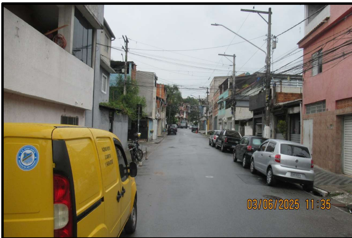
Foto nº 1: Vista da Avenida das Nações. O observador se encontra defronte ao imóvel avaliando, sob nº 155, olhando em direção à Rodovia dos Imigrantes.
