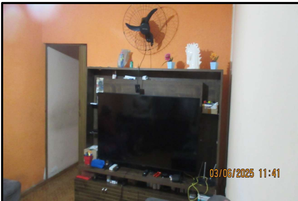
Foto nº 9: Vista da sala. Suas principais características construtivas são: piso cerâmico, predes revestidas em massa corrida, pintadas em látex, forro em laje.
