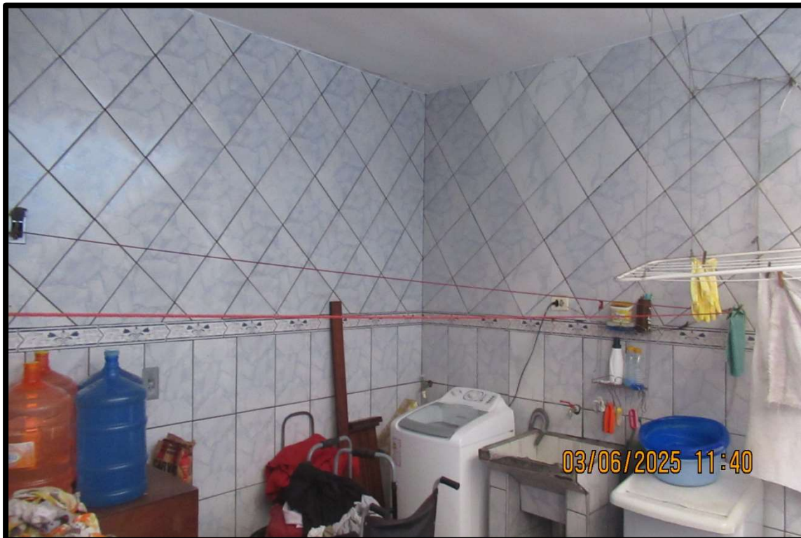
Foto nº 8: Vista da área de serviço. Suas principais características construtivas são: piso cerâmico, paredes azulejadas até o teto, forro em laje.
