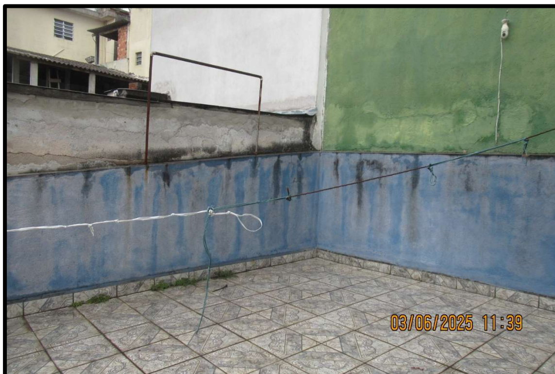
Foto nº 6: Vista dos fundos do imóvel.
