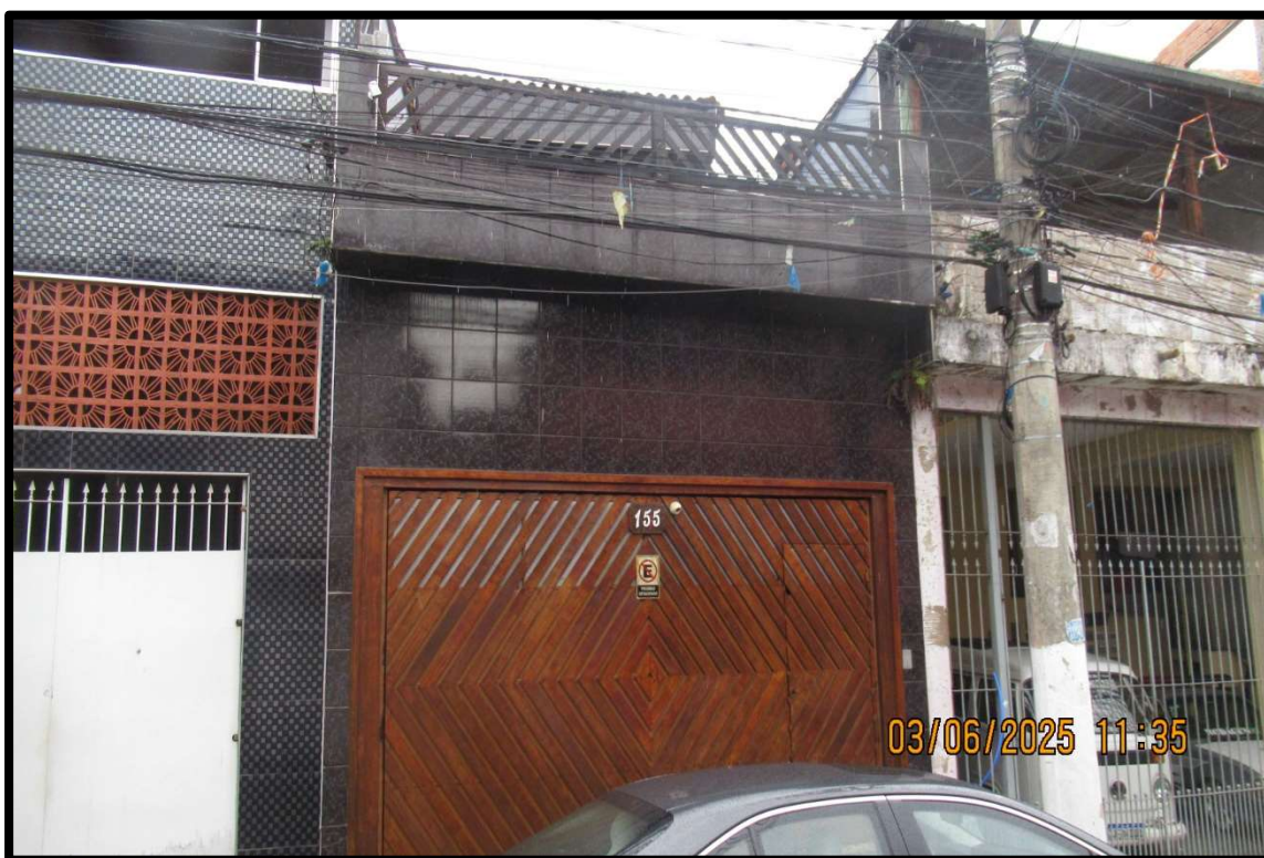
Foto nº 3: Vista da fachada do imóvel avaliando sob nº 155 da Avenida das Nações.
