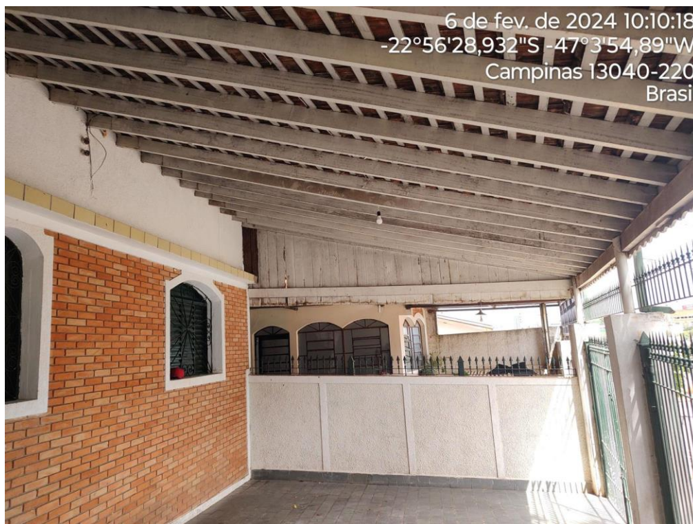
FOTO 05 – CASA I – GARAGEM
