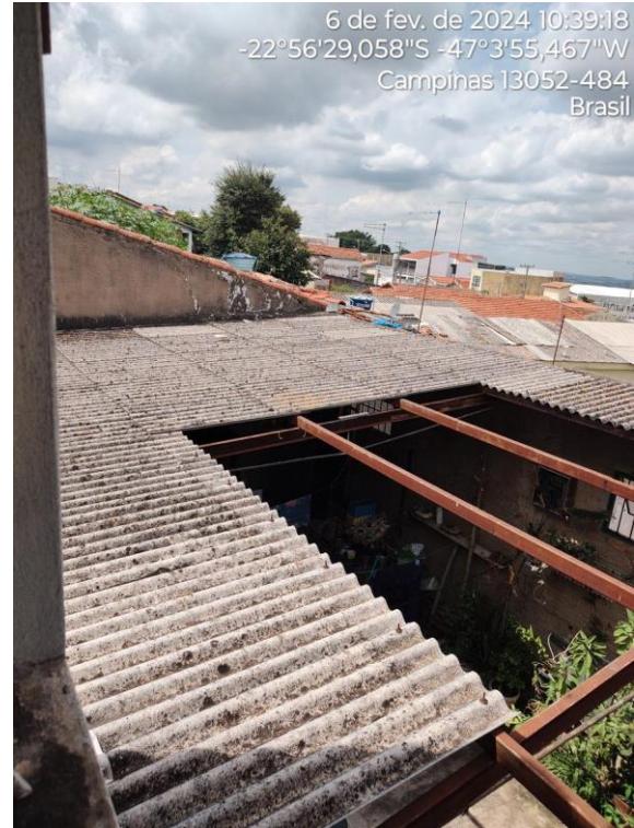
FOTO 35 – CASA II – VISTA DA ÁREA DE SERVIÇO
