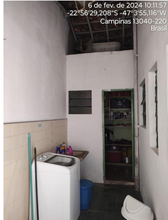
FOTO 08 – CASA I – ÁREA DE SERVIÇO
