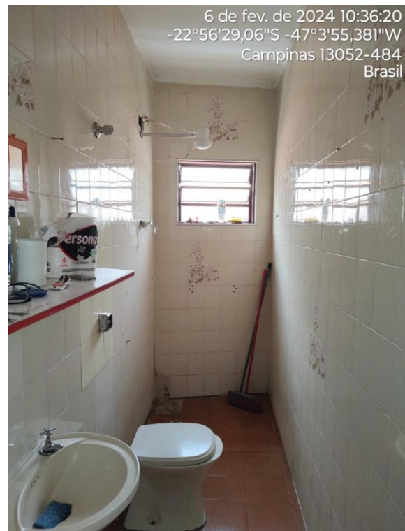
FOTO 39 – CASA II – BANHEIRO
