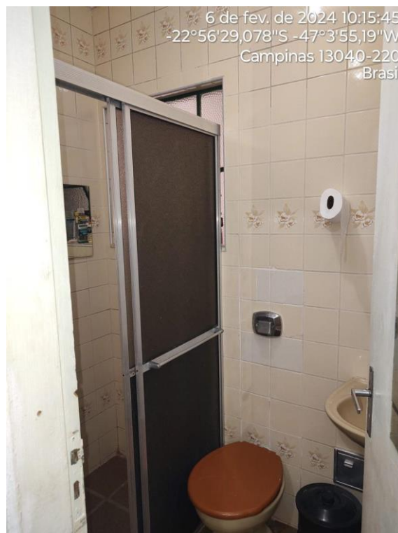
FOTO 17 – CASA I – BANHEIRO
