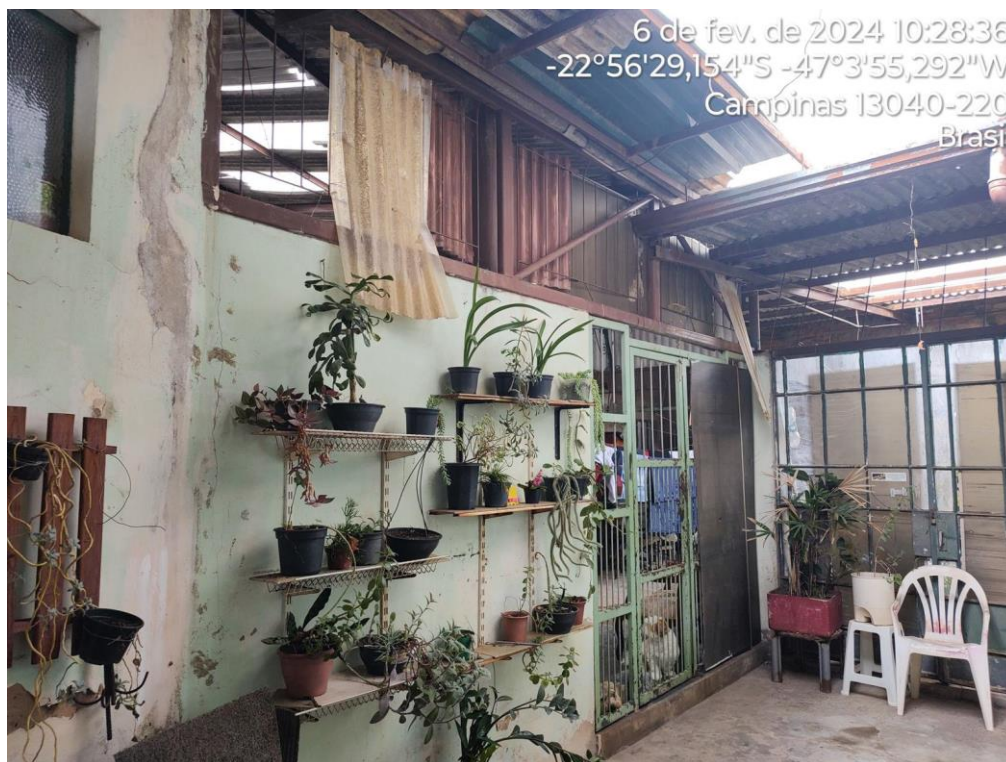
FOTO 42 – ACESSO CASA III
