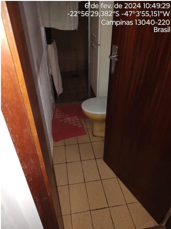
FOTO 54 – CASA III – BANHEIRO
