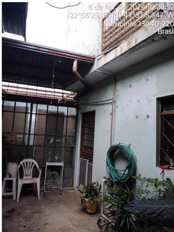
FOTO 32 – CASA II – ACESSO PAV. SUPERIOR
