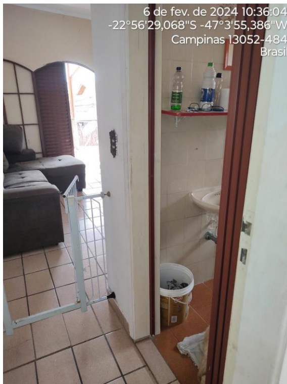
FOTO 38 – CASA II – BANHEIRO
