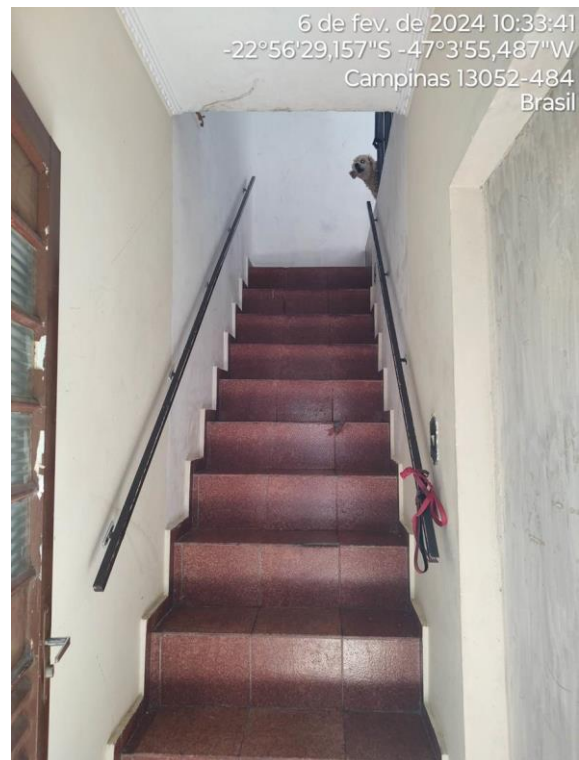
FOTO 33 – CASA II – ACESSO PAV. SUPERIOR
