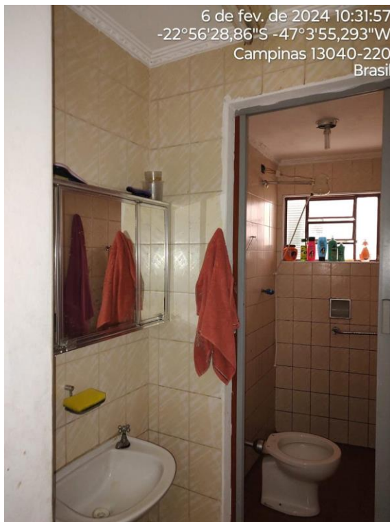
FOTO 28 – CASA II – BANHEIRO
