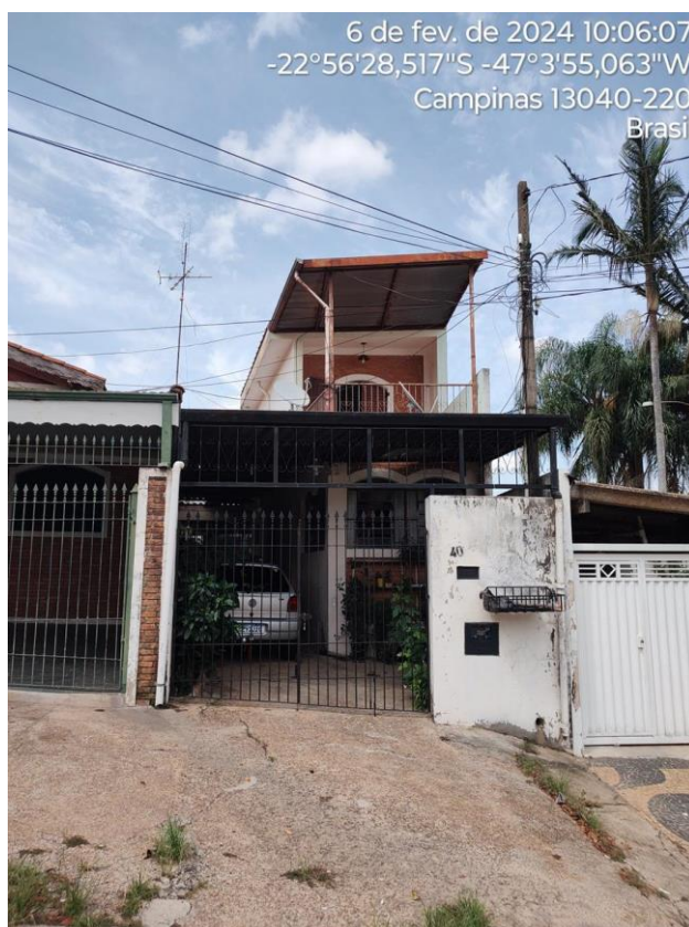
FOTO 21 – ACESSO CASA II E III
