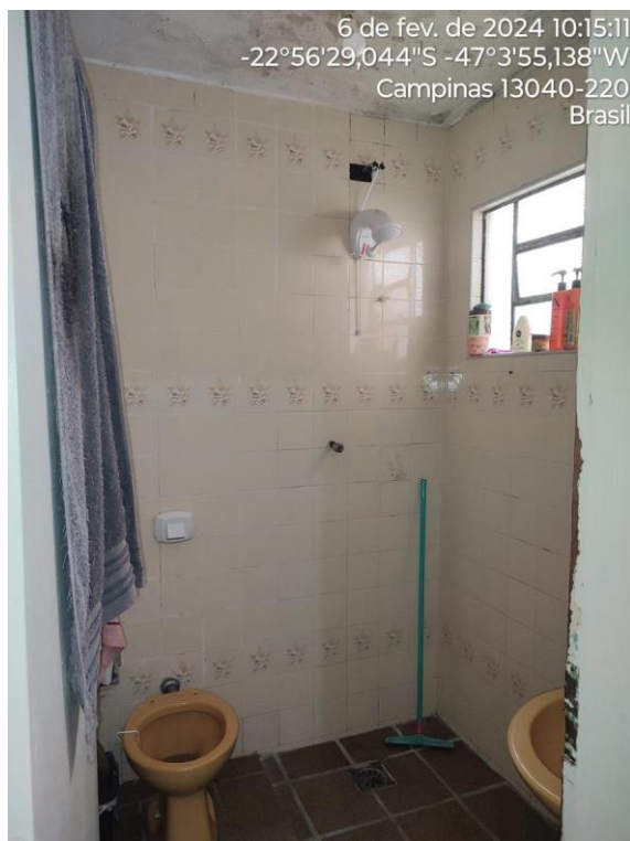
FOTO 19 – CASA I – BANHEIRO SUÍTE
